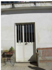
ingresso deposito esterno
