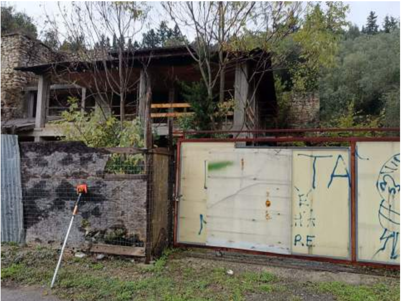
FOTO 24 VISTA FABBRICATO DA VIA MUGELLESE
