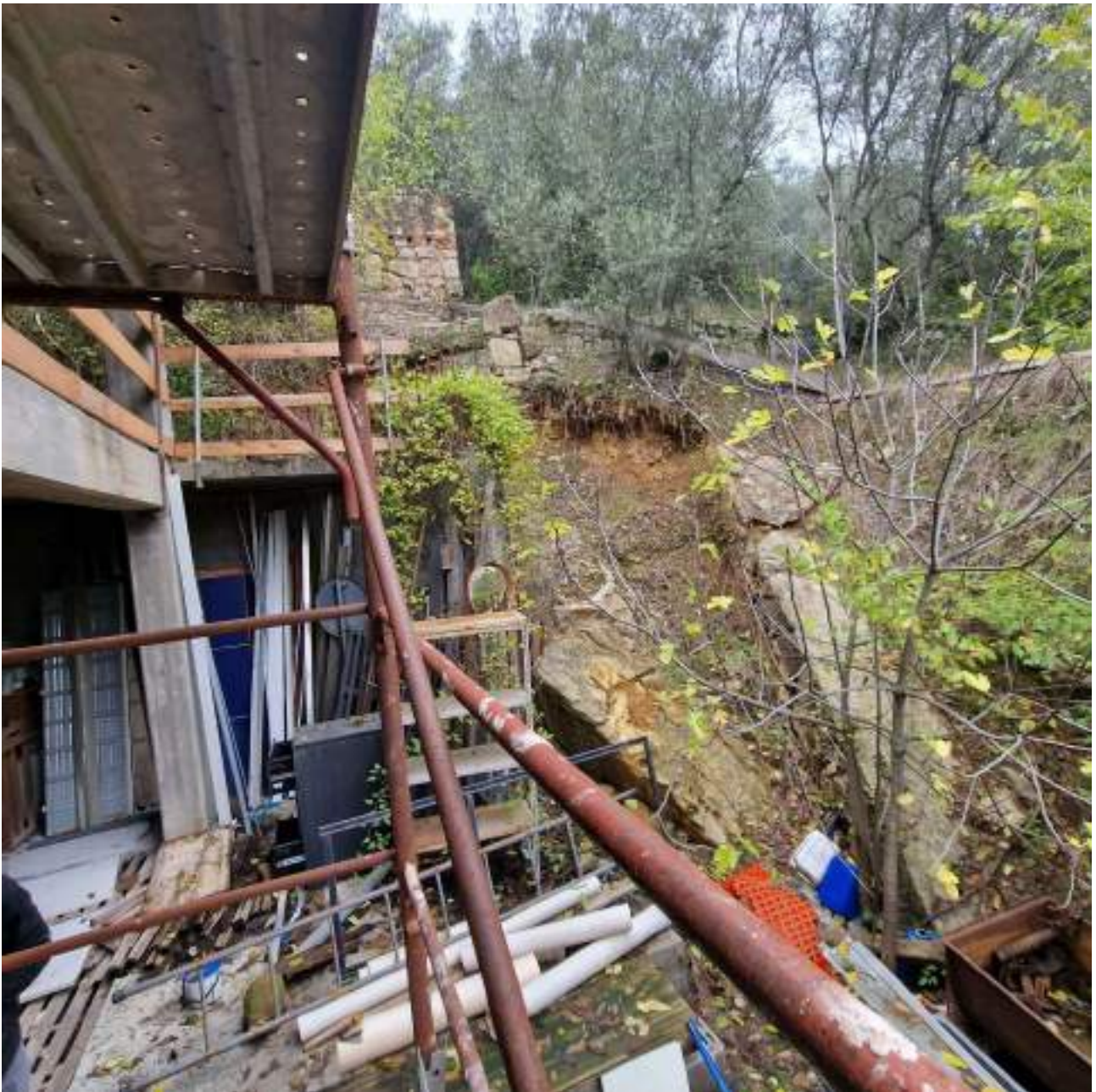
FOTO 16 STATO AREE ESTERNE (3° sopralluogo 02/11/2022)
