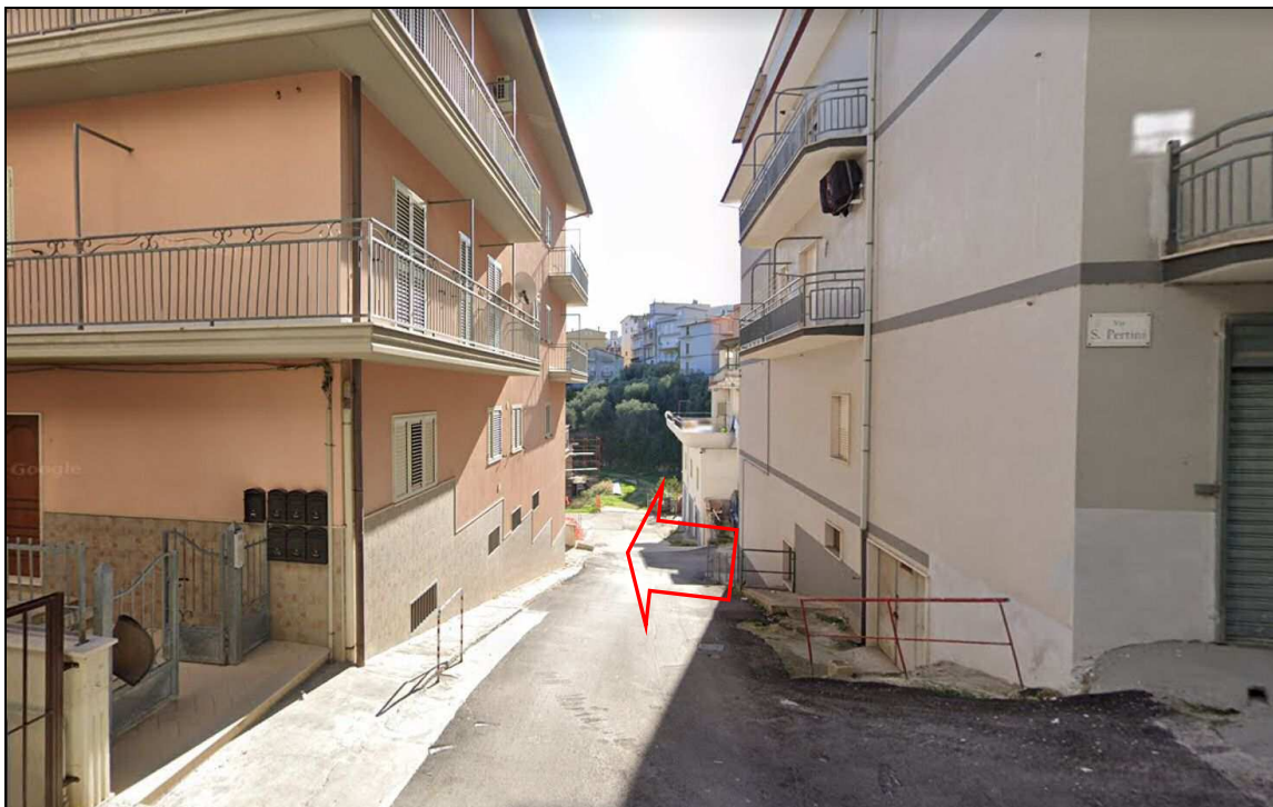
Foto B.2. Posizione, rispetto al fabbricato, della rampa che conduce ai box seminterrati.
