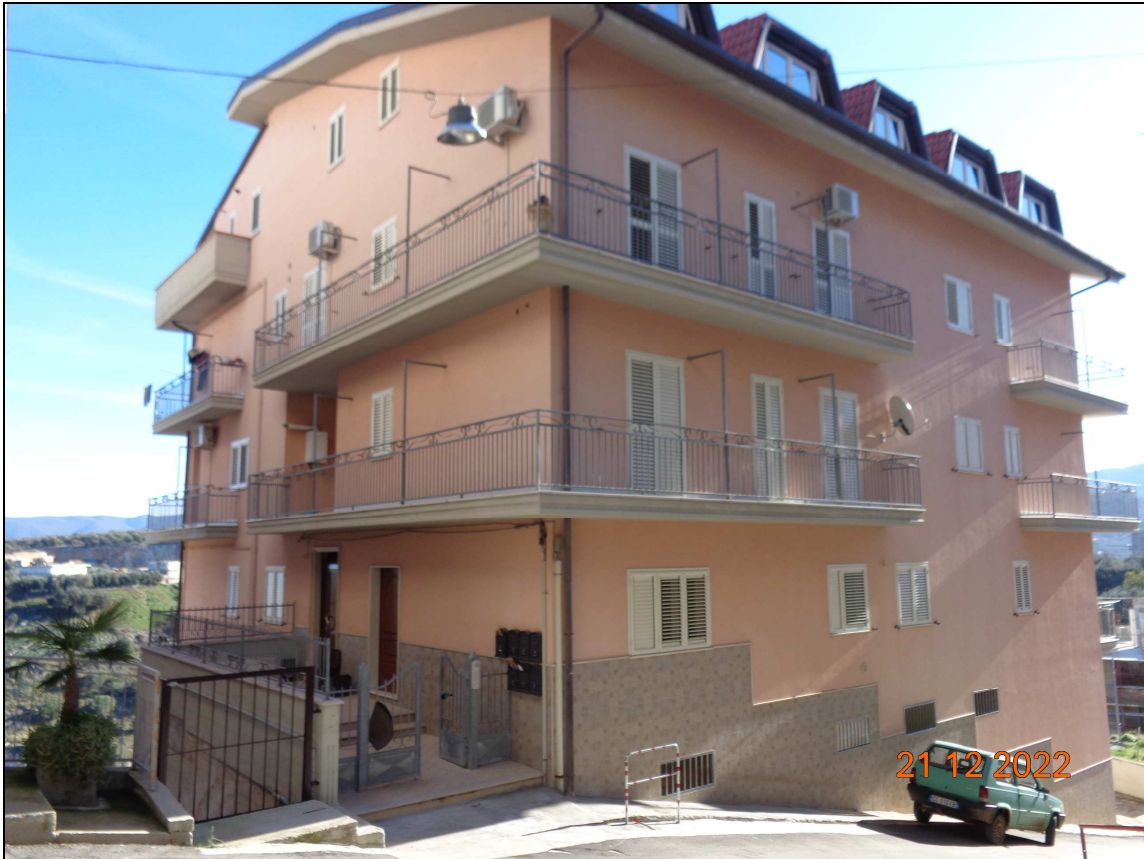
Foto A.1. Fabbricato a cui appartiene l'unità immobiliare pignorata.
