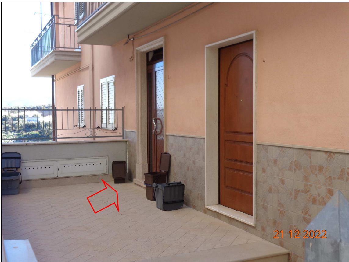
Foto A.2. Accesso al vano scala condominiale, in Via Sandro Pertini, civ. 4/A.
