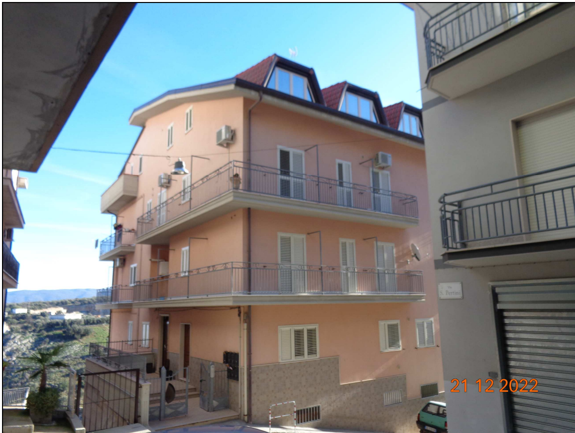
Foto B.1. Fabbricato a cui appartiene l'unità immobiliare pignorata.
