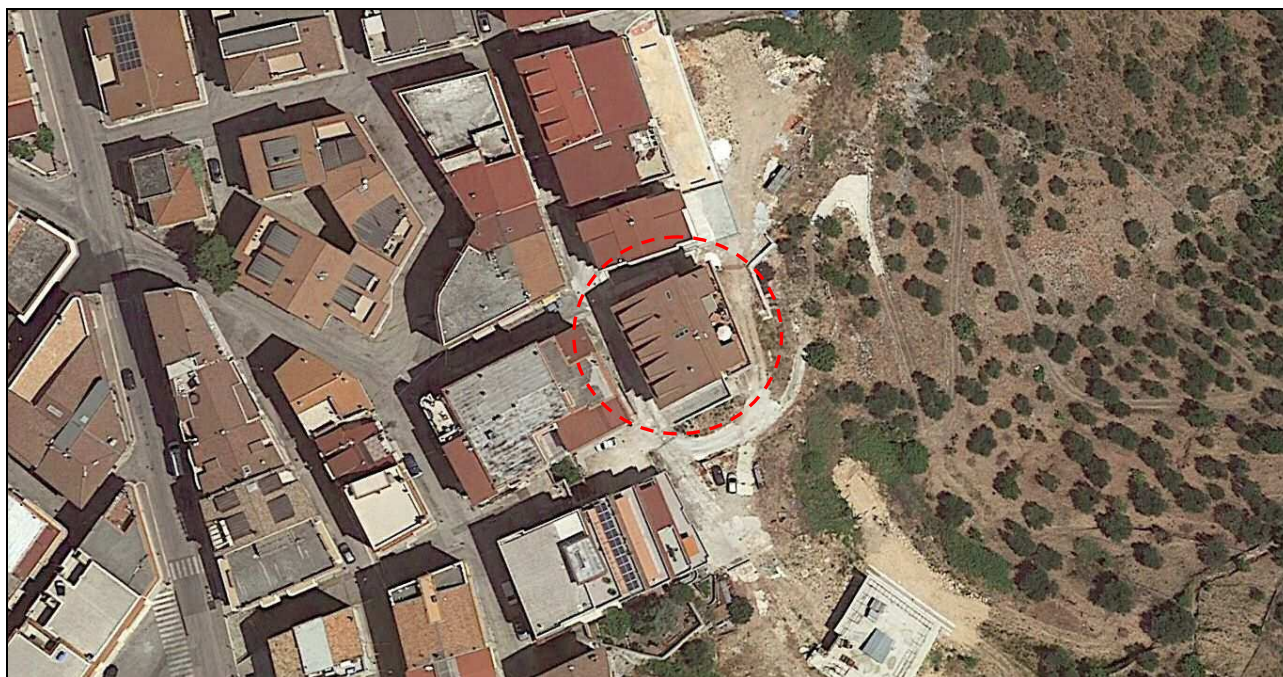
Figura B.2. Vista satellitare del fabbricato entro cui è ubicata l'unità immobiliare pignorata.
