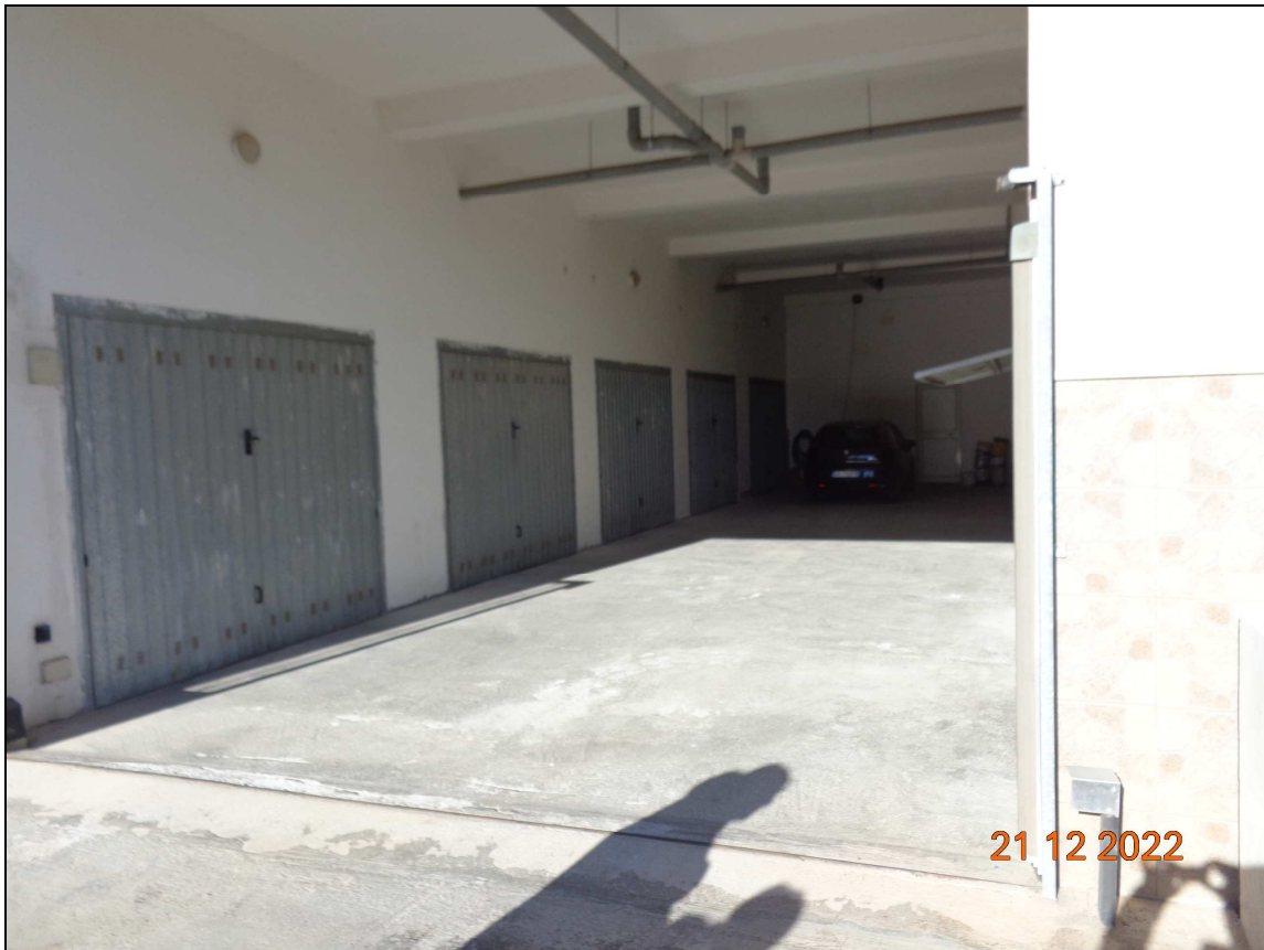
Foto B.3. Spazio comune di manovra per l'accesso ai box.
