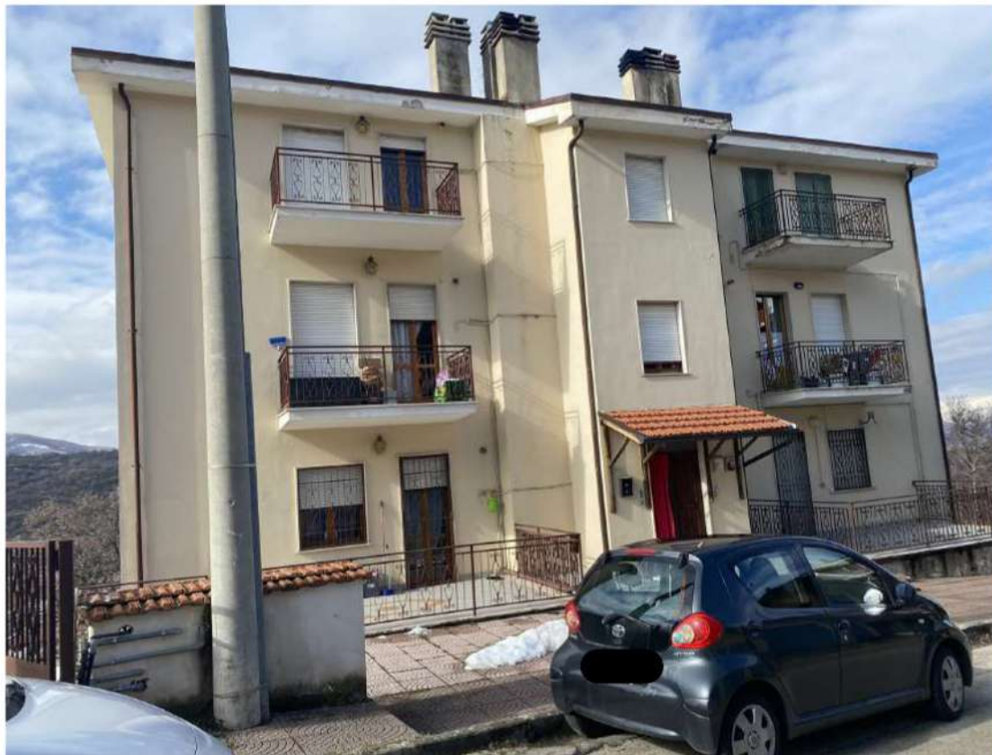
Foto 9: Vista d'insieme del fabbricato e del Bene, porzione a SX al livello della strada.
