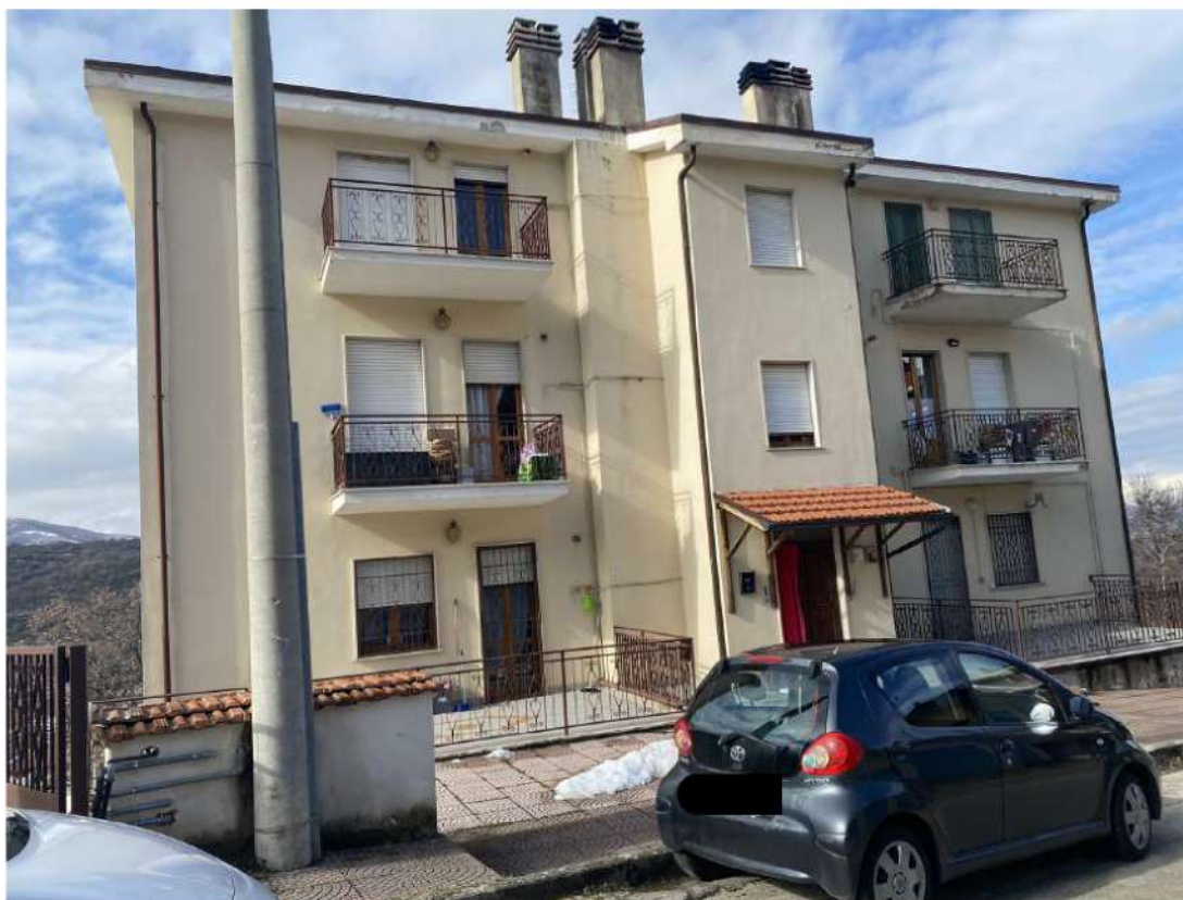
Foto 21: Vista d'insieme del fabbricato e del Bene, porzione a SX al Secondo(mansardato) livello dalla strada.
