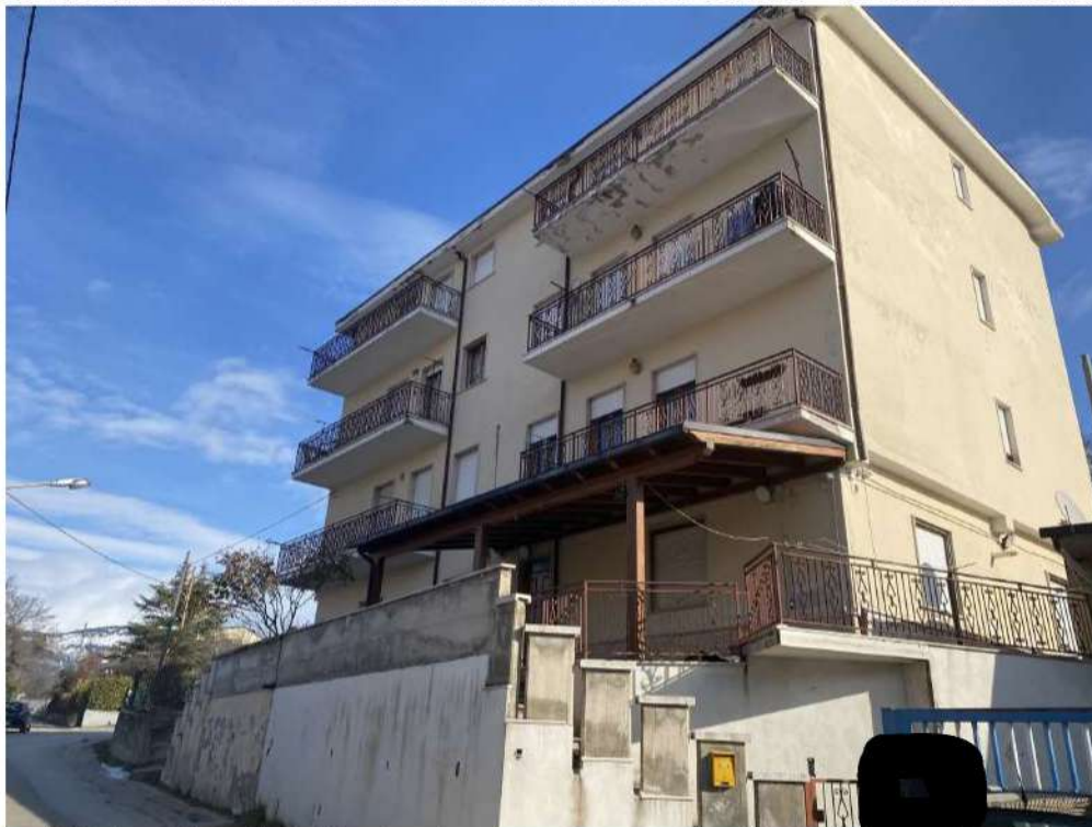
Foto 2: Vista d'insieme del fabbricato e del Bene al livello rialzato da strada.
