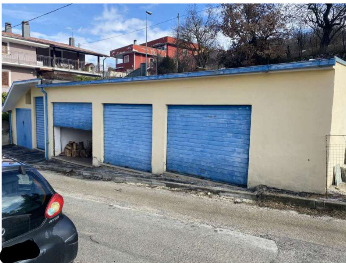
Foto 20: Vista del Garage "B" (Secondo garage da DX).
