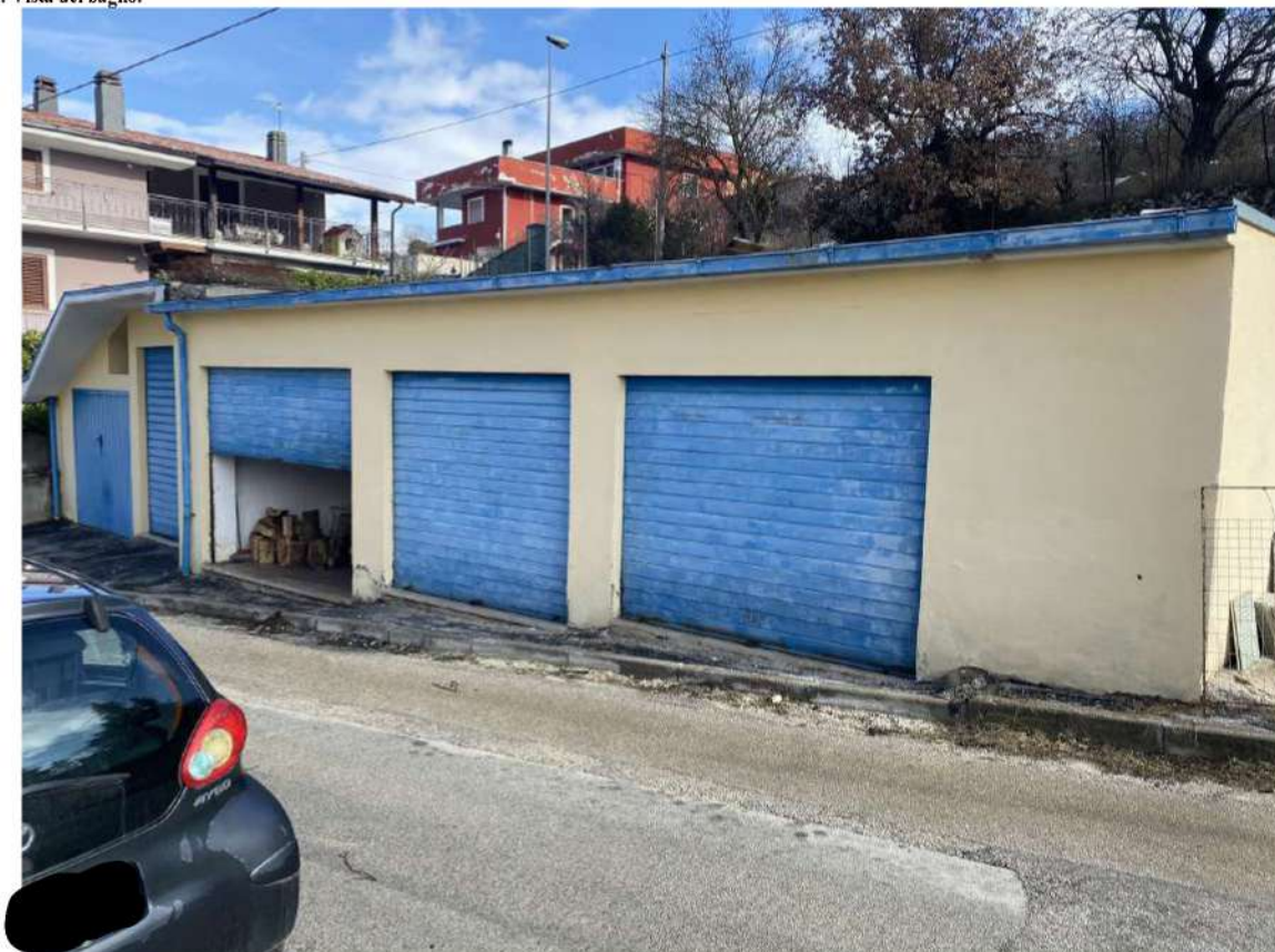
Foto 26: Vista del Garage (Primo garage da DX).
