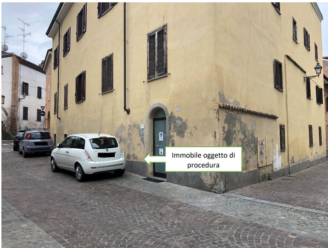
Foto n. 1 – Immobile oggetto di procedura, vista da Via Domenico Schiavi
