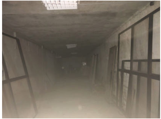
Corsia di servizio (di manovra)
