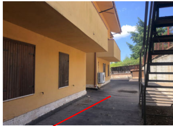
Solaio di copertura dell'interrato
