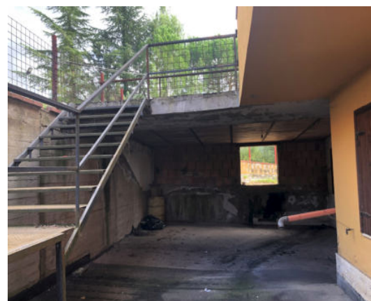
Solaio a fianco alla passerella
