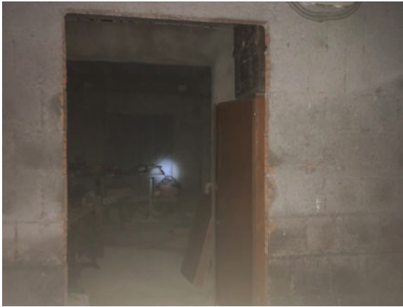
Accesso al magazzino
