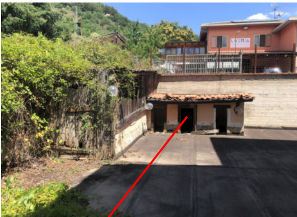
Locali alle spalle dell'albergo
