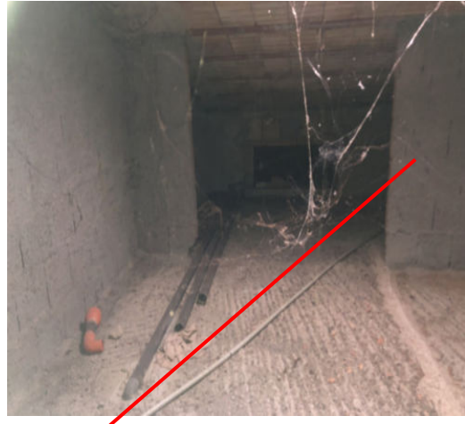
Tramezzi realizzati per delimitare la parte centrale più alta (ambiente 2)
