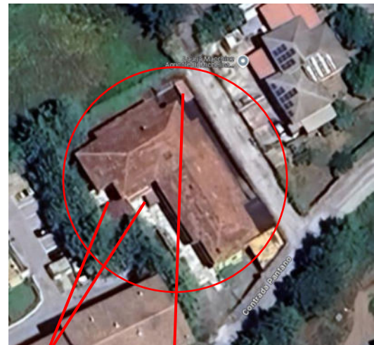
Tettoie A e B e locali non accatastati
