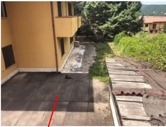
Solaio di copertura dell'interrato
