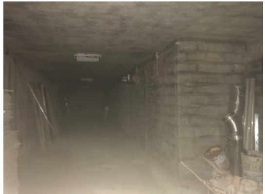
Corsia di servizio (di manovra)
