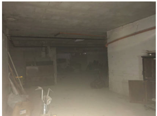
Corsia di servizio (di manovra)
