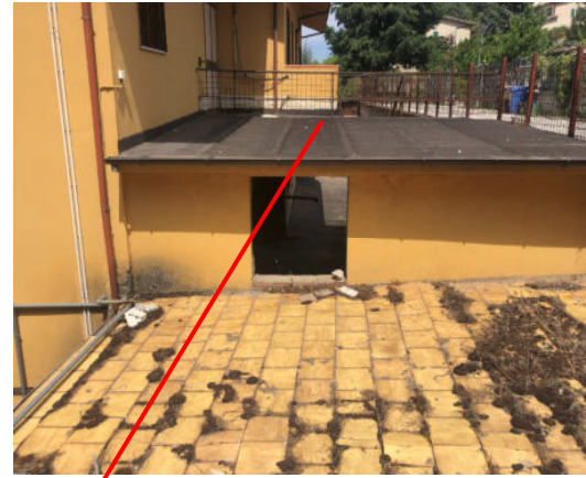
Solaio a fianco alla passerella
