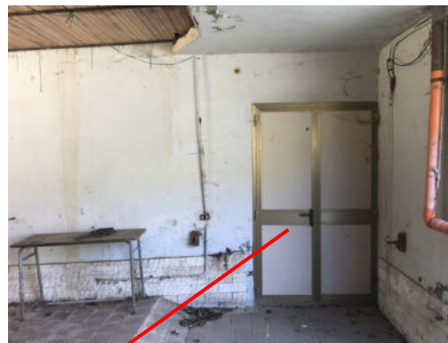
Uscita di sicurezza antincendio
