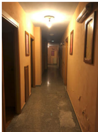
Corridoio di accesso alle camere da letto al PT
