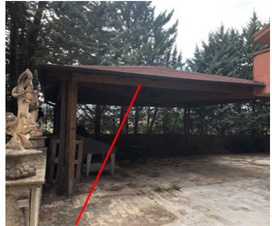
Tettoia B nei pressi dell'ingresso
