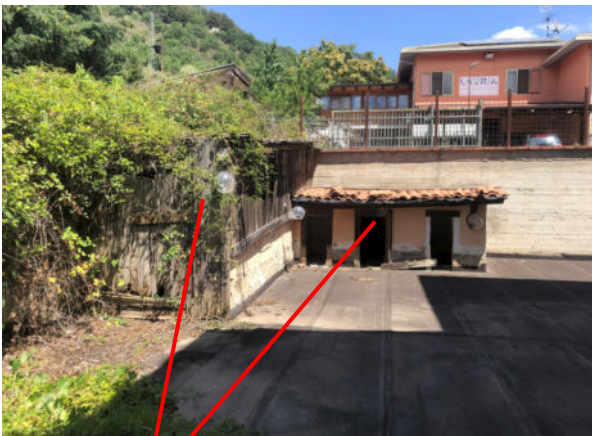
Locali alle spalle dell'albergo
