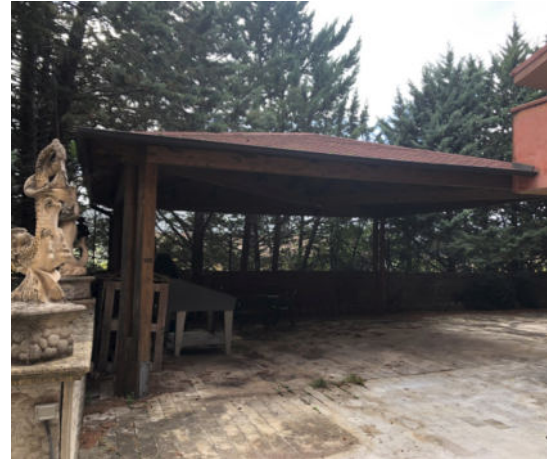
Tettoia B nei pressi dell'ingresso
