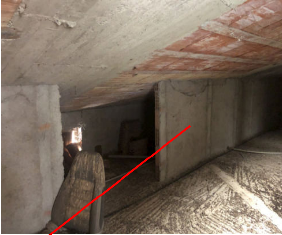
Tramezzi realizzati per delimitare la parte centrale più alta (ambiente 2)
