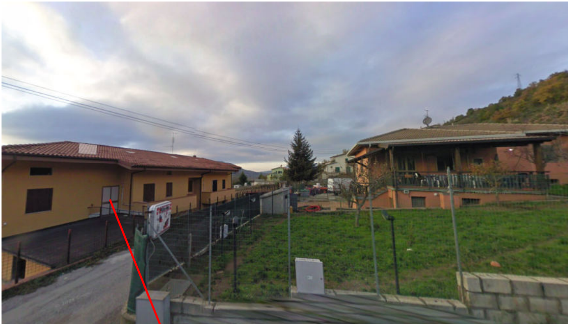
Uscita di sicurezza antincendio collegata alla passerella
