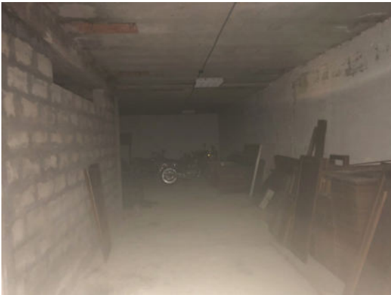
Corsia di servizio (di manovra)
