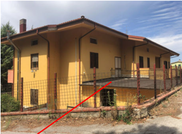
Solaio a fianco alla passerella
