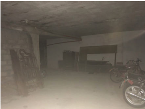
Corsia di servizio (di manovra)
