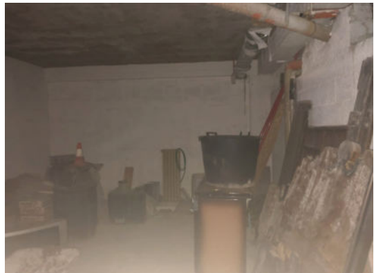
Corsia di servizio (di manovra)
