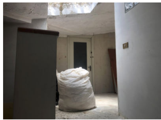
Ballatoio di arrivo alla soffitta
