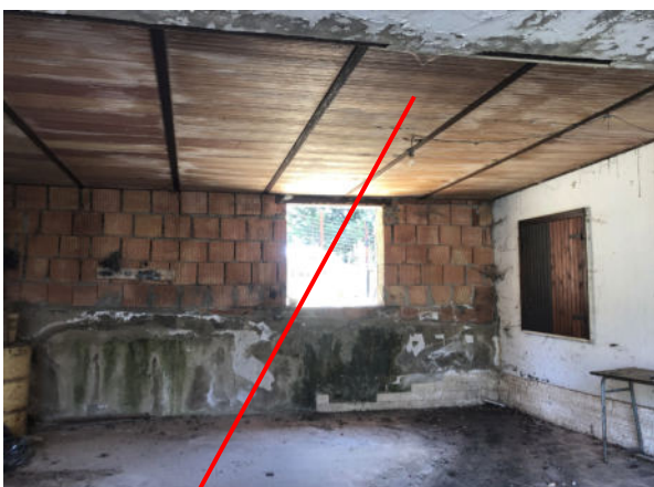
Solaio a fianco alla passerella
