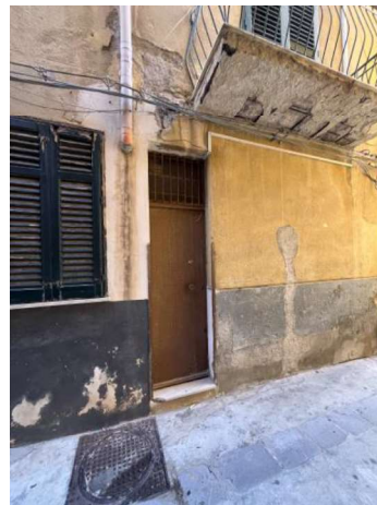
Foto 6 – Accesso dalla via Galera, ad oggi chiuso con blocchetti dall'interno
