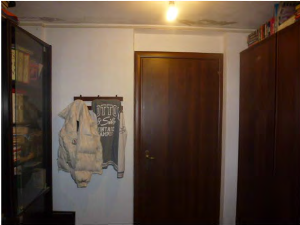
Foto n. 18: Ingresso (Piano Sottostrada)
