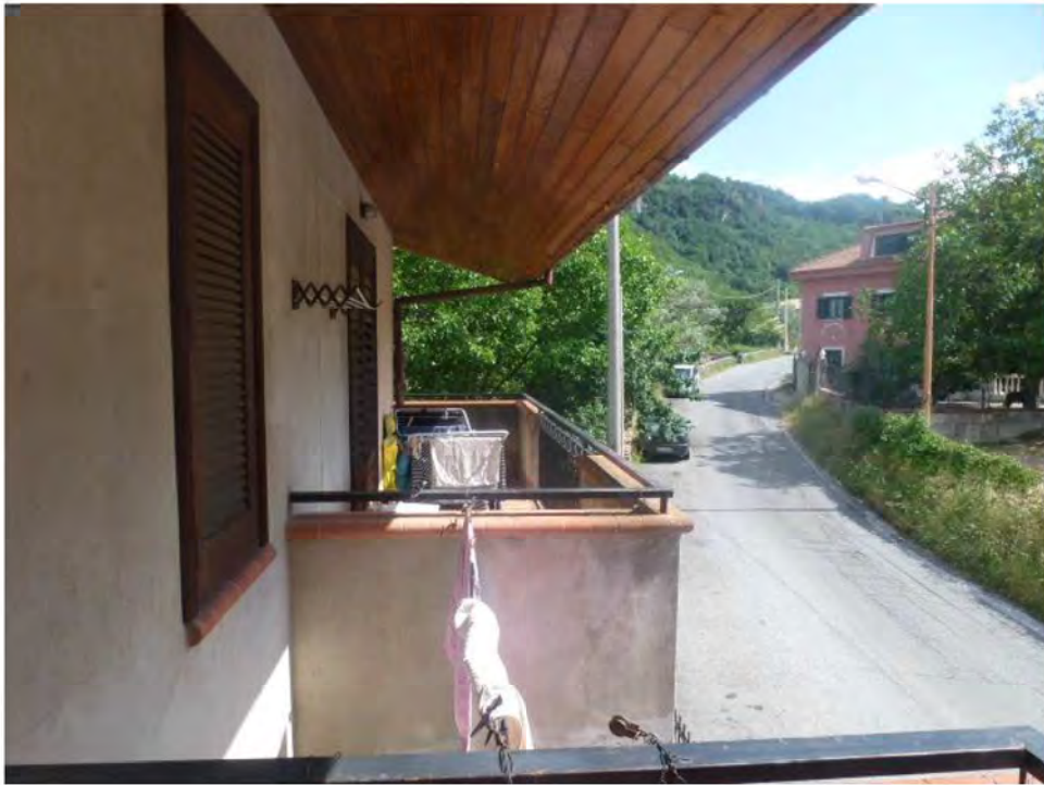
Foto n. 15: Balcone Lato Est
