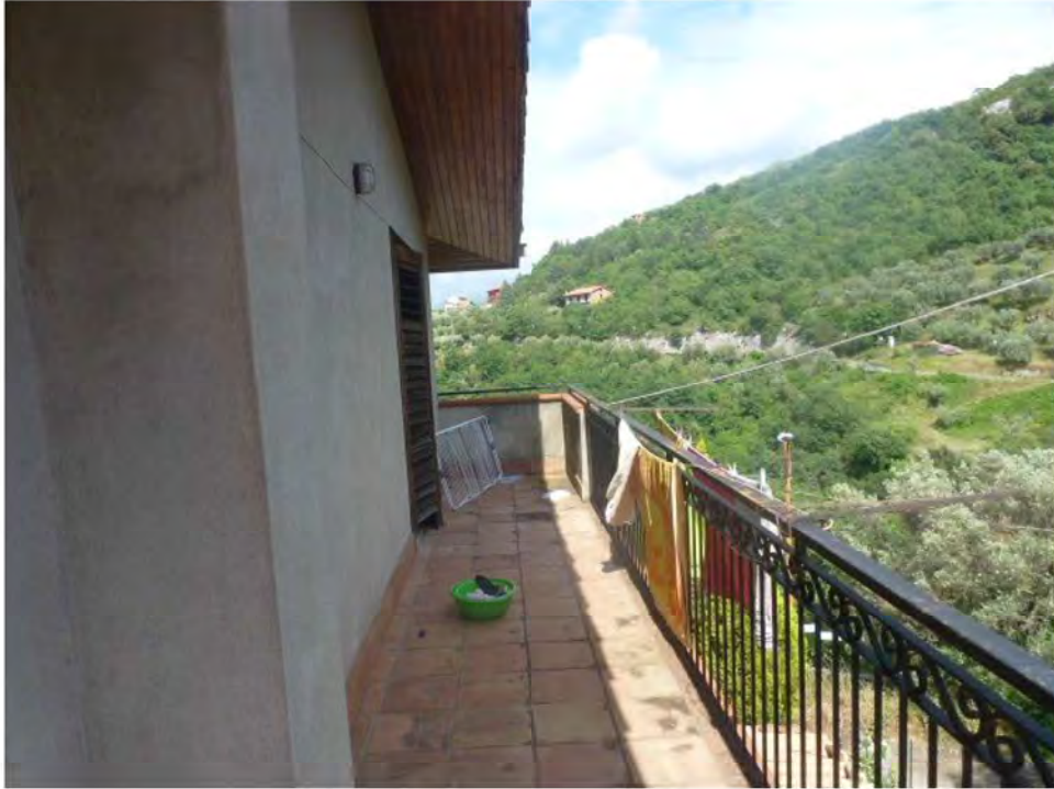
Foto n. 17: Balcone Lato Sud
