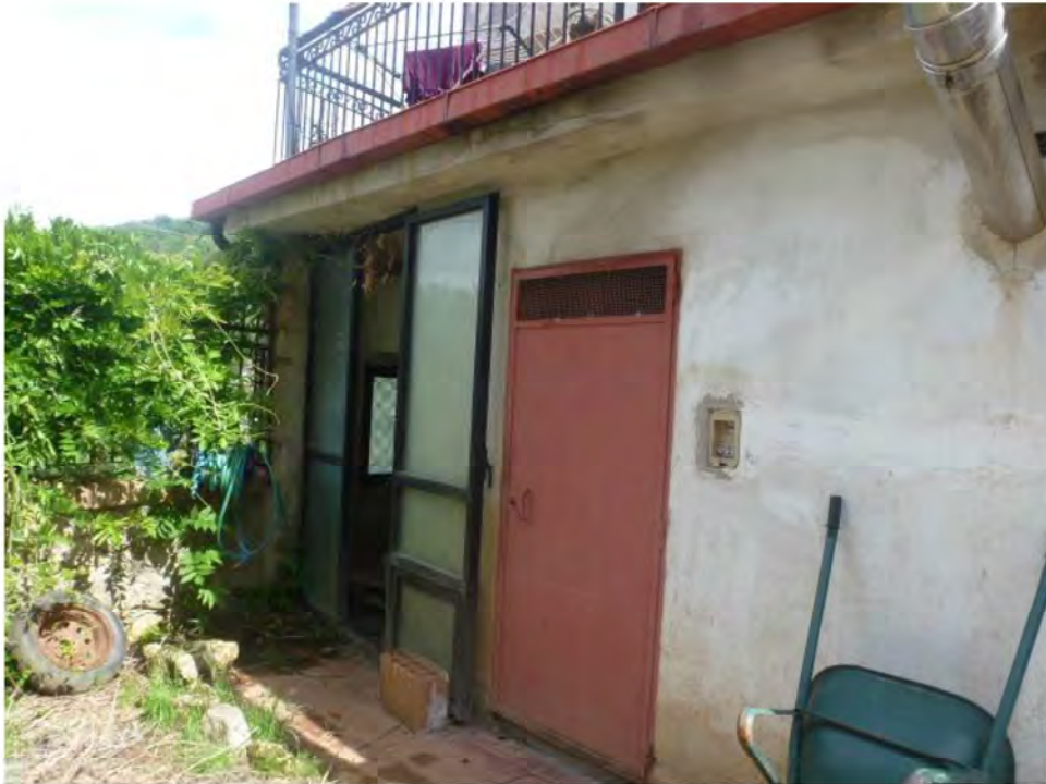
Foto n. 24: Ingresso Centrale Termica
