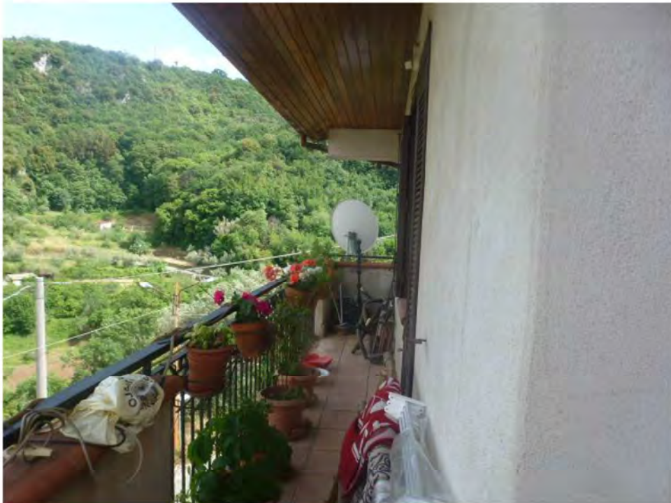
Foto n. 14: Balcone Lato Ovest
