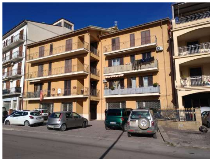
FOTO 1 – 2 – 3 --- PROSPETTO su via DELLA PACE
