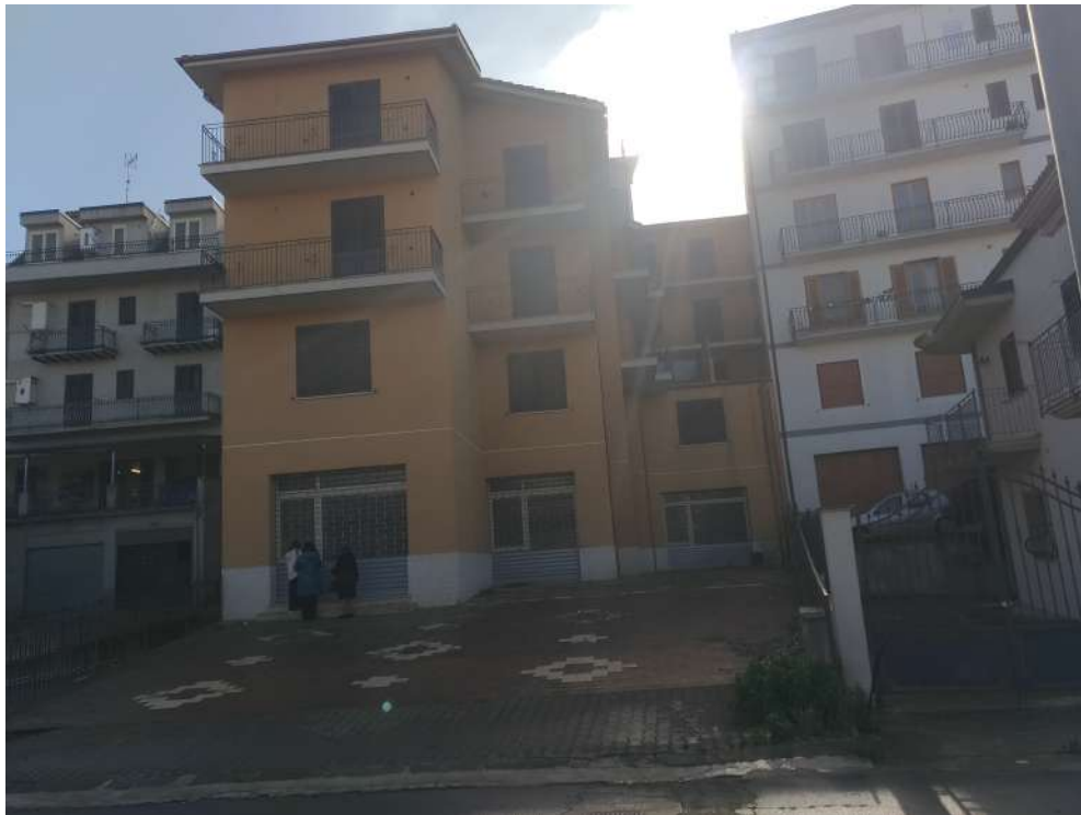
FOTO 4 – 5 – 6 --- PROSPETTO su via DELLA PACE
