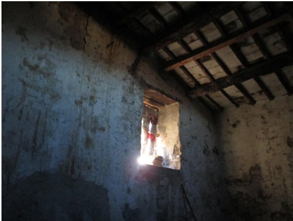
Foto n.26: Altro particolare della soffitta.
