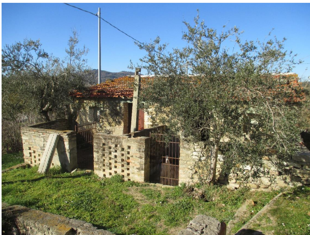
Foto n.9: Altro particolare degli stalletti.
