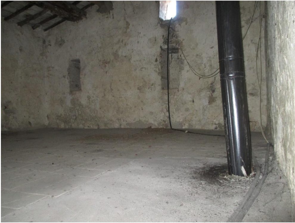
Foto n.25: Interno della soffitta al secondo piano.
