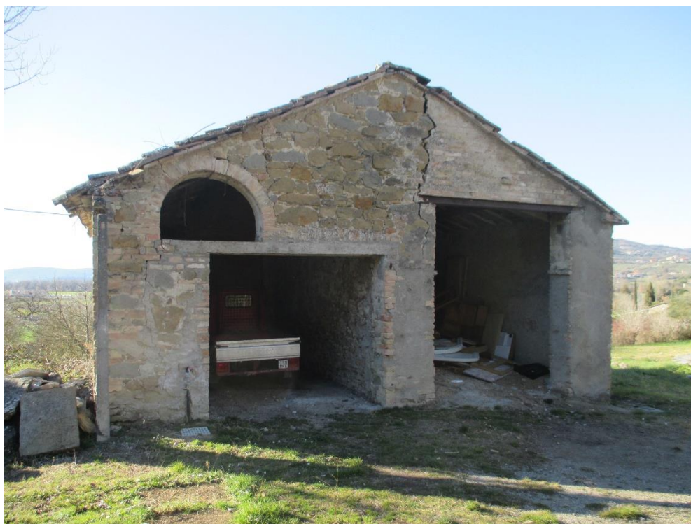
Foto n.10: Particolare della rimessa.
