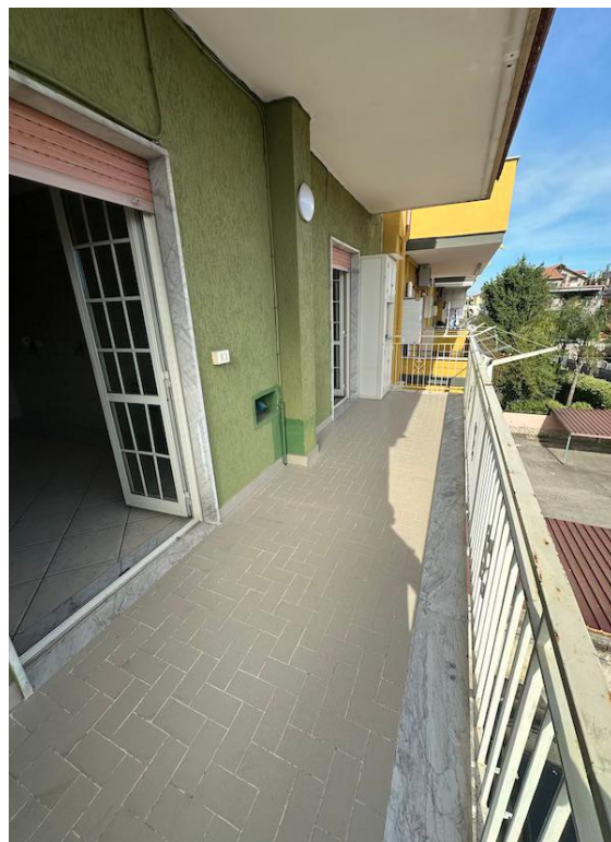
Foto n.6 – particolare balcone lato Sud
