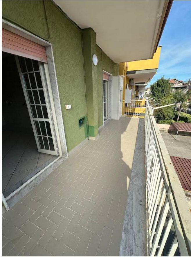
foto n.º7 – particolare balcone lato strada
