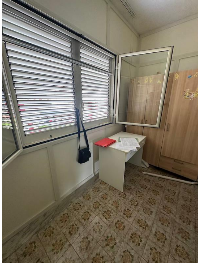
foto n.º5 – particolare veranda
