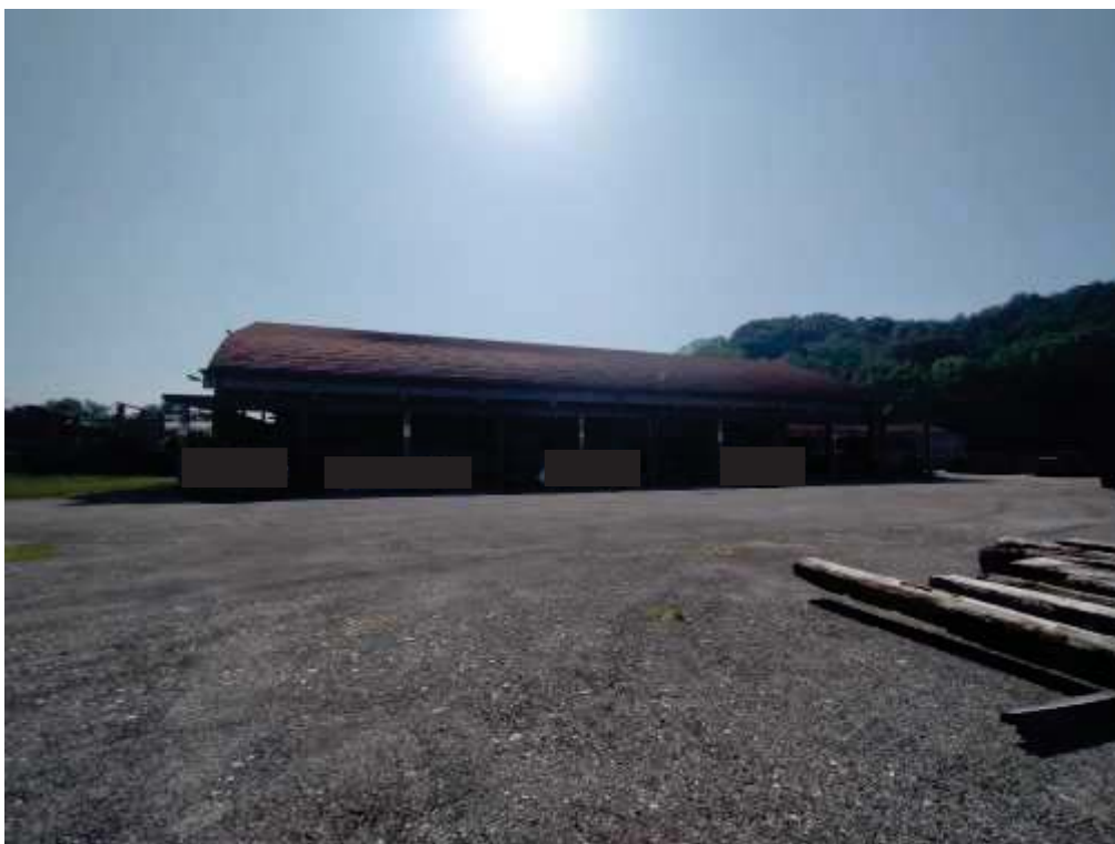
2. Foto: opificio, prospetto ovest e area scoperta/spazio di manovra
