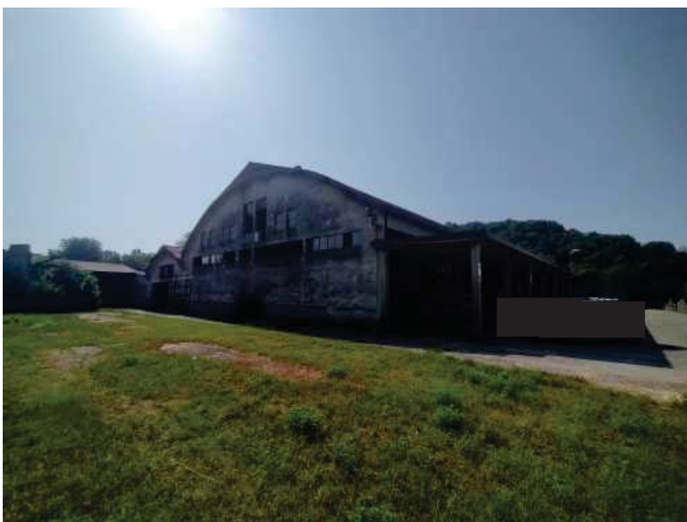
3. Foto: opificio, prospetto nord e area scoperta
