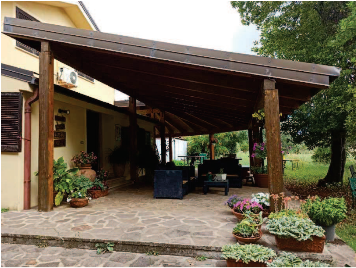
Foto n. 8 – Veduta esterna – Tettoia
