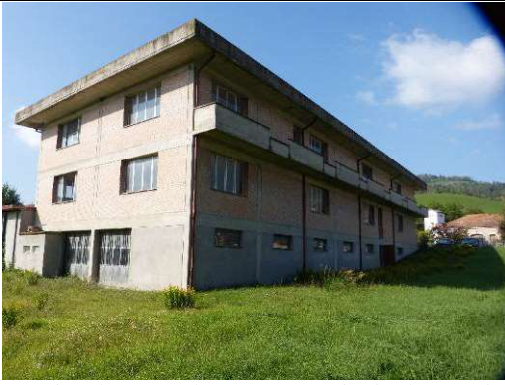
Vista lato Nord-est, corpo principale a 3 piani
