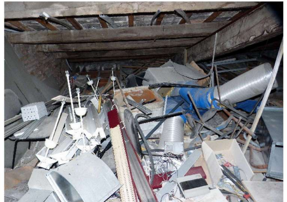
sottotetto accessibile dal sopalco piano secondo
