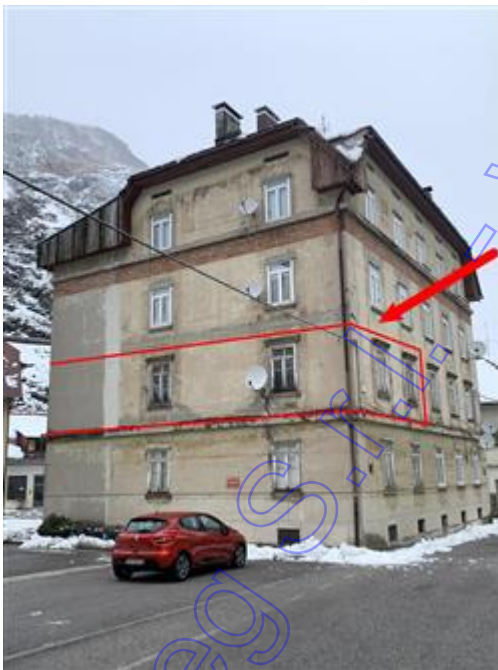
Facciata sud/est condominiale.
