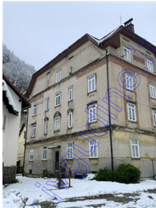
Facciata condominiale principale (nord).
