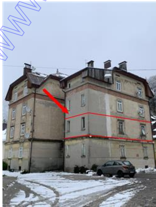
Facciata sud/ovest condominiale.
