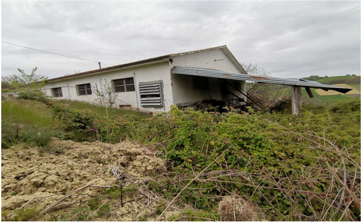
FOTO LATO SUD/OVEST FABBRICATO PRINCIPALE E PARTICOLARE TETTOIA ABUSIVA DA DEMOLIRE
