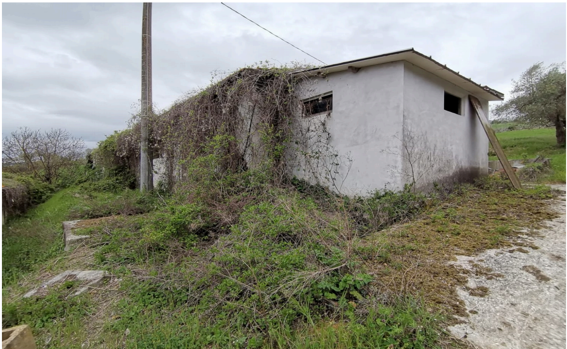
FOTO LATO NORD/EST FABBRICATO PRINCIPALE E PARTICOLARE LOCALE ABUSIVO DA DEMOLIRE
