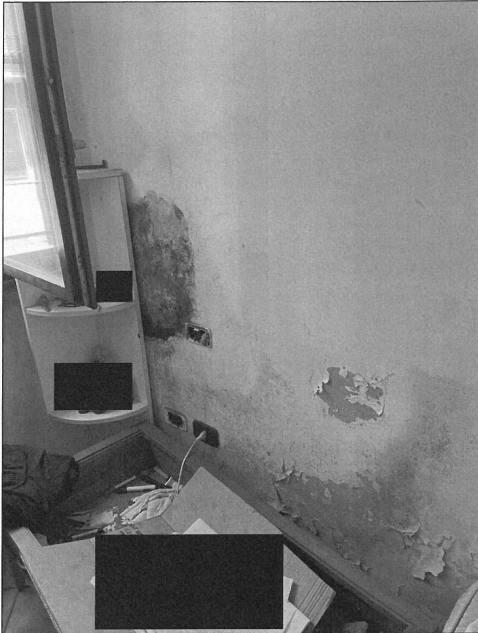
**Foto n. 21 – particolare della parete Camera 2 con umidità**
