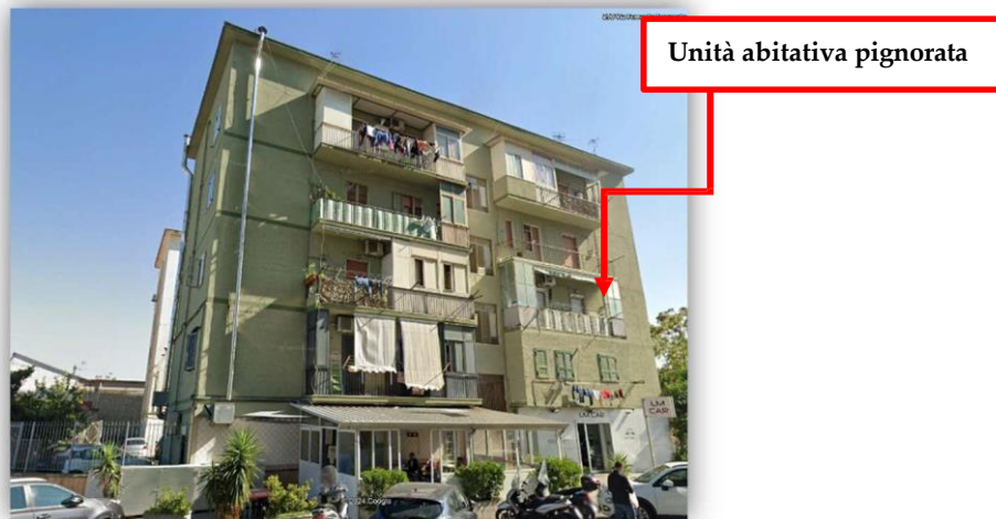
Facciata esterna fabbricato
