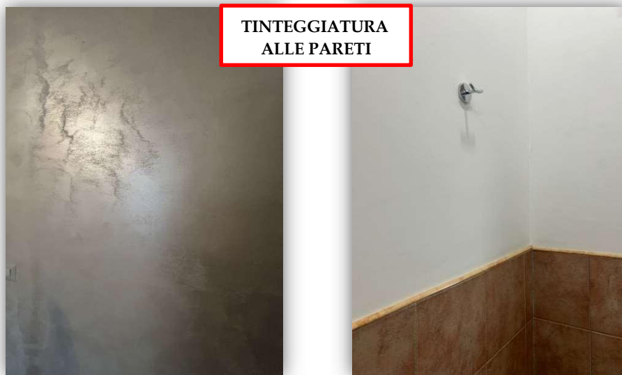
Pareti con pittura sabbata (dis., sogg.-cucina e camera da letto)
