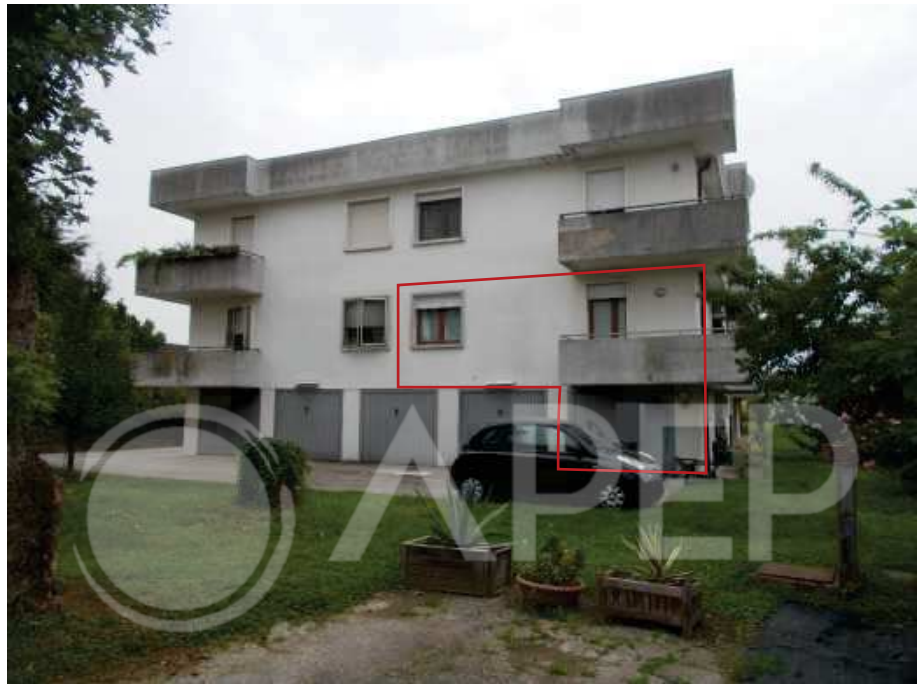
Foto 3- Vista da nord ovest- Fronte nord
