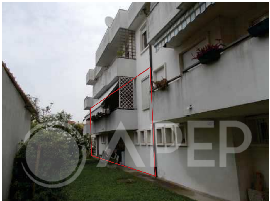
Foto 4- Vista lato ovest
