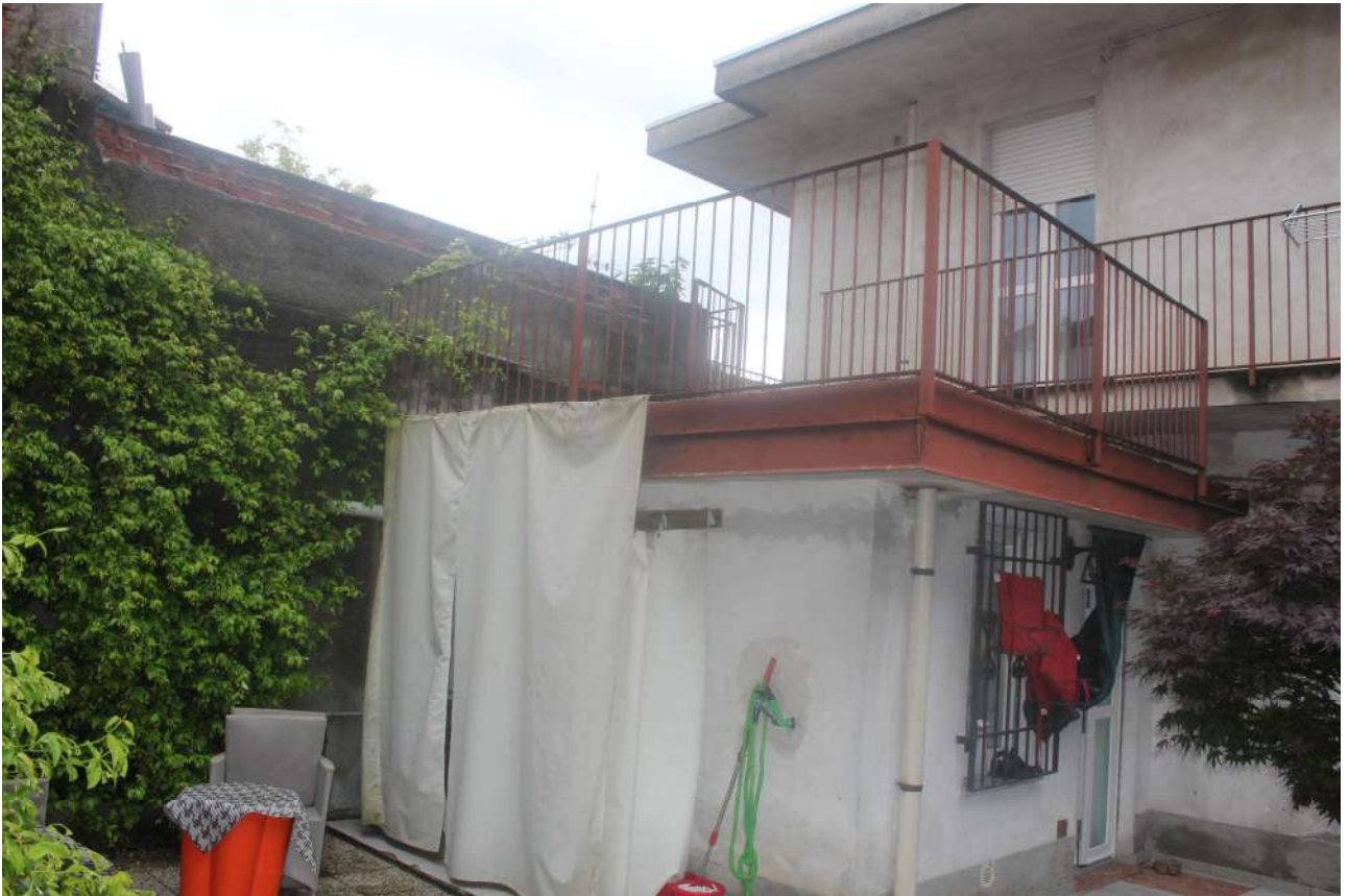
Foto 11 – Vista esterna da cortile di proprietà
