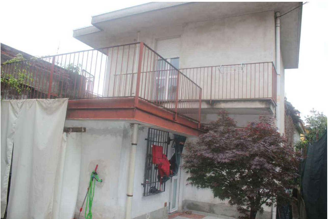
Foto 12 – Vista esterna da cortile di proprietà
