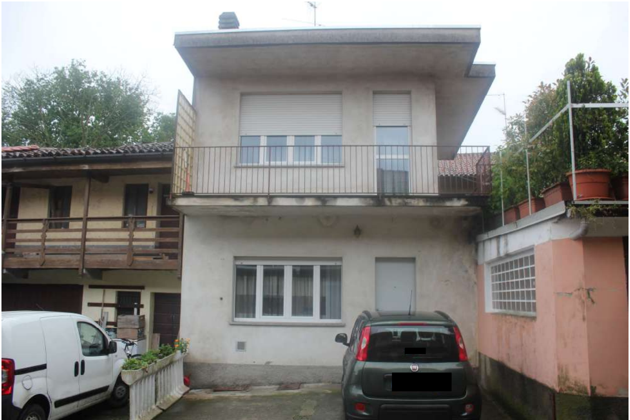
Foto 01 – Vista fronte cortile comune
