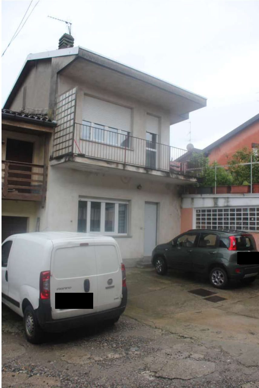
Foto 17 – Vista esterna terreno censito al Fg.9 part. 7203
