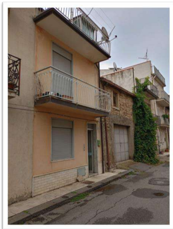
FOTO 1 – PROSPETTO FRONTALE DALLA VIA NAPOLEONE BONAPARTE
