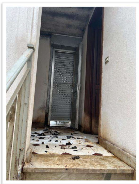
FOTO 10 - VISTA DEL BAGNO
