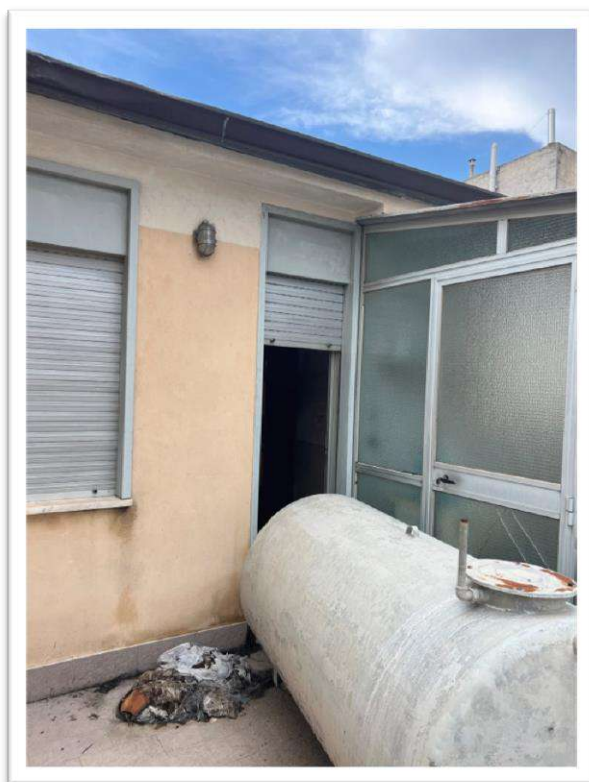
FOTO 12 - VISTA DELLA TERRAZZA
