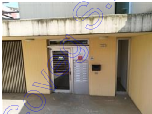
vista ingresso condominiale
