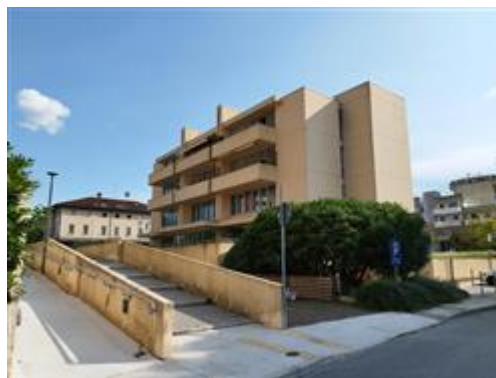
particolare vista prospettica condominiale
