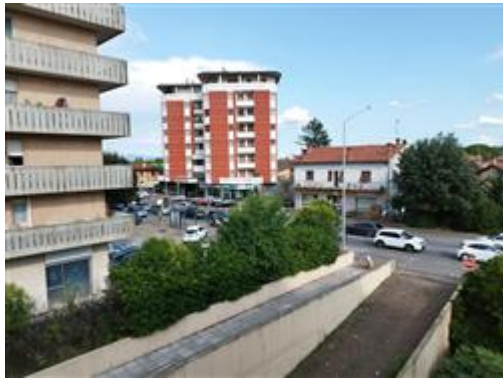
particolare vista su via Santa Caterina (SS13)
