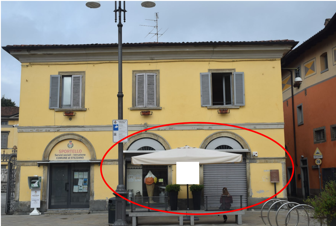
1 – FRONTE SUD (su piazza Libertà)
