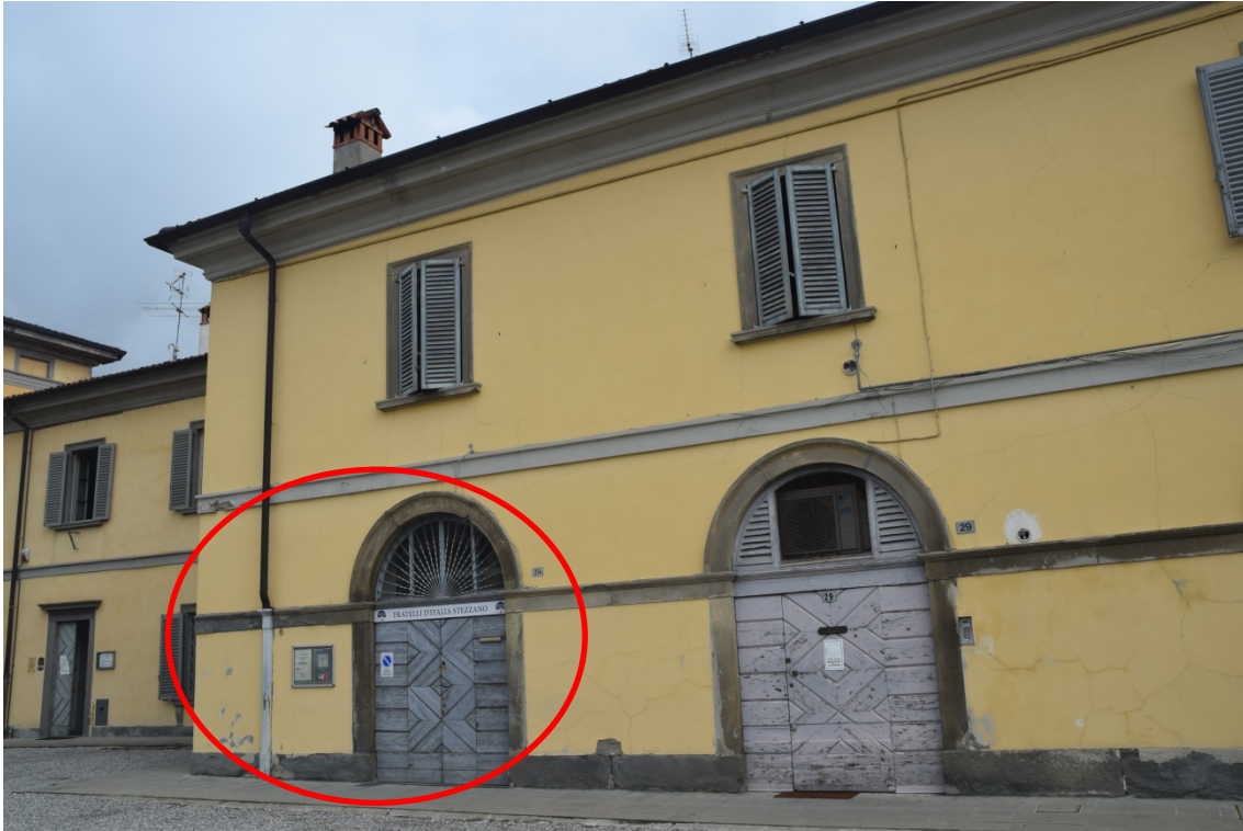
1 – FIANCO OVEST (sul cortile del municipio)
