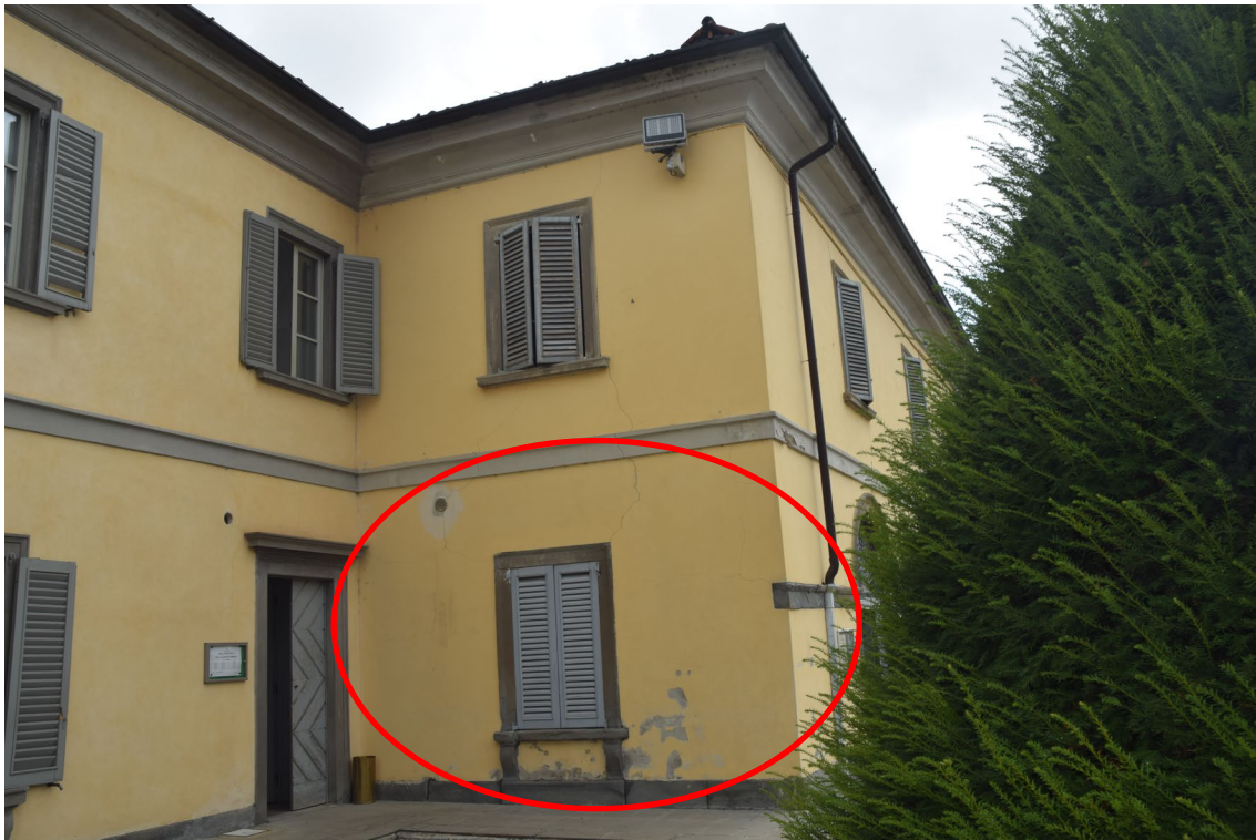
2 – RETRO NORD (sul cortile del municipio)
