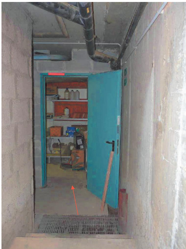
Accesso al magazzino
