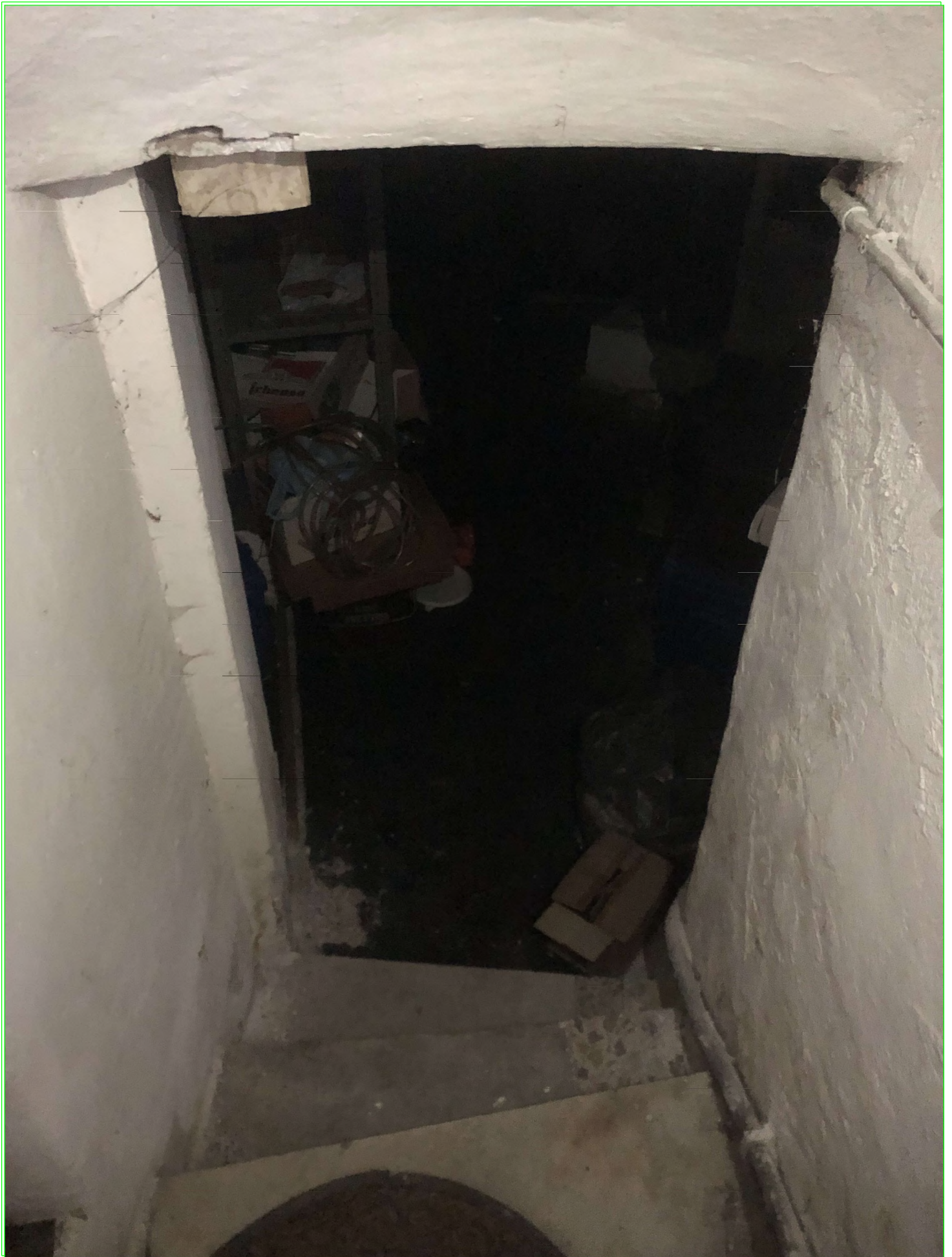
INGRESSO DEPOSITO FOTO 2
