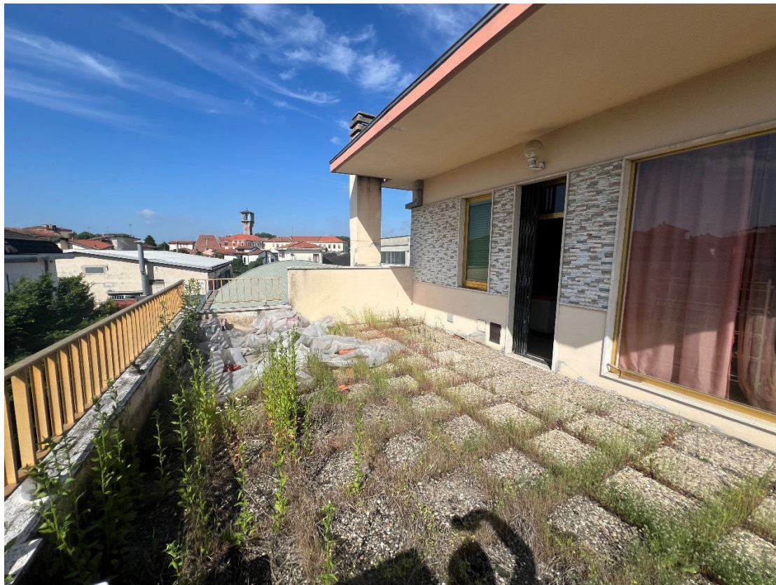
Foto 10_Terrazzo piano primo
