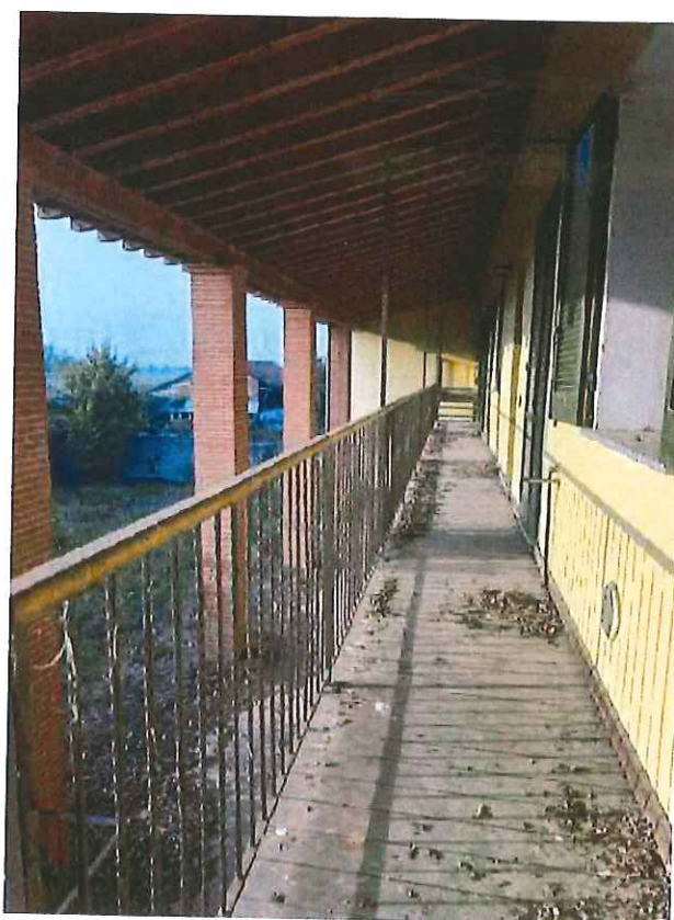
FOTO N. 6 veduta del ballatoio interno
