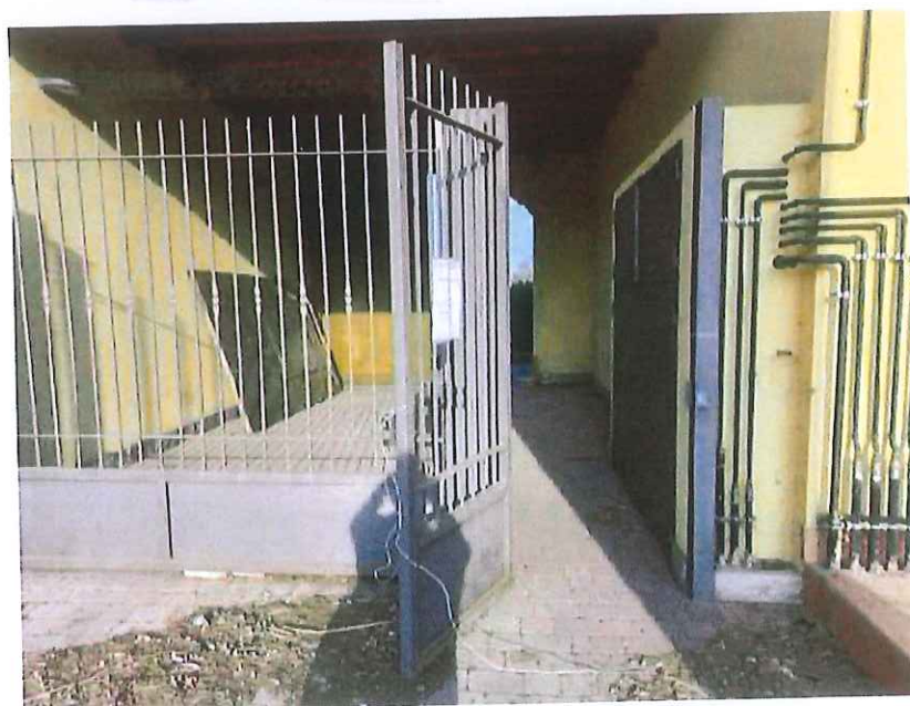
FOTO N. 4 veduta dell'androne dal cortile
