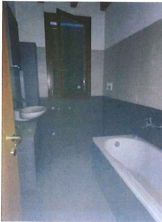
FOTO N. 38 interni mappale 5 sub. 706
