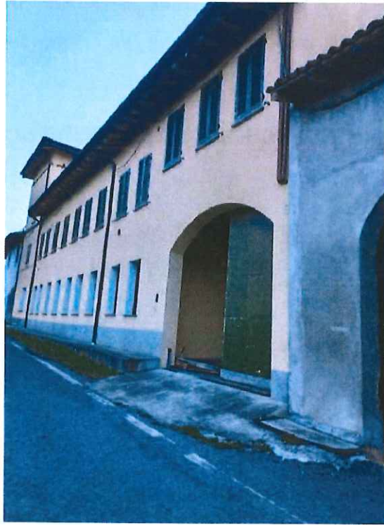
FOTO N. 1 veduta dalla strada
