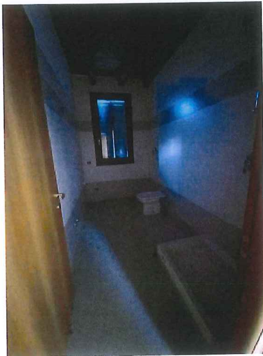
FOTO N. 37 interni mappale 5 sub. 706
