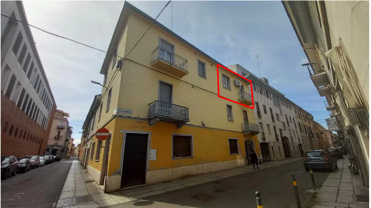
Foto 1 – Vista del fabbricato dall’angolo tra Via Savonarola e Via San Pio V
