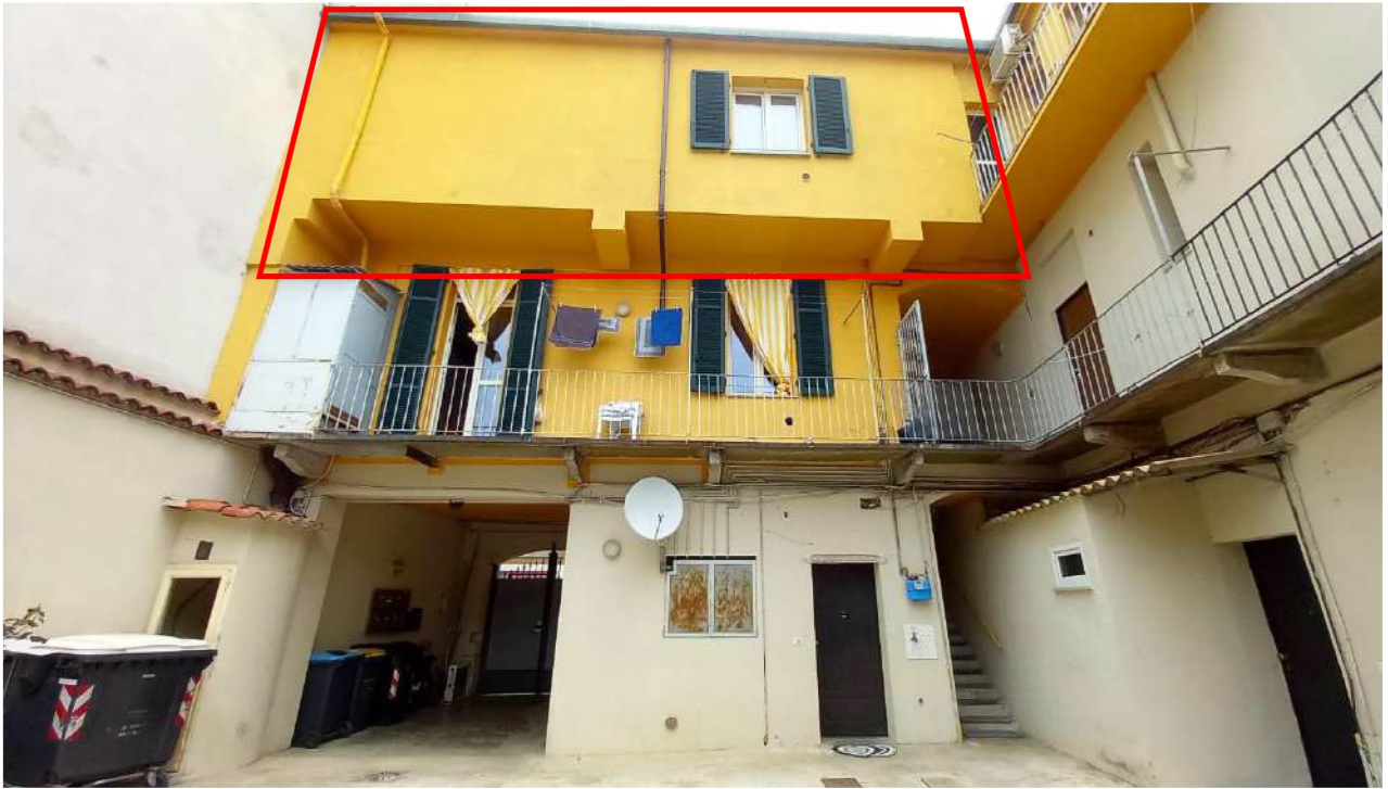
Foto 3 – Vista dal cortile interno
