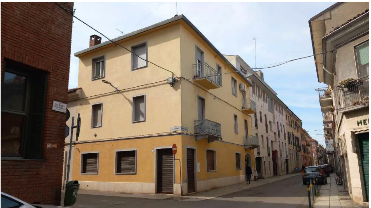
Foto 2 – Vista del fabbricato dall’angolo tra Via Savonarola e Via San Pio V
