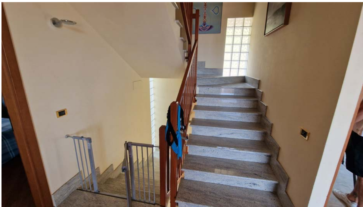
FOTO 15 – Scala di collegamento
