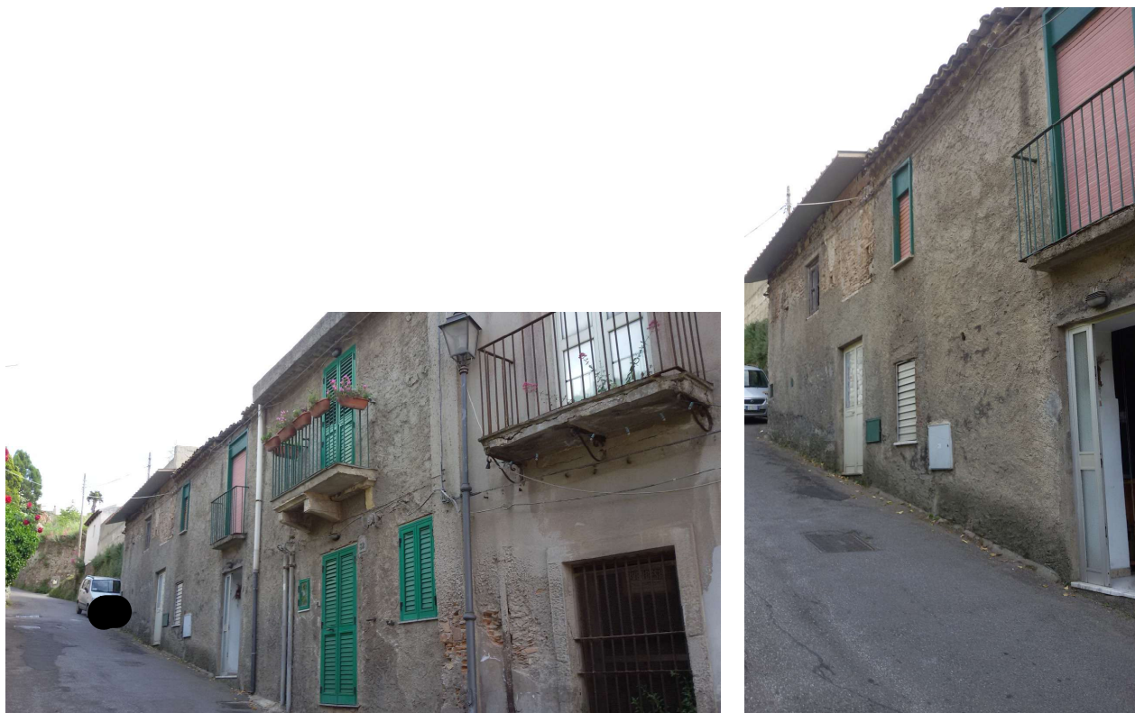
Foto nr. 1-2: prospetto dell'immobile
