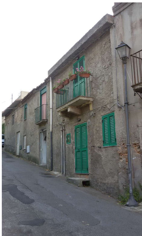
Foto nr. 3 prospetto dell'immobile
