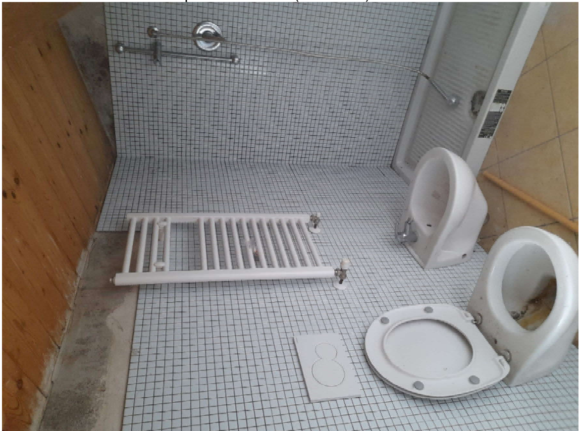
FOTO N. 14 vista interno piano secondo (sottotetto)
