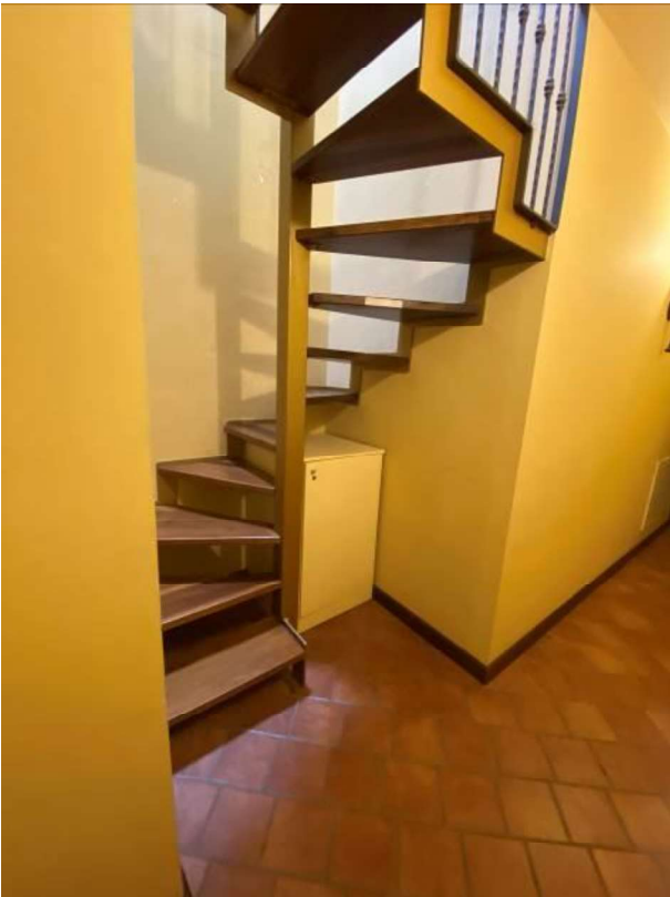
Scala in legno di accesso A CAMERE ABUSIVE
