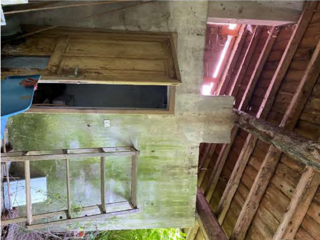
Vista interna abitazione – portico piano terra
