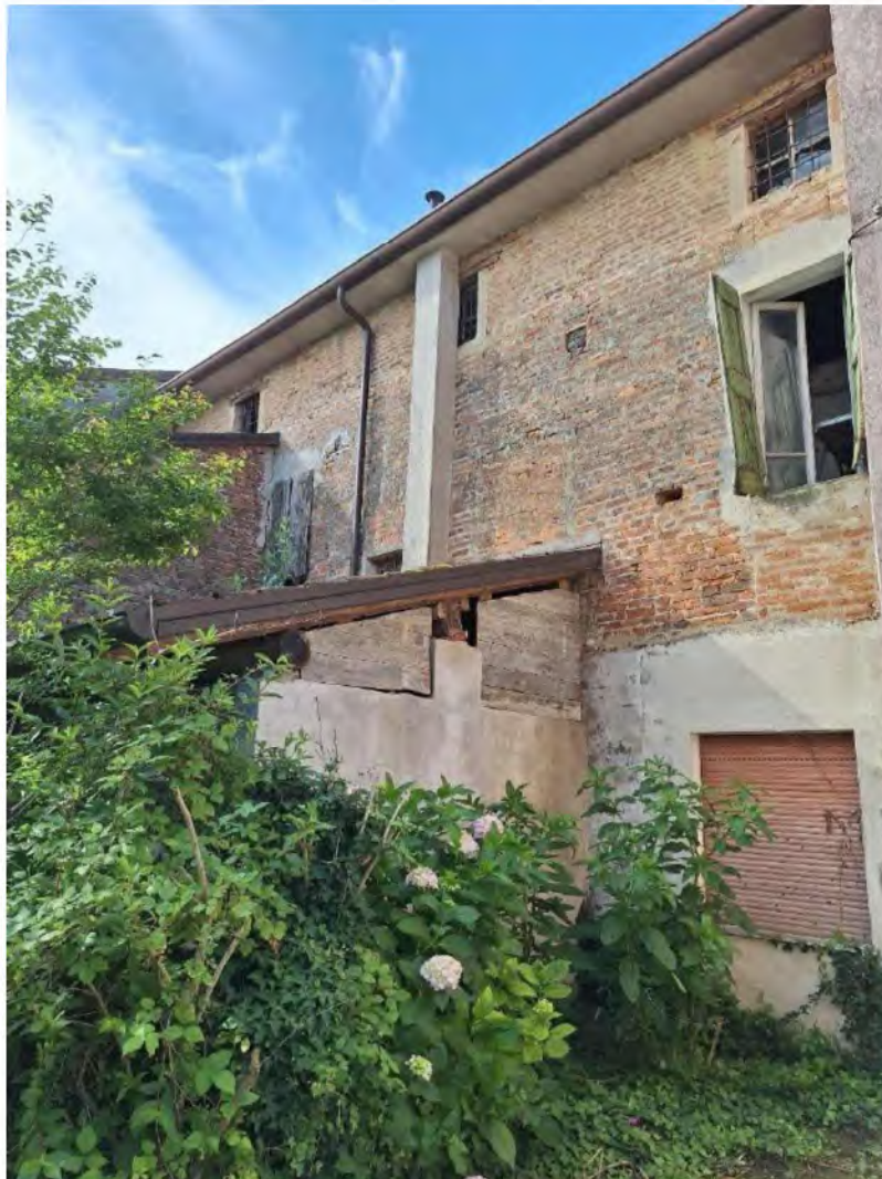
Prospetto nord immobili oggetto di perizia (vista da giardino)
