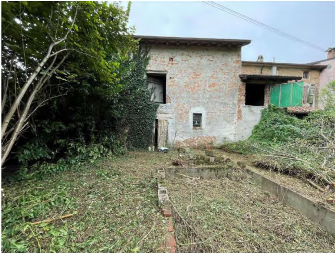
Prospetto nord immobili oggetto di perizia (vista da giardino)
