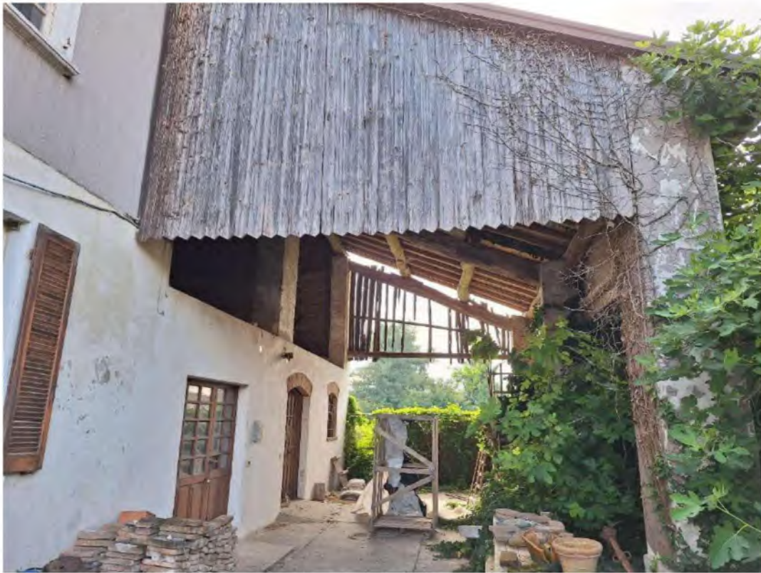
Prospetto sud immobili oggetto di perizia (vista da cortile comune)
