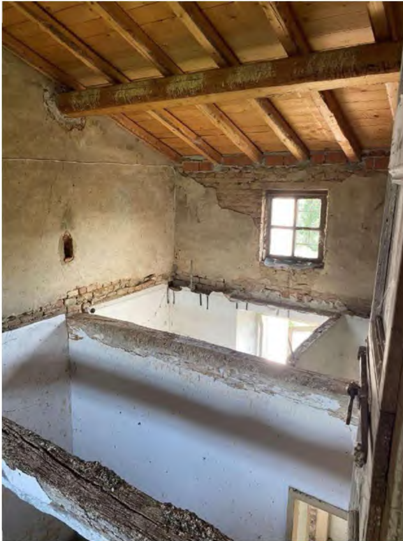
Vista interna abitazione – soffitta piano secondo (porzione senza solaio di interpiano)
