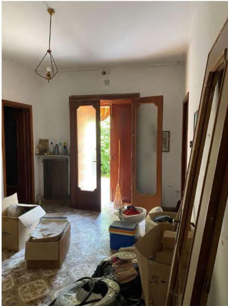
Vista interna abitazione – ingresso piano terra
