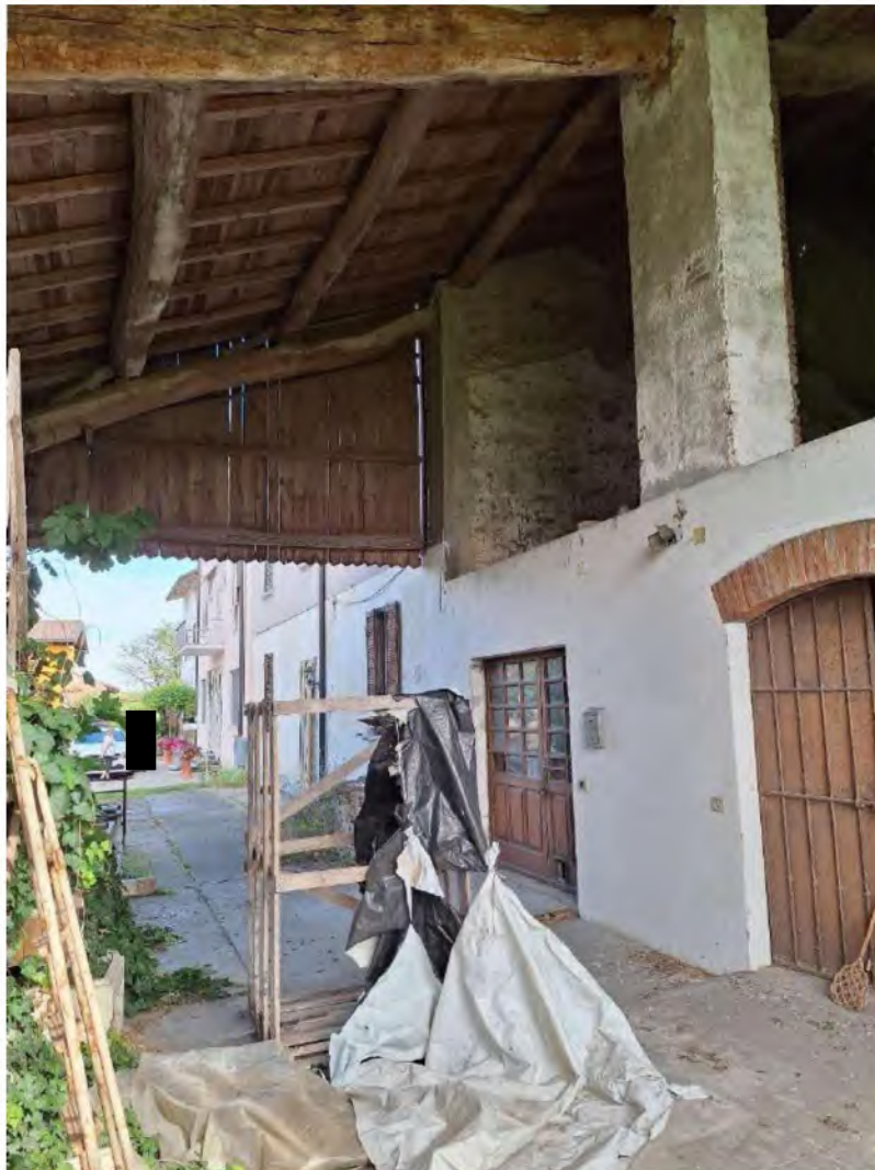
Prospetto sud immobili oggetto di perizia (vista da avamporcico)
