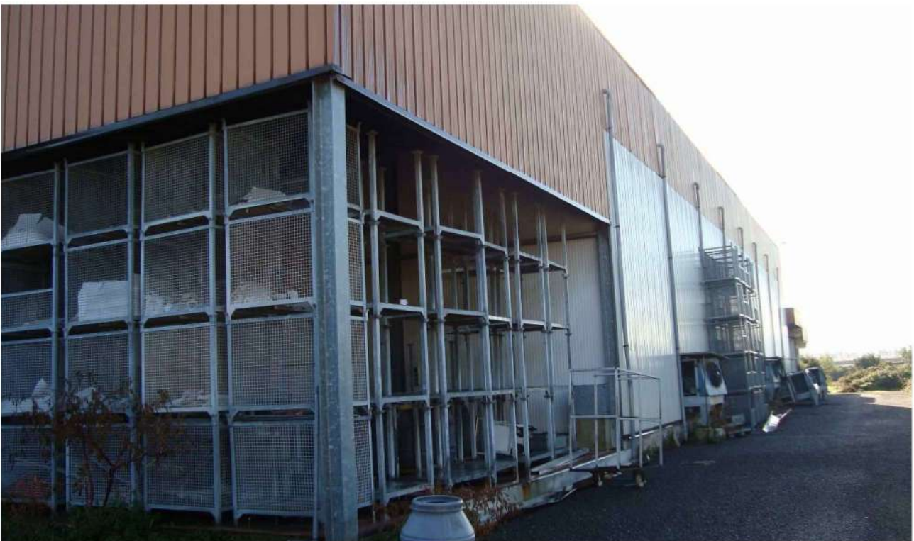
■ Figura 25 vista del fabbricato opificio della particella 52 foglio 32 comune di Lamezia Terme
