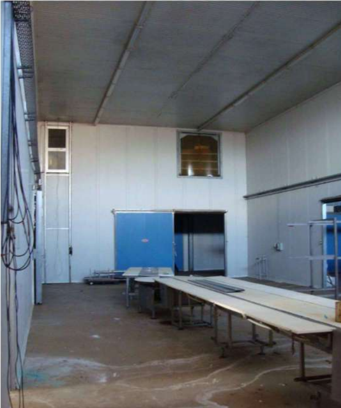
■ Figura 26 vista interna della calla del fabbricato opificio della particella 52 foglio 32 comune di Lamezia Terme
