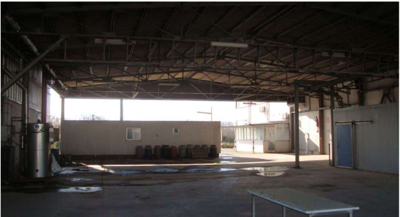
■ Figura 29 vista interna della tettoia del fabbricato opificio della particella 52 foglio 32 comune di Lamezia Terme
