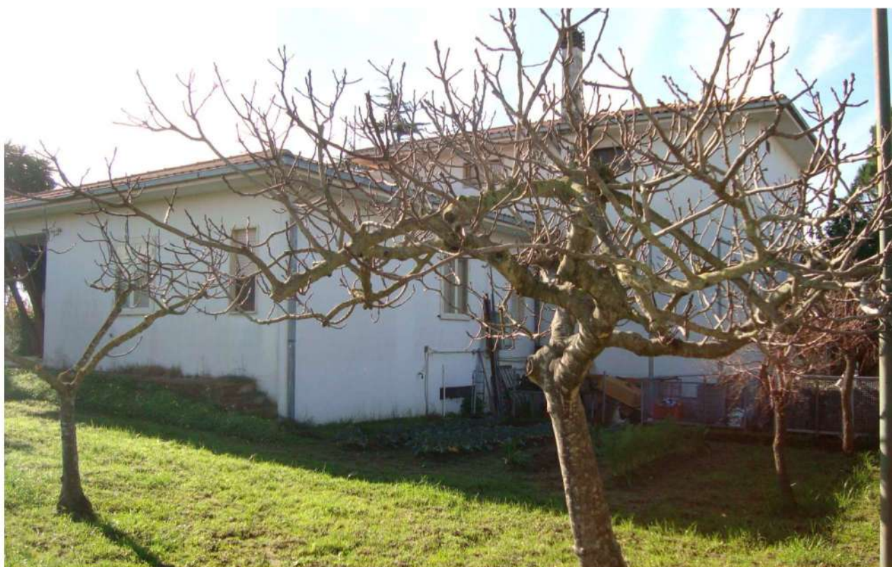
■ Figura 37 vista esterna del fabbricato della particella 116 foglio 32 comune di Lamezia Terme
