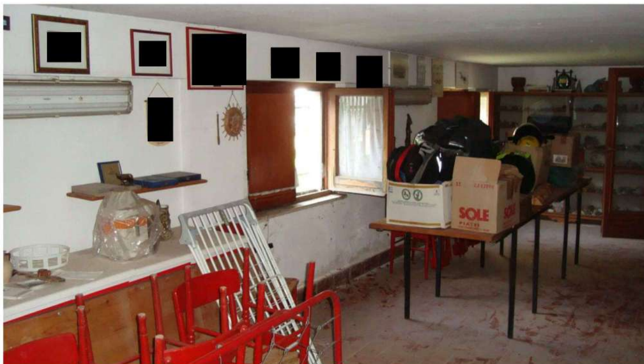
■ Figura 44 vista interna del fabbricato della particella 116 foglio 32 comune di Lamezia Terme
