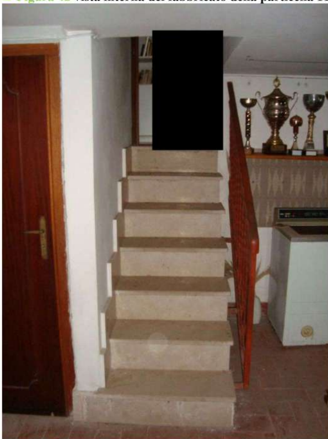
■ Figura 43 vista interna del fabbricato della particella 116 foglio 32 comune di Lamezia Terme
