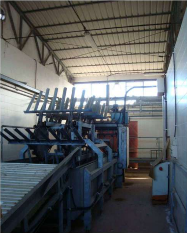
■ Figura 20 vista interna del fabbricato macello della particella 167 foglio 32 comune di Lamezia Terme
