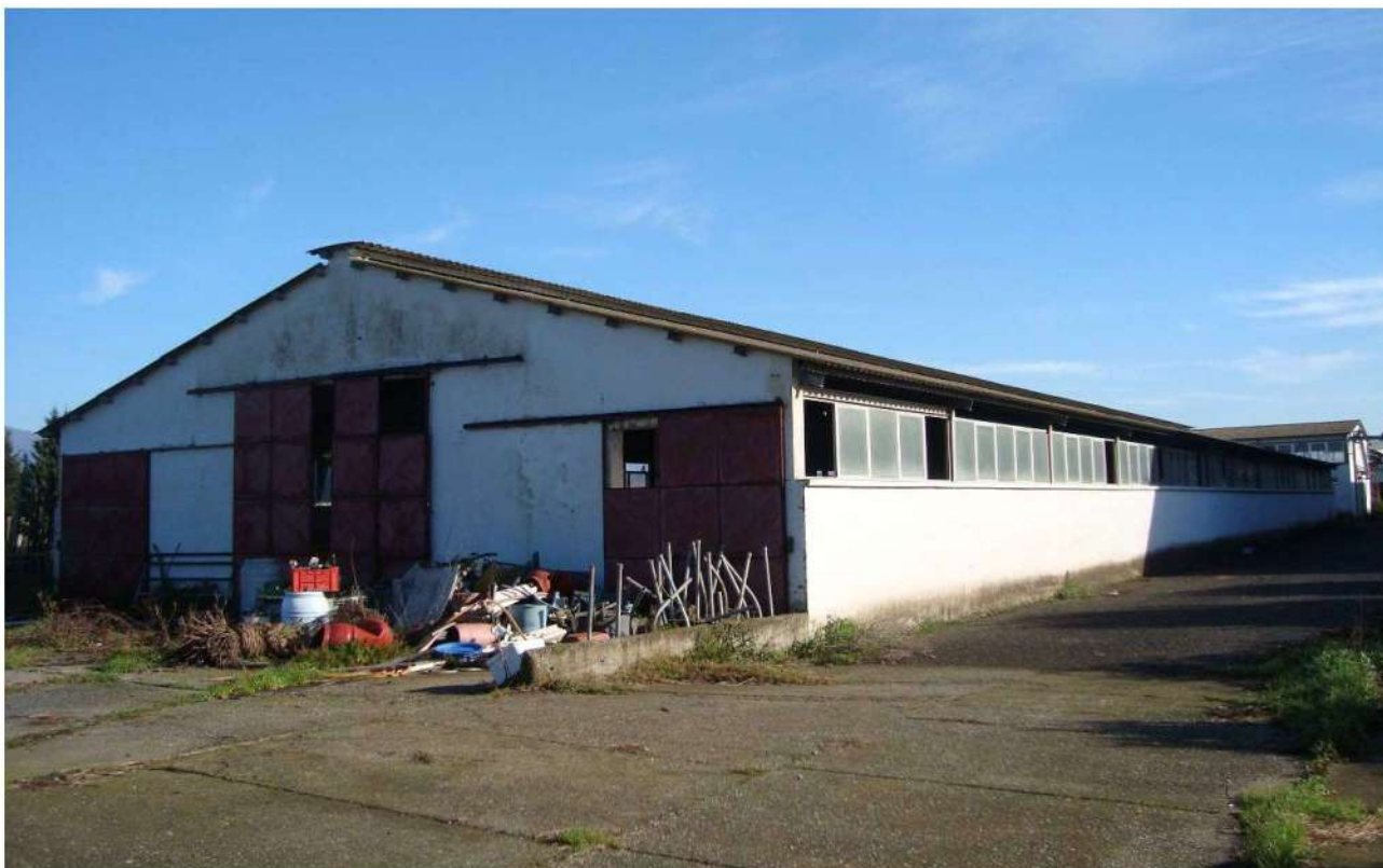
■ Figura 18 vista della particella 167 foglio 32 comune di Lamezia Terme – fabbricato stalla
