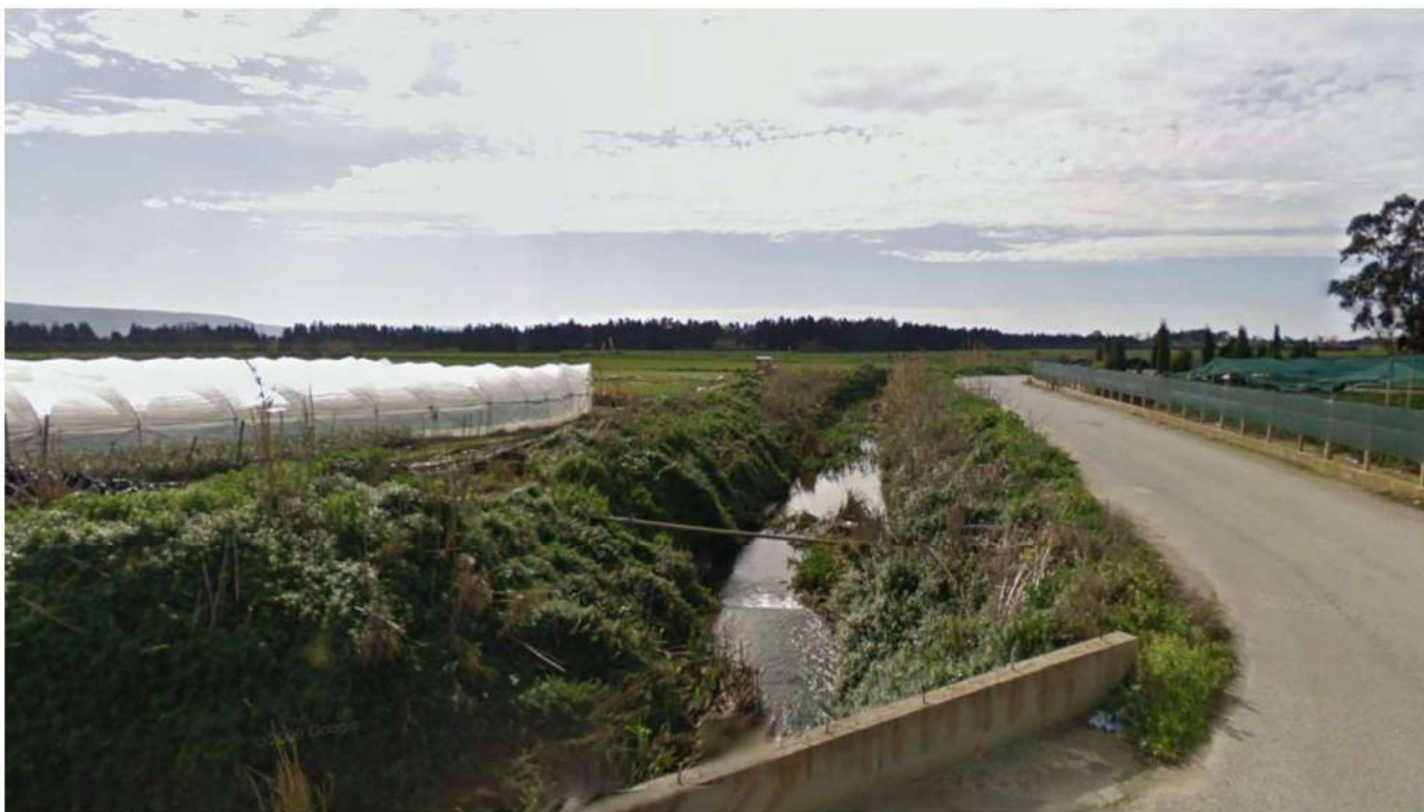
■ Figura 5 vista della part. 26 f.32, del lotto 1
