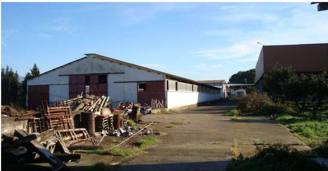
■ Figura 18 vista della particella 167 foglio 32 comune di Lamezia Terme – fabbricato stalla
