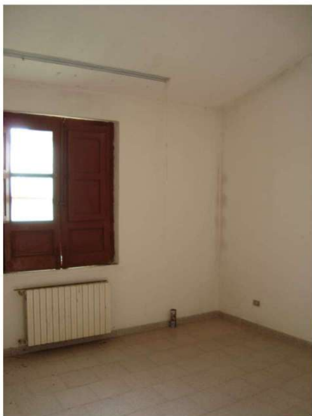
■ Figura 48 vista interna del fabbricato della particella 117 foglio 32 comune di Lamezia Terme
