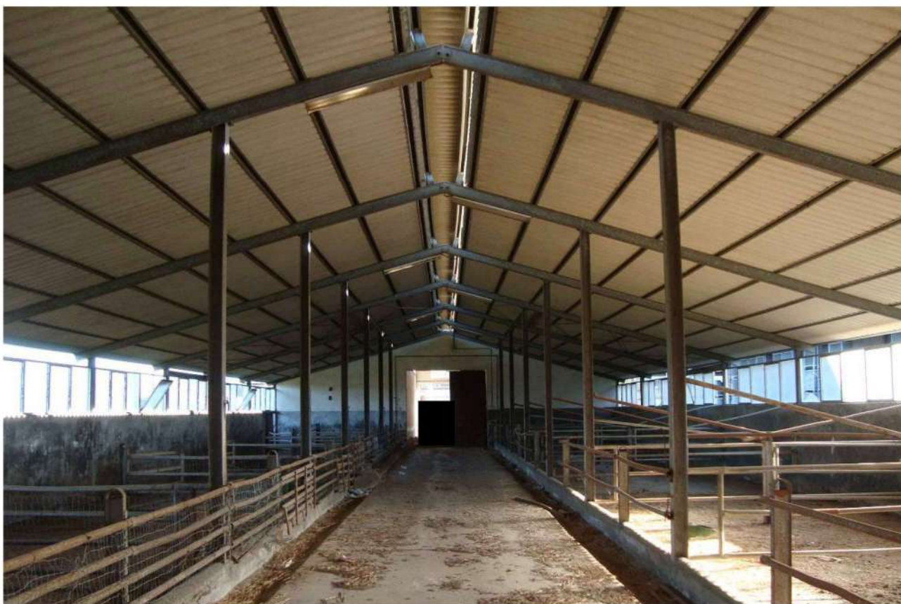
■ Figura 19 vista interna del fabbricato stalla della particella 167 foglio 32 comune di Lamezia Terme
