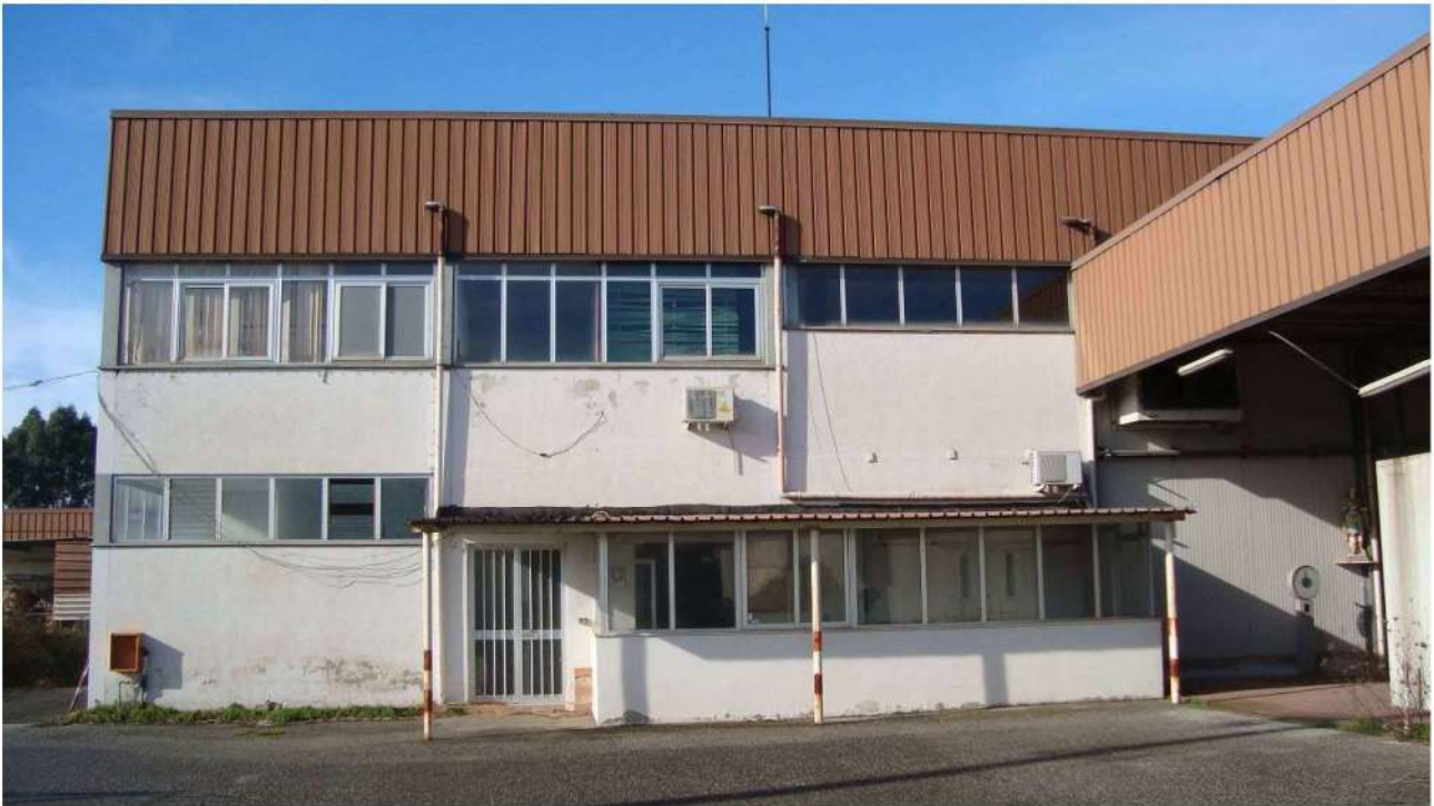
■ Figura 22 vista del fabbricato opificio della particella 52 foglio 32 comune di Lamezia Terme
