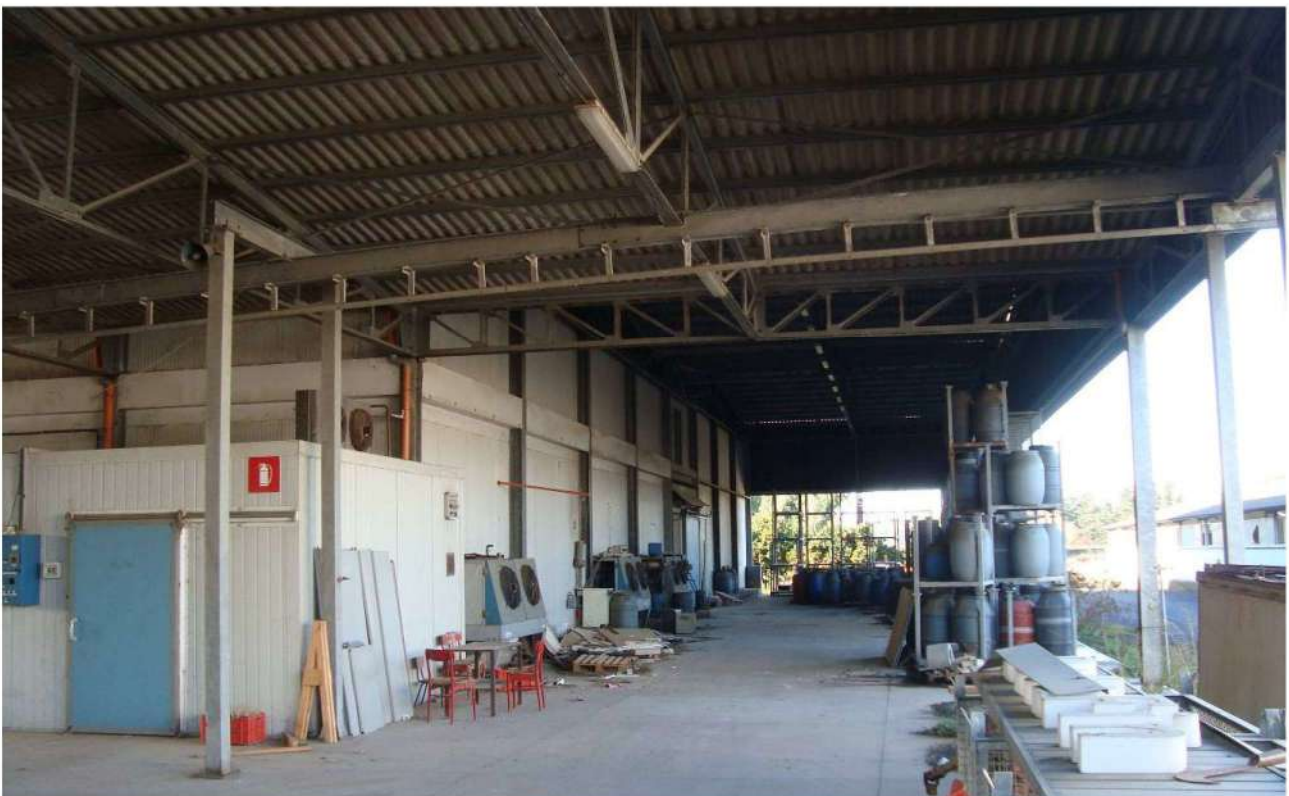
■ Figura 23 vista interna della tettoia del fabbricato opificio della particella 52 foglio 32 comune di Lamezia Terme
