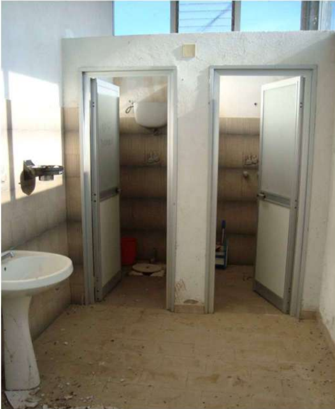
■ Figura 30 vista interna del fabbricato officio della particella 52 foglio 32 comune di Lamezia Terme
