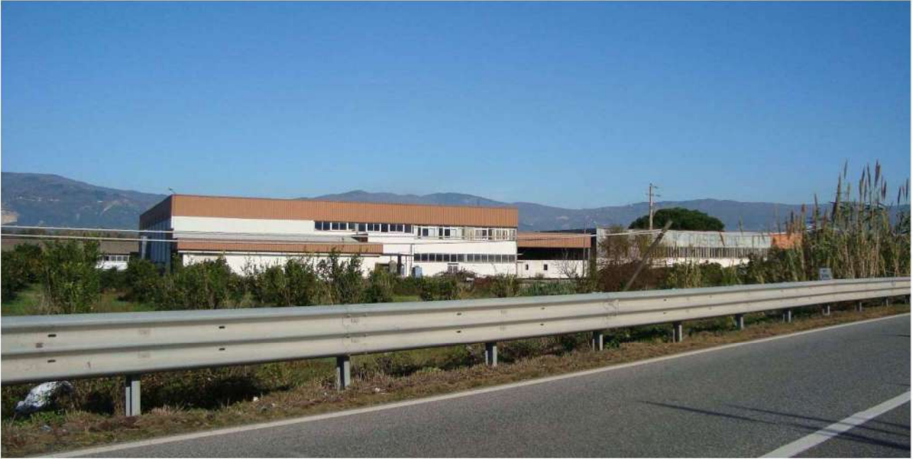
■ Figura 34 vista esterna del fabbricato opificio della particella 52 foglio 32 comune di Lamezia Terme
