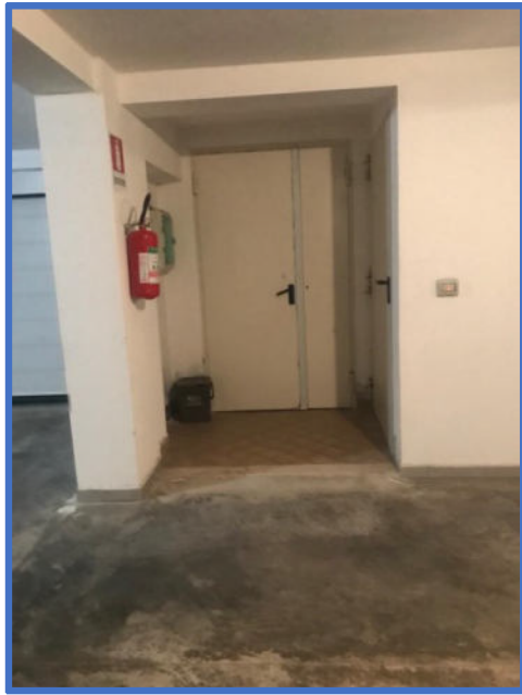
Accesso pedonale comunicazione con i piani residenziali
