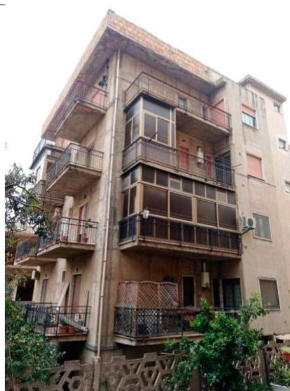
Foto 3. Vista esterna del fabbricato, prospetto posteriore Nord
