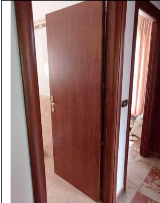
Foto 40. Particolare della tipologia di porta interna, in legno
