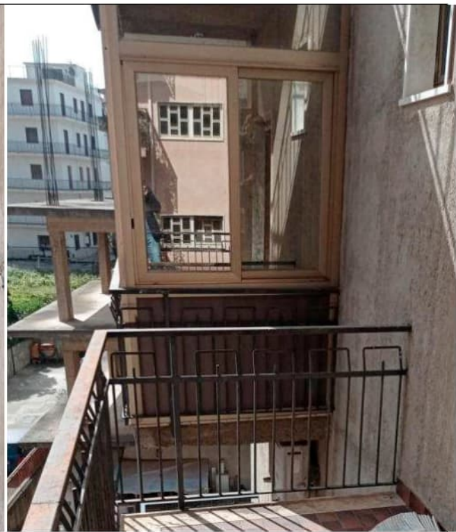
Foto 72. Particolare della Veranda 2, realizzata sul balcone Sud-Est
