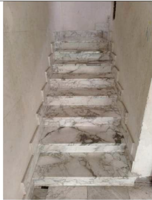
Foto 7. Particolare della prima rampa di scala del fabbricato
