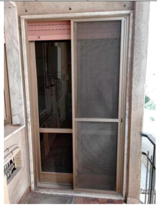
Foto 43. Particolare della tipologia di porta finestra, in alluminio, a due ante, con avvolgibili in PVC
