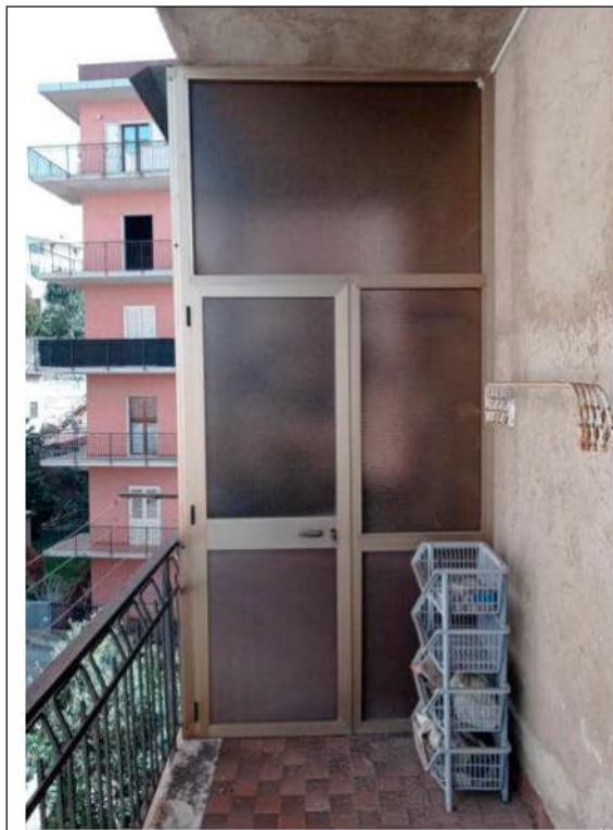
Foto 71. Particolare della Veranda 1, realizzata sul balcone Nord
