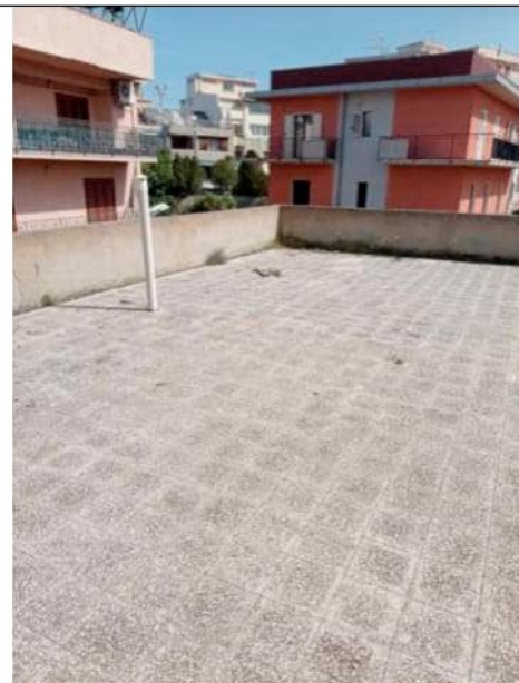
Foto 50. Vista della Terrazza
