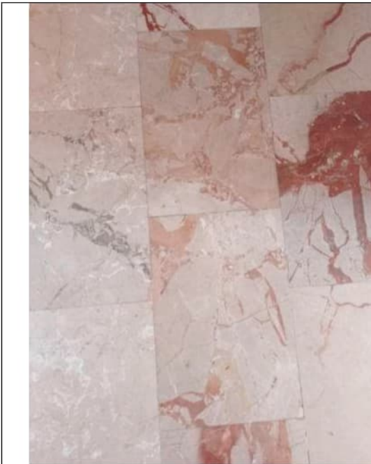
Foto 46. Particolare della tipologia di pavimentazione, in marmo, presente nell'immobile, al piano terzo (quarto f.t.)
