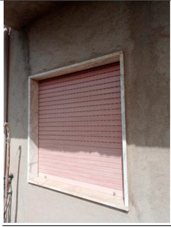
Foto 45. Particolare della tipologia di avvolgibili in PVC
