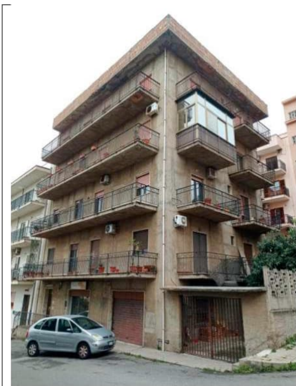
Foto 2. Vista esterna del fabbricato, prospetto principale Sud e prospetto laterale Est
