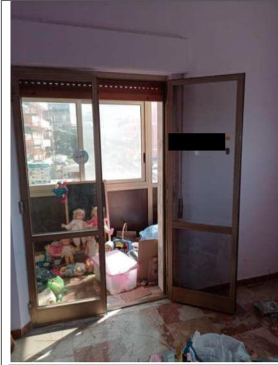
Foto 44. Particolare della tipologia di porta-finestra, in alluminio, a due ante, con avvolgibili in PVC, vista dall'interno
