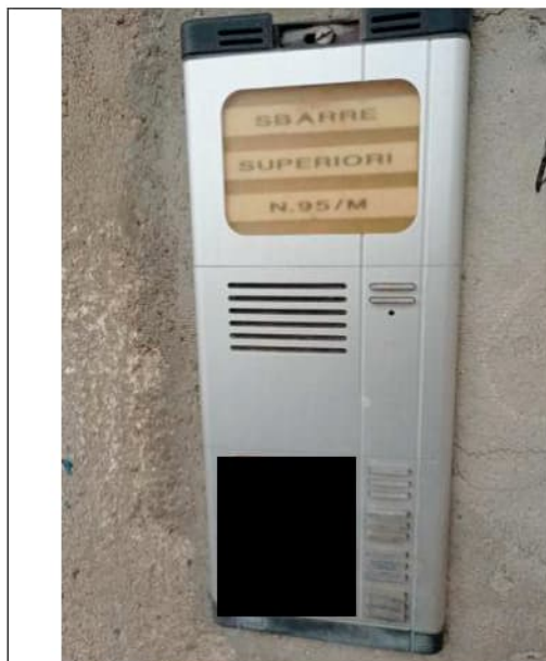
Foto 22. Particolare del citofono posto all'esterno del fabbricato
