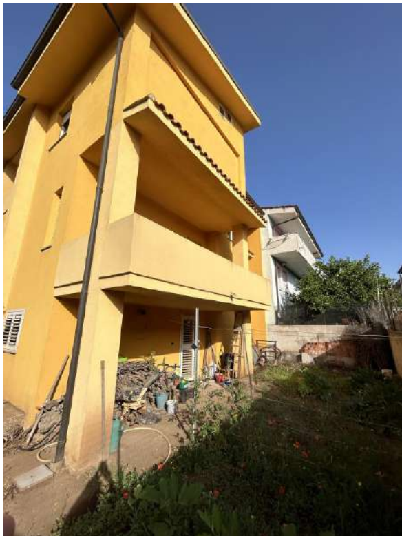
Foto 11 Vista prospetto posteriore da cortile
