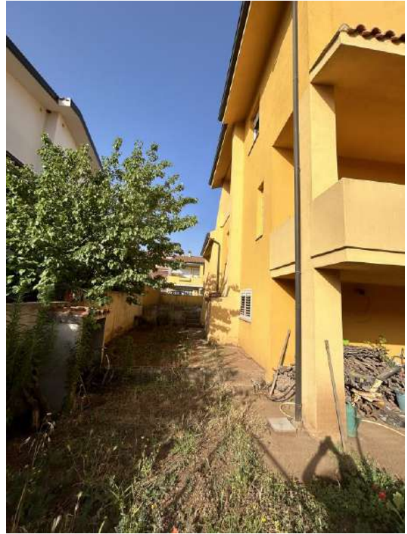
Foto 10 Vista prospetto laterale da cortile
