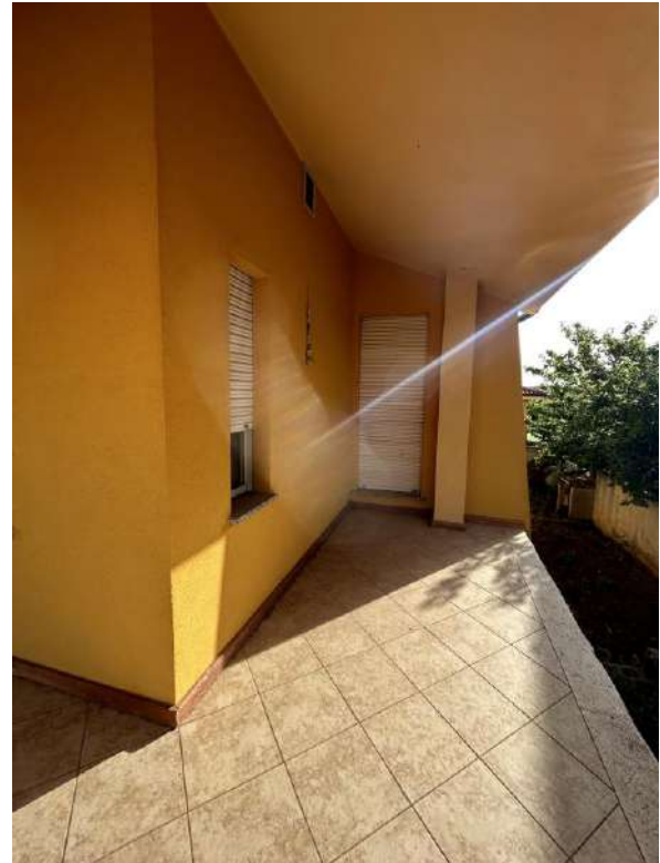
Foto 78 Vista interna veranda 1 prospetto laterale
