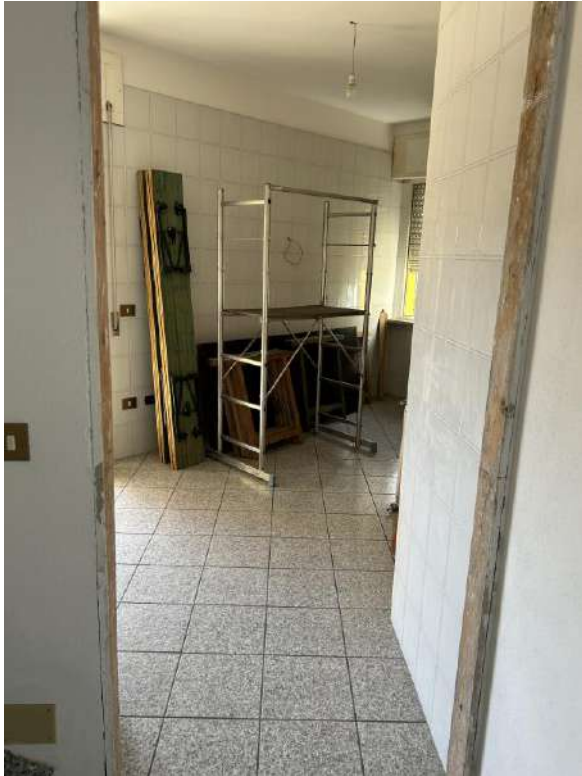
Foto 65 Vista interna cucina
