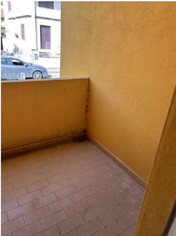
Foto 83 Vista interna veranda 2 prospetto frontale
