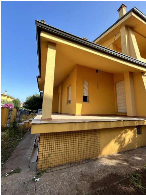
Foto 7 Vista prospetto laterale da cortile
