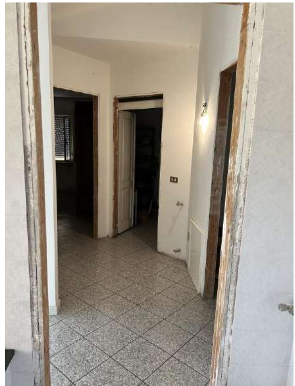
Foto 108 Vista interna disimpegno
