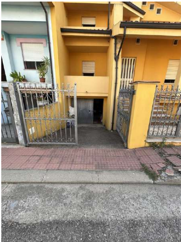
Foto 19 Vista cancello carraio da Via R. Piras
