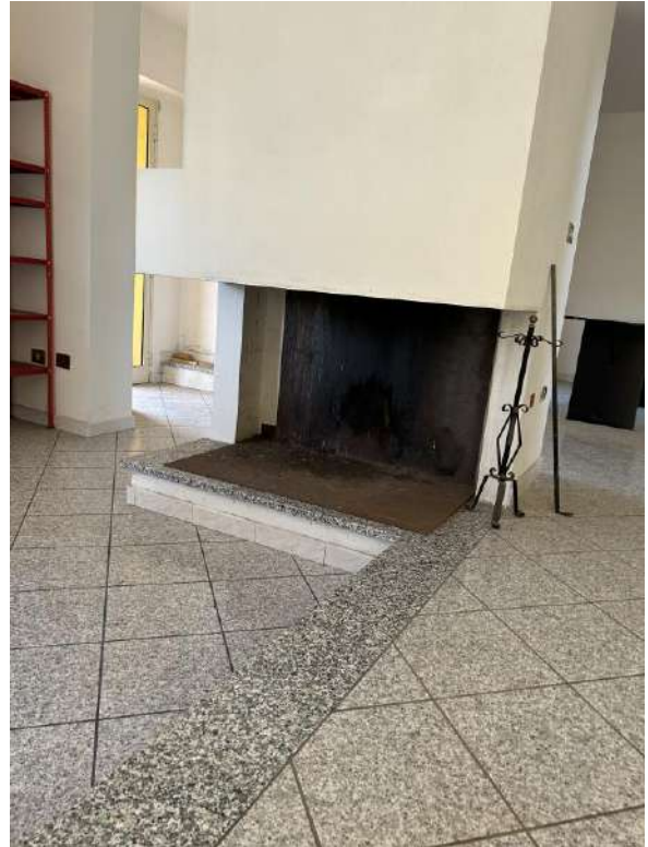
Foto 62 Particolare camino nel soggiorno
