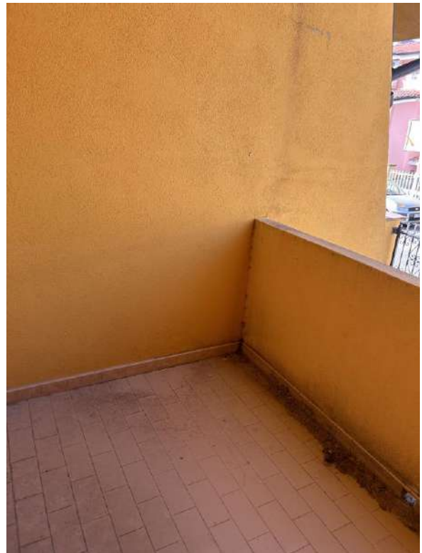
Foto 84 Vista interna veranda 2 prospetto frontale
