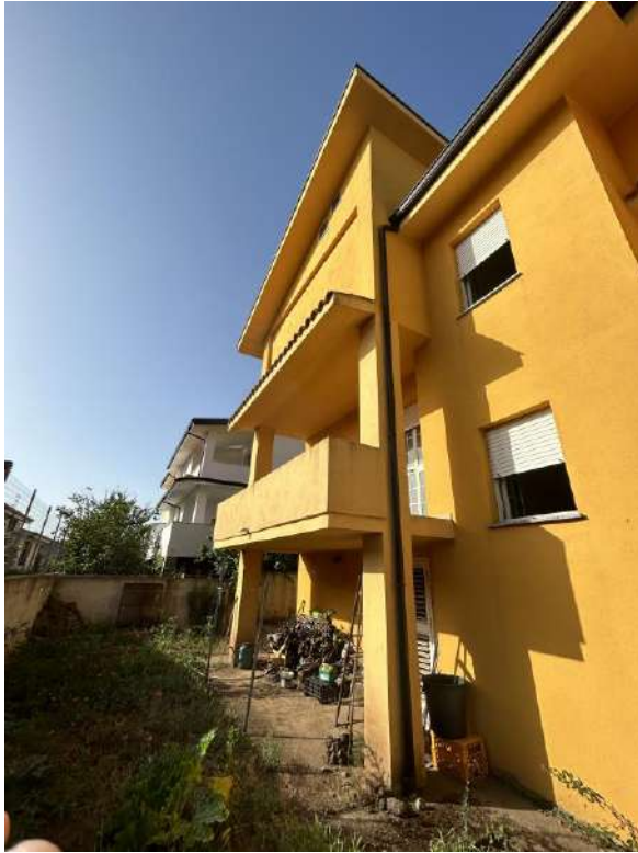
Foto 13 Vista prospetto posteriore da cortile
