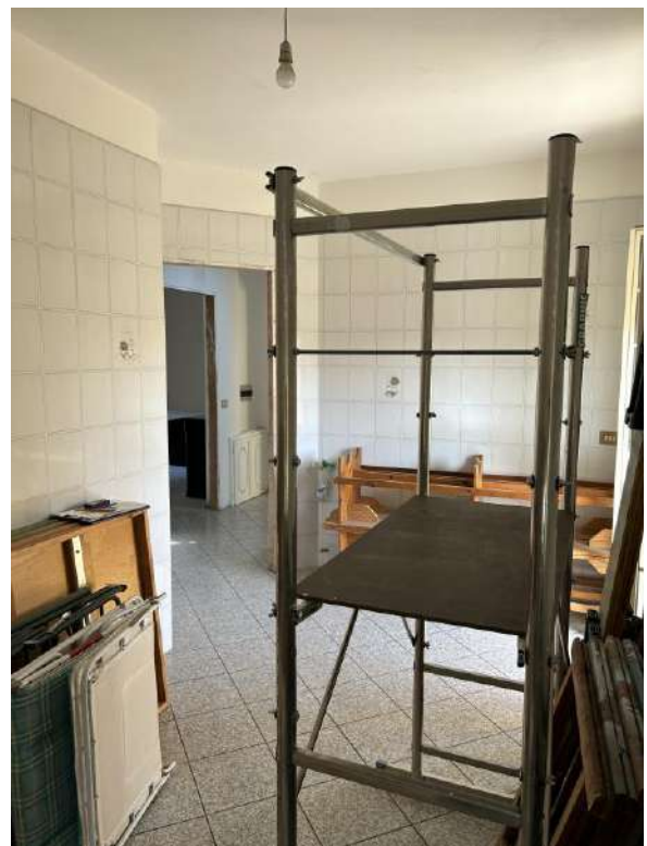
Foto 68 Vista interna cucina
