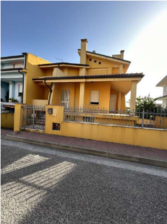
Foto 1 Vista prospetto frontale da Via R. Piras
