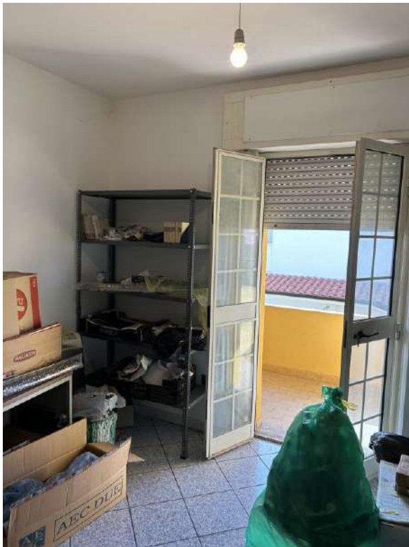
Foto 91 Particolare porta finestra camera 1
