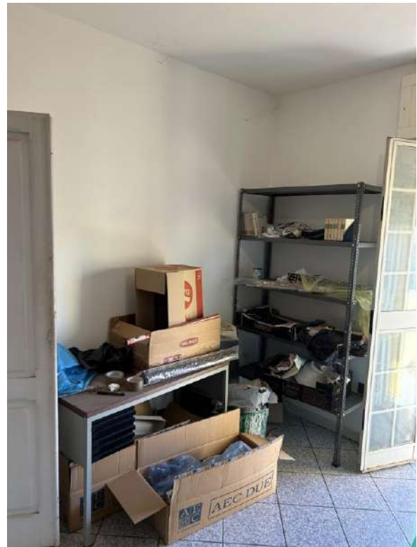
Foto 92 Vista interna camera 1
