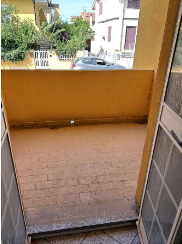
Foto 81 Vista interna veranda 2 prospetto frontale
