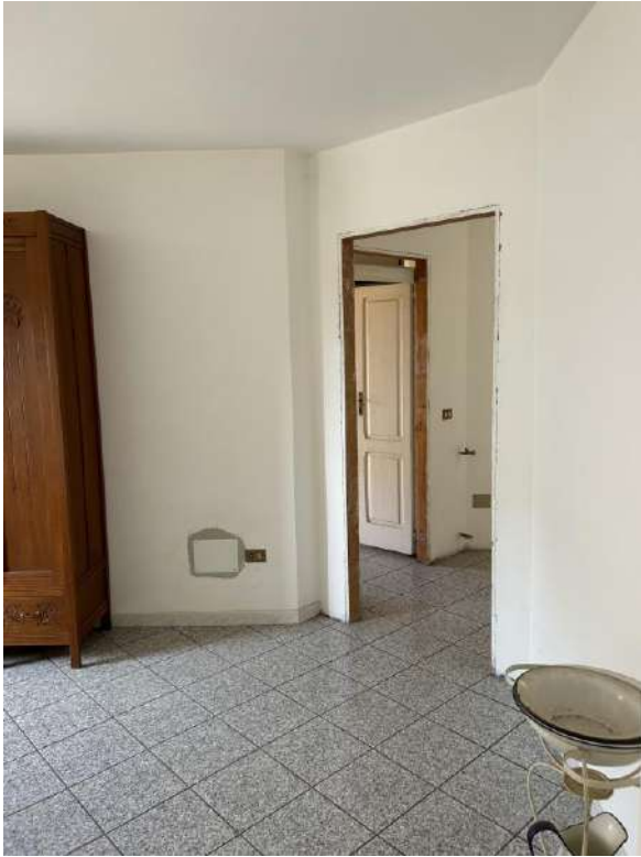
Foto 101 Vista interna camera 3
