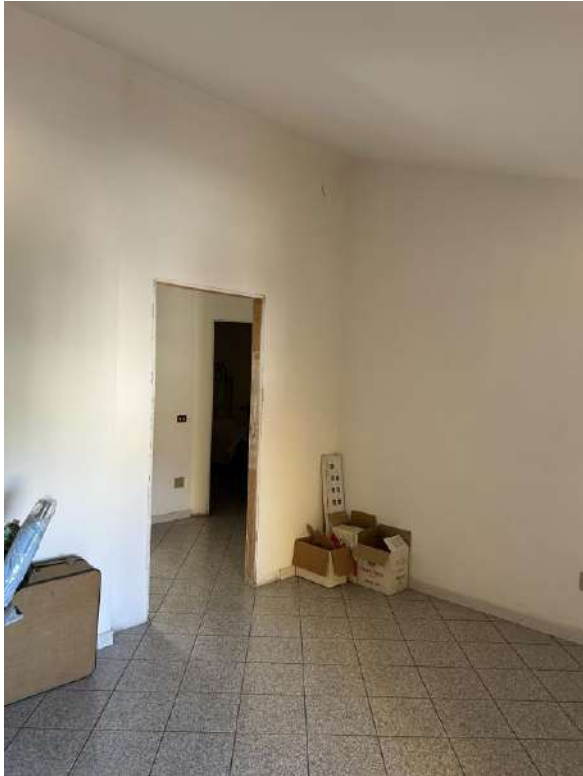
Foto 97 Vista interna camera 2
