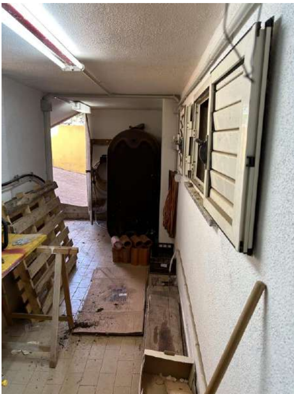
Foto 131 Vista interna locale tecnico
