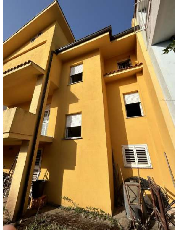
Foto 14 Vista prospetto posteriore da cortile
