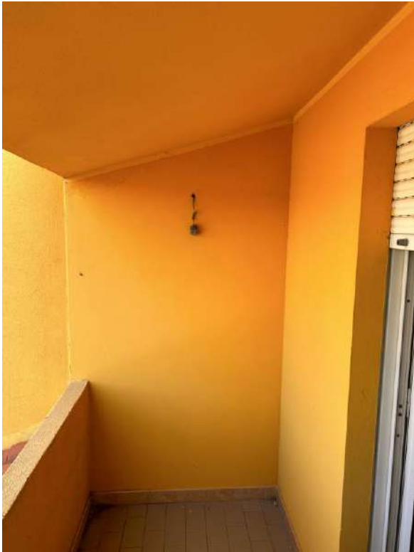
Foto 109 Vista interna balcone 1 prospetto frontale
