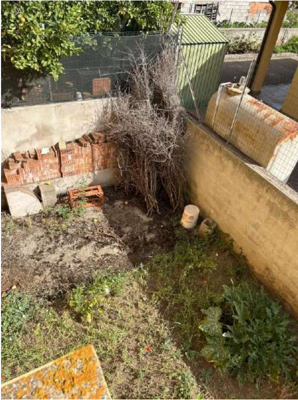
Foto 125 Vista cortile posteriore dal piano terra
