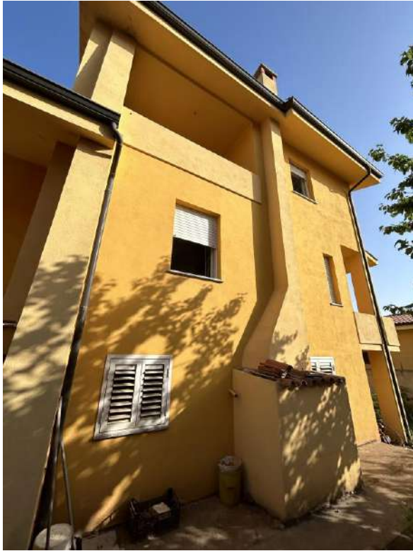
Foto 9 Vista prospetto laterale da cortile
