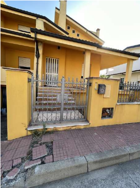
Foto 49 Vista cancello pedonale da Via R. Piras
