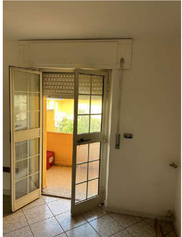
Foto 98 Particolare porta finestra camera 2
