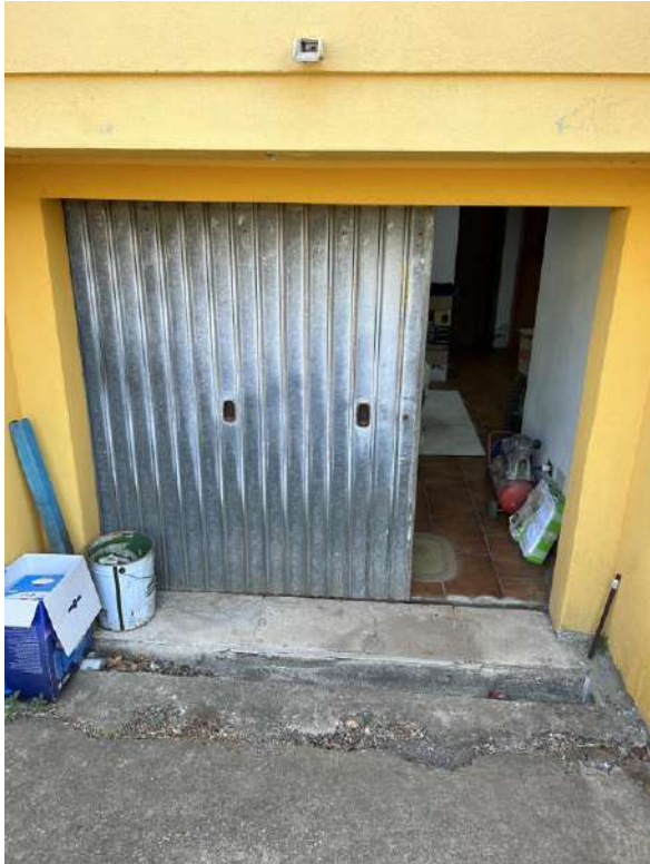
Foto 21 Vista serranda accesso garage dallo scivolo
