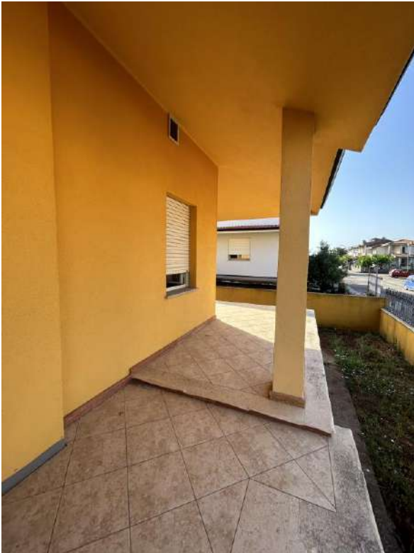
Foto 77 Vista interna veranda 1 prospetto frontale
