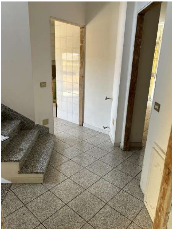
Foto 75 Vista interna disimpegno
