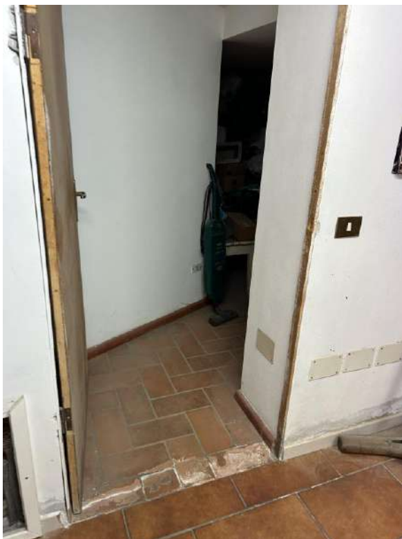
Foto 39 Particolare porta accesso cantina
