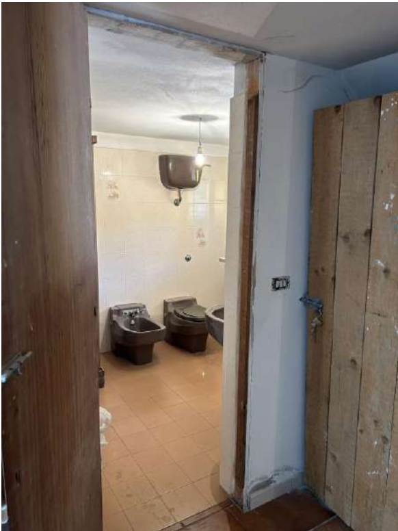
Foto 35 Vista interna bagno
