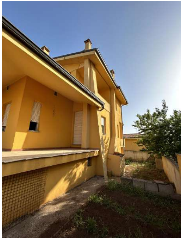
Foto 8 Vista prospetto laterale da cortile
