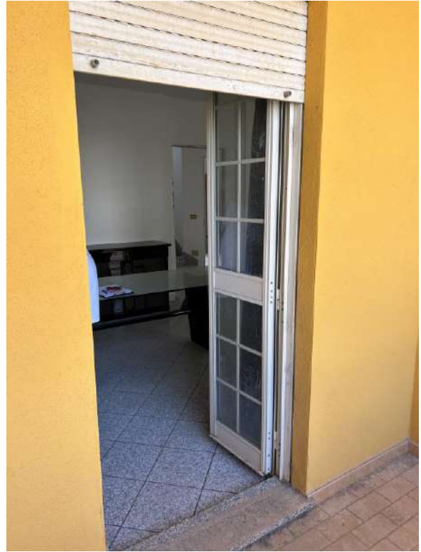
Foto 82 Vista interna veranda 2 prospetto frontale
