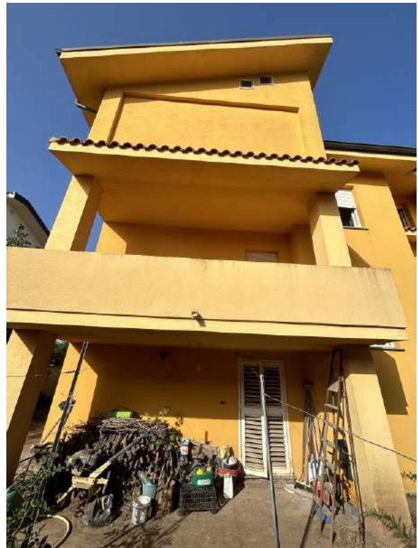
Foto 12 Vista prospetto posteriore da cortile
