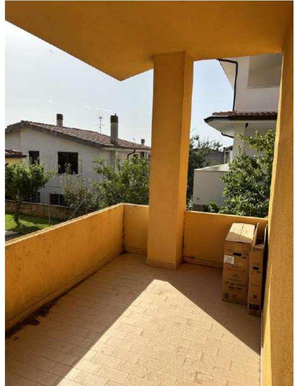
Foto 86 Vista interna veranda 3 prospetto posteriore
