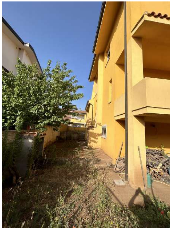
Foto 119 Vista interna cortile laterale
