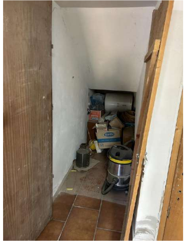
Foto 46 Vista interna nel sottoscala
