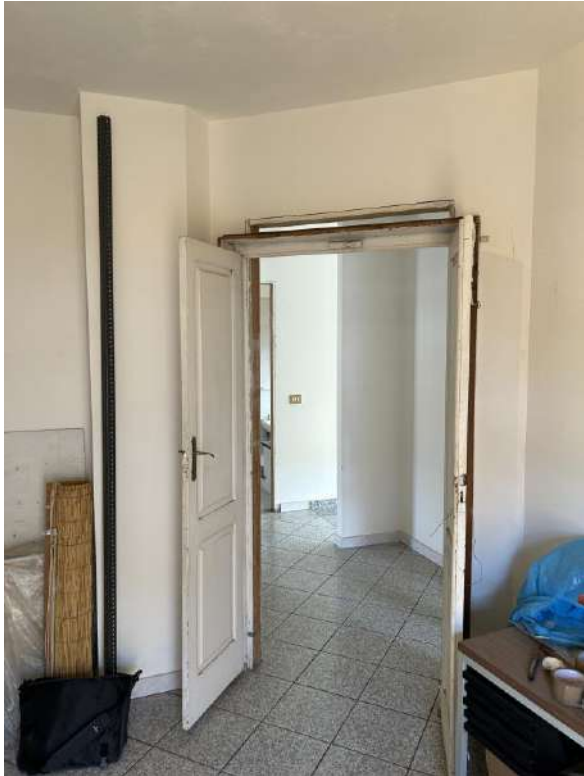
Foto 93 Vista interna camera 1
