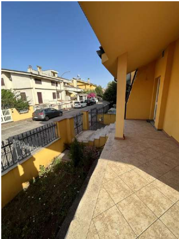
Foto 79 Vista interna veranda 1 prospetto frontale
