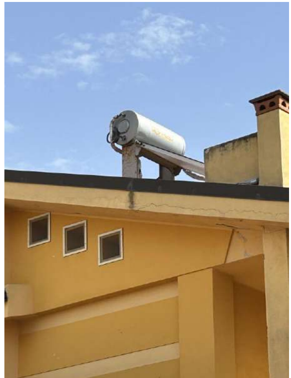
Foto 144 Particolare pannelli impianto solar termico e serbatoio di accumulo per acqua calda sanitaria
