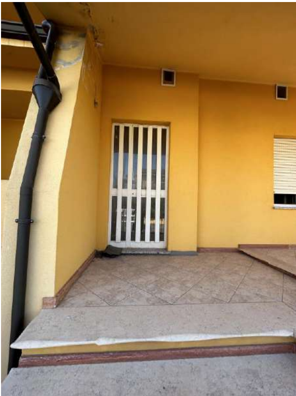
Foto 51 Vista esterna porta ingresso piano terra
