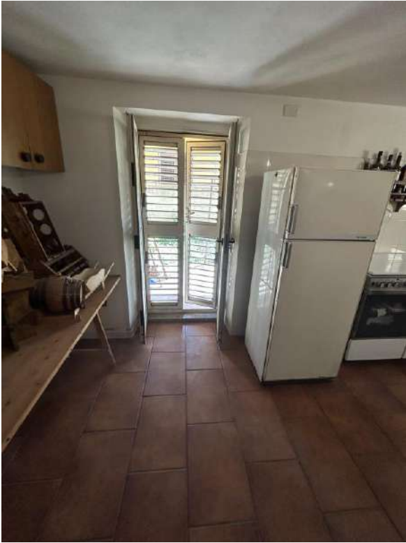
Foto 33 Particolare porta finestra Locale di sgombero
