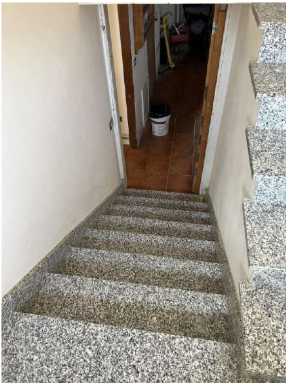
Foto 43 particolare vano scala
