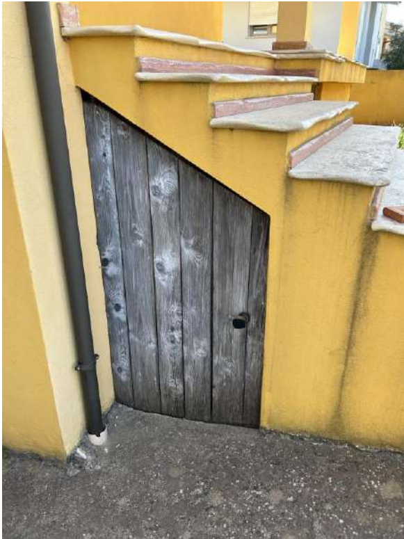
Foto 127 particolare porta ingresso locale tecnico
