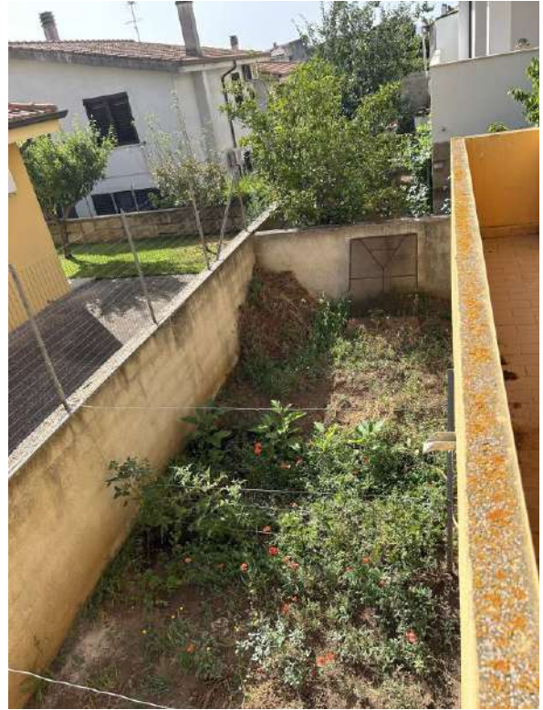
Foto 126 Vista cortile posteriore dal piano terra
