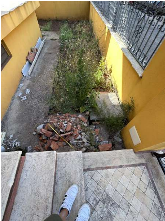
Foto 115 Vista interna cortile anteriore
