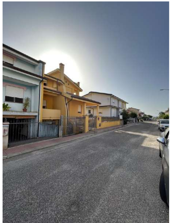
Foto 4 Vista prospetto frontale da Via R. Piras
