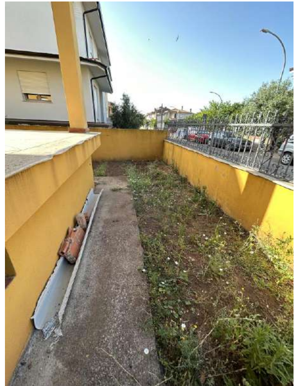
Foto 116 Vista interna cortile anteriore
