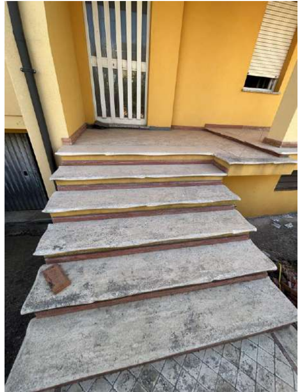
Foto 50 Particolare scala accesso al piano terra da Via R. Piras
