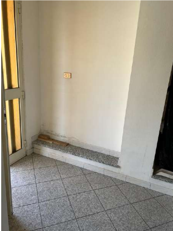
Foto 53 Vista interna ingresso
