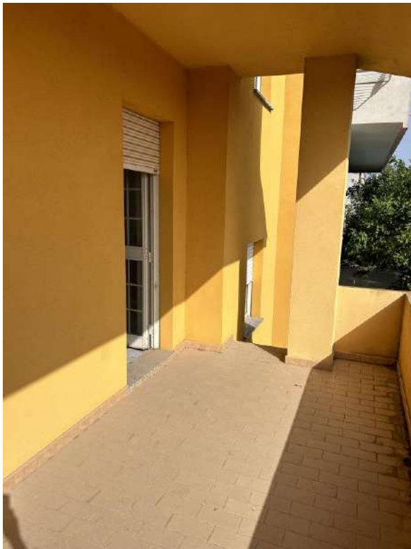
Foto 87 Vista interna veranda 3 prospetto posteriore
