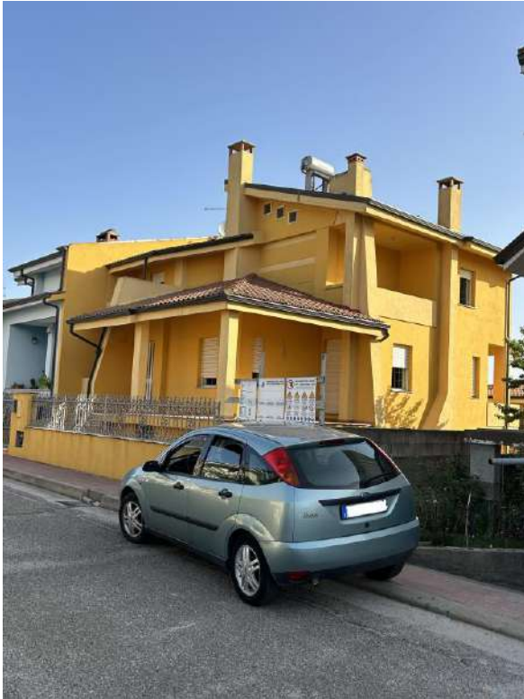
Foto 5 Vista prospetto laterale da Via R. Piras
