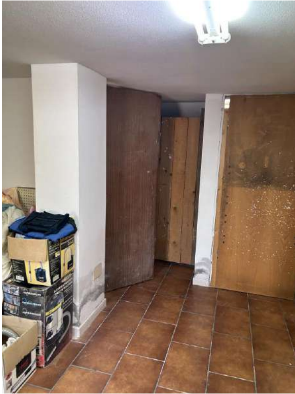
Foto 45 Vista zona disimpegno vano scala
