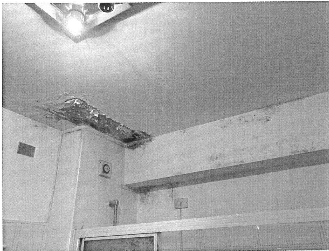
Foto 20 – bagno, particolare a soffitto
