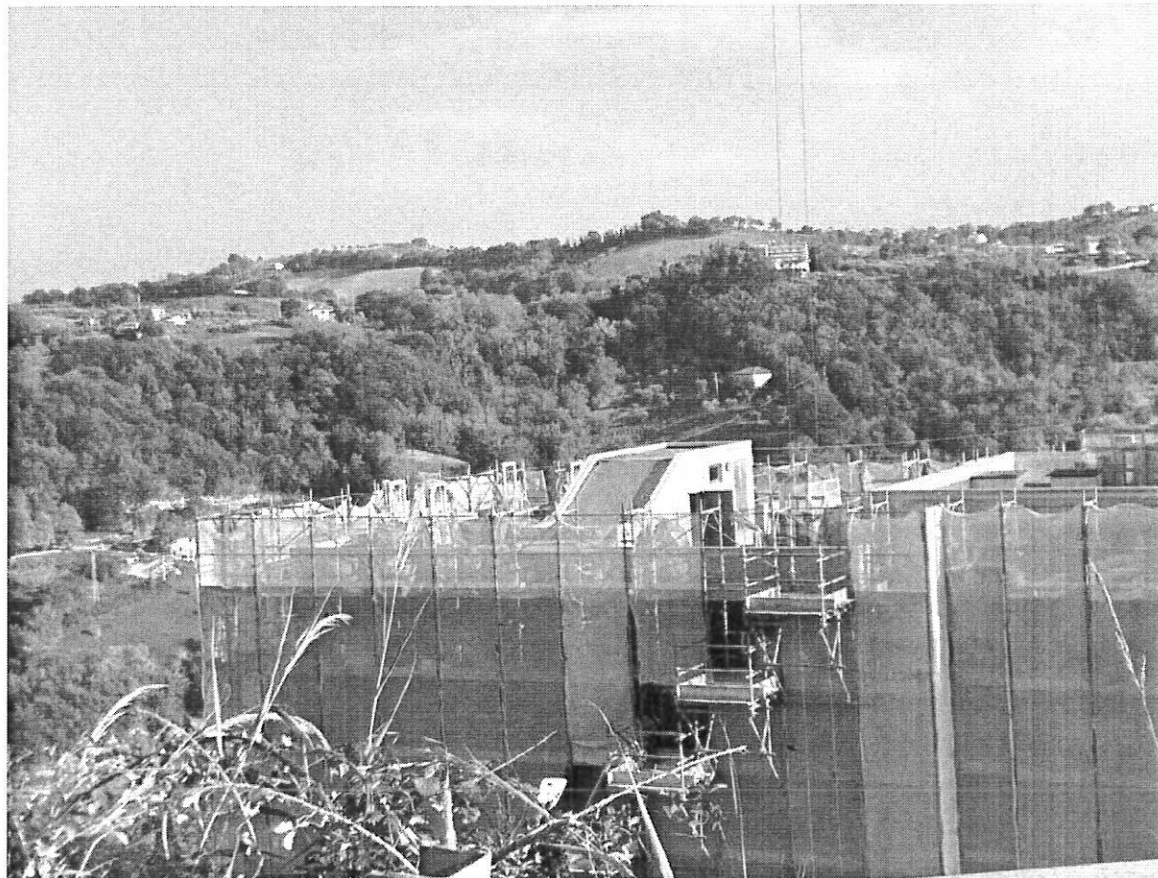
Foto 2 – fronte Nord-Ovest del corpo di fabbrica al civ. n. 5 da Via Fano
