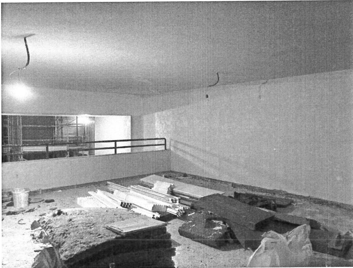
Foto 22 – posto auto coperto a piano terra
