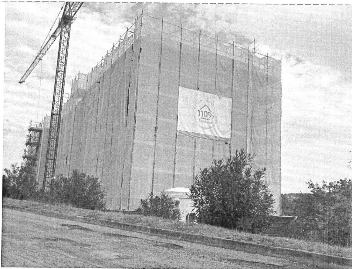
Foto 3 – lato Sud-Ovest da Via Fano
