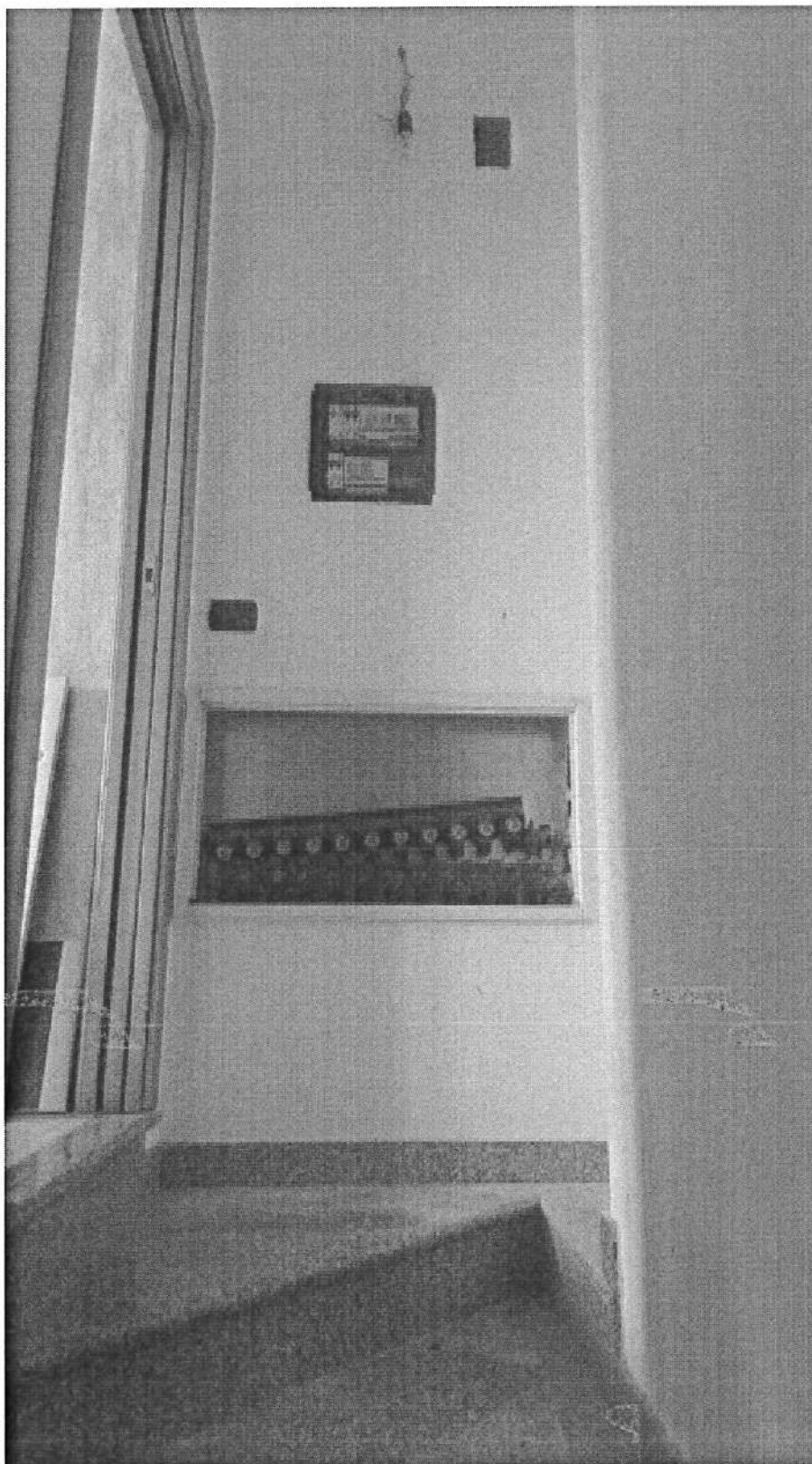
PVF 16 – Scala interna
