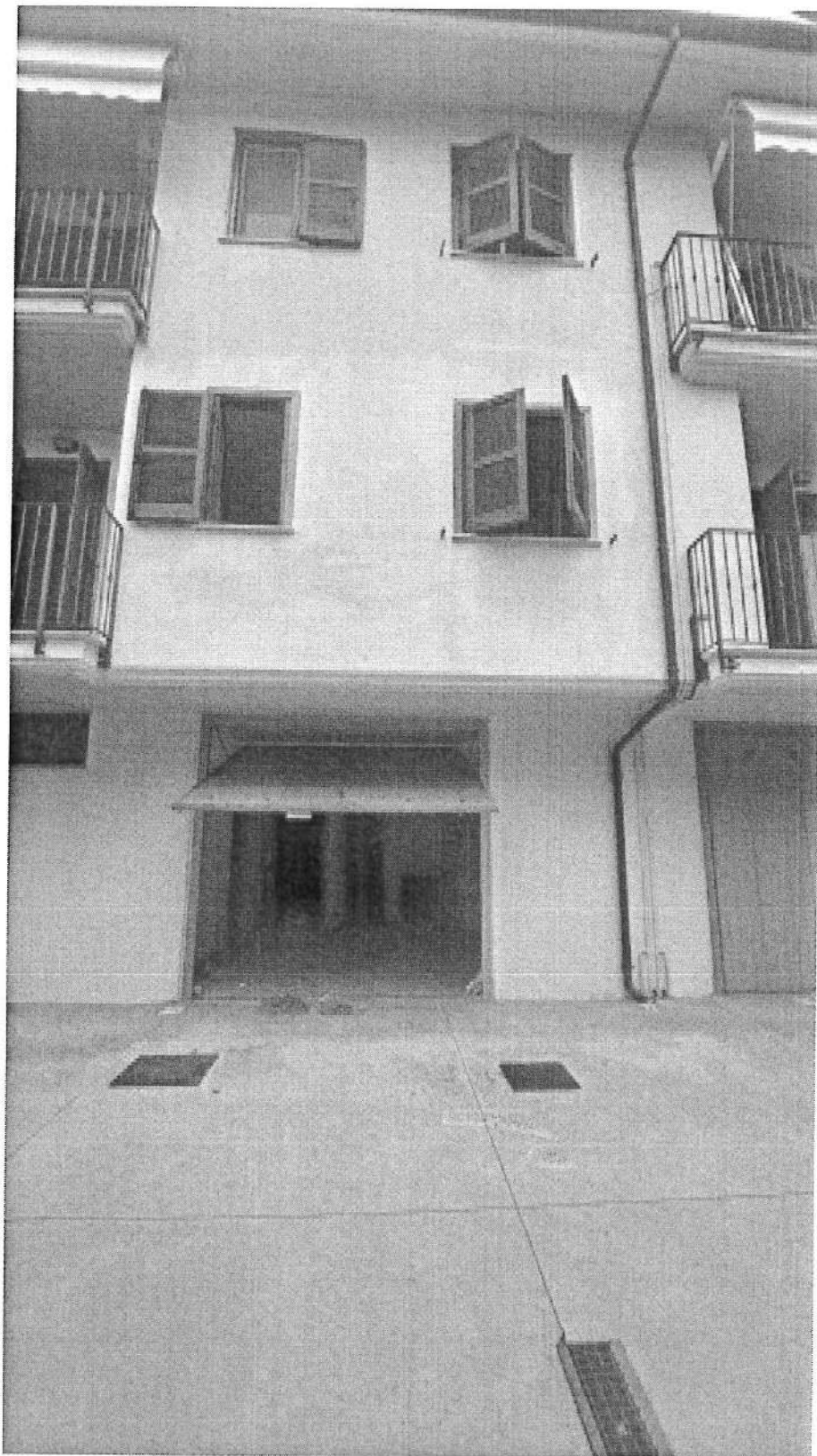
PVF 1 – Ingresso al Piano Sottostrada garage
