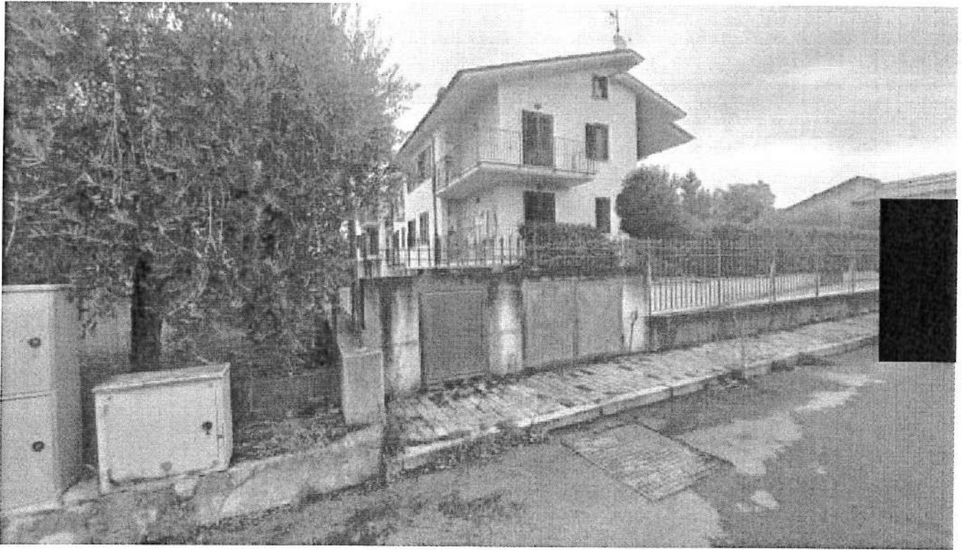
PVF 53 - Contatore metano ed acqua posto su fronte Via Sacconi a circa 30 m dall'ingresso carrabile sulla proprietà condominiale
