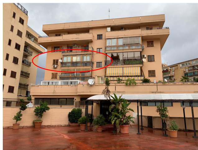
Foto 01 (prospetto interno edificio "E")
