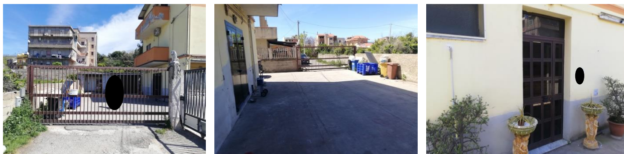
Vista dell'area esterna del fabbricato (riproduzione completa in All.04).
