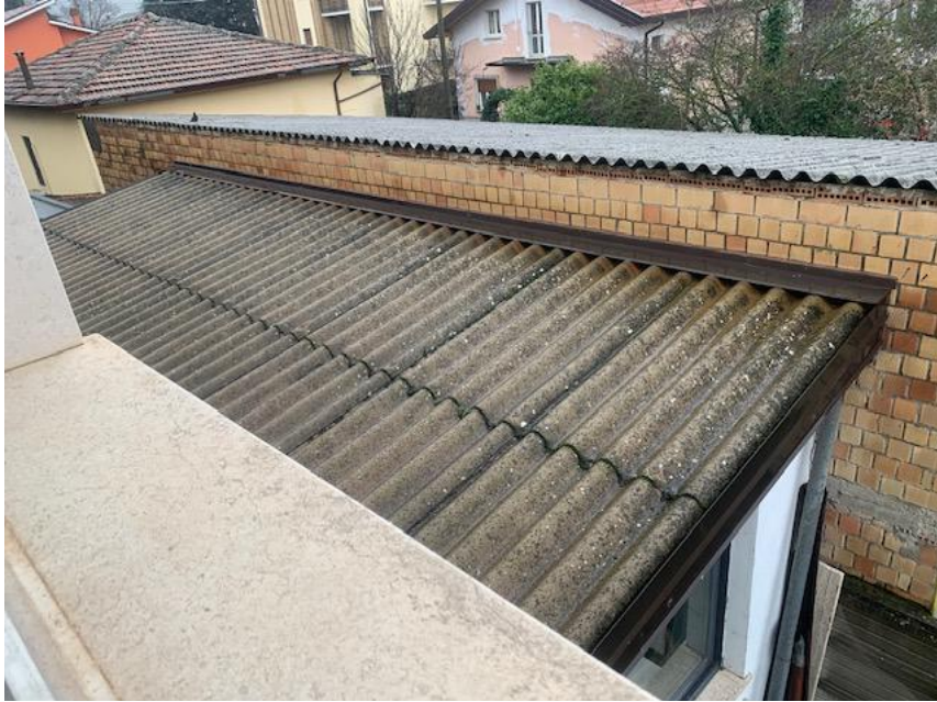
FOTO ESTERNA – RIPOSTIGLIO ESTERNO
