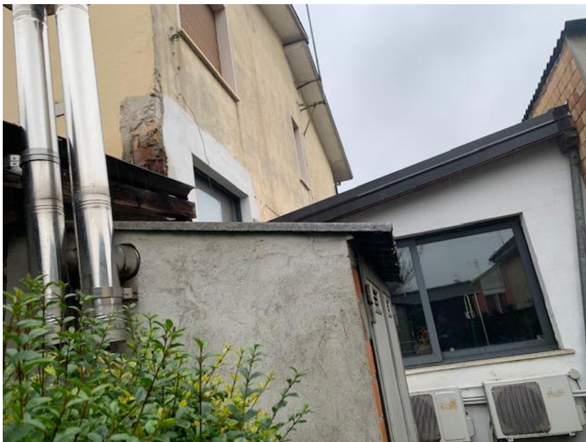
FOTO ESTERNA – RIPOSTIGLIO ESTERNO
