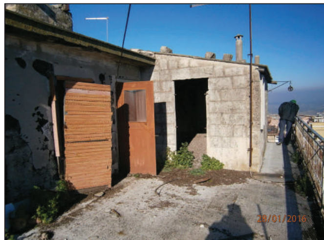
Foto 24 : terrazzo di copertura con vano forno
