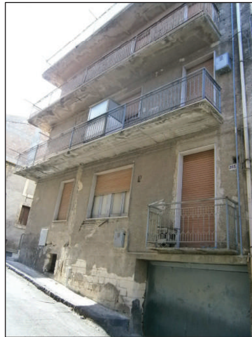
Foto 2: Vista dello stabile su via Archimede - Carlentini (SR)
