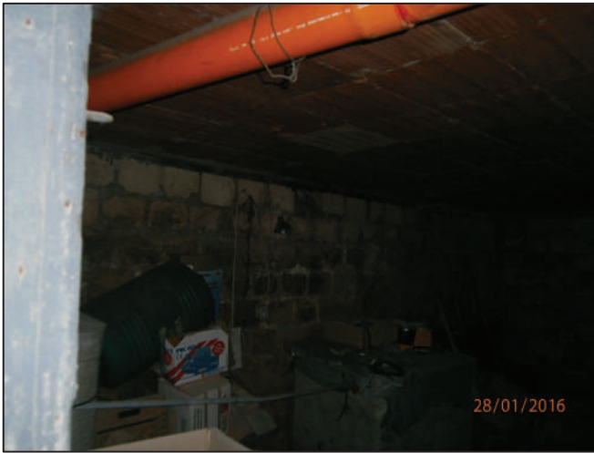
Foto 25 : interno vano garage
