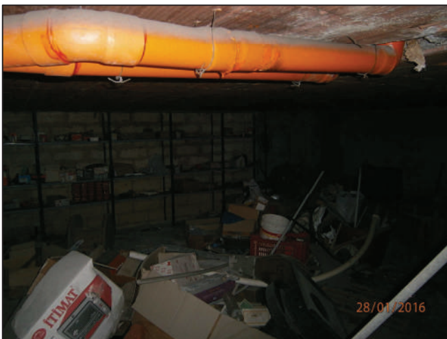
Foto 28: interno del vano garage
