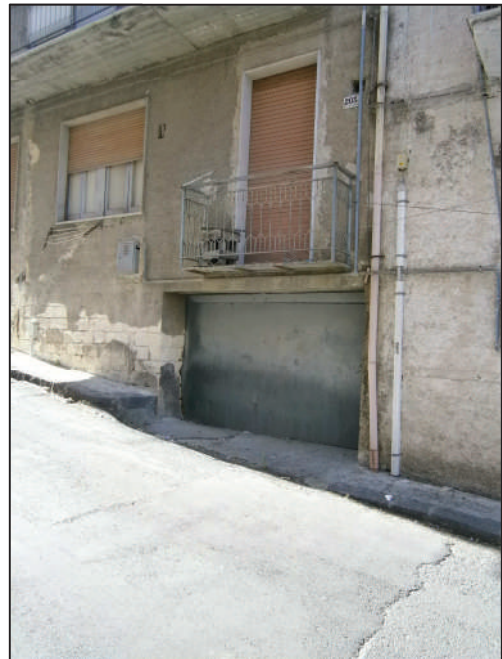
Foto 27 : accesso al vano garage a p.terra su via Archimede
