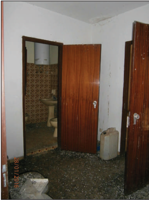
Foto 15 : ingresso 2 a piano 2°
