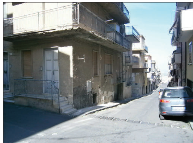
Foto 29 : vista dell'accesso al garage su via Archimede .
