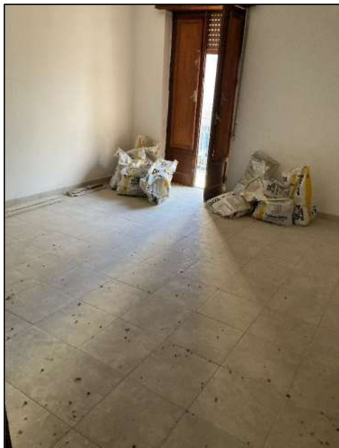
Foto n. 9 : vista vano soggiorno 1 a piano primo
