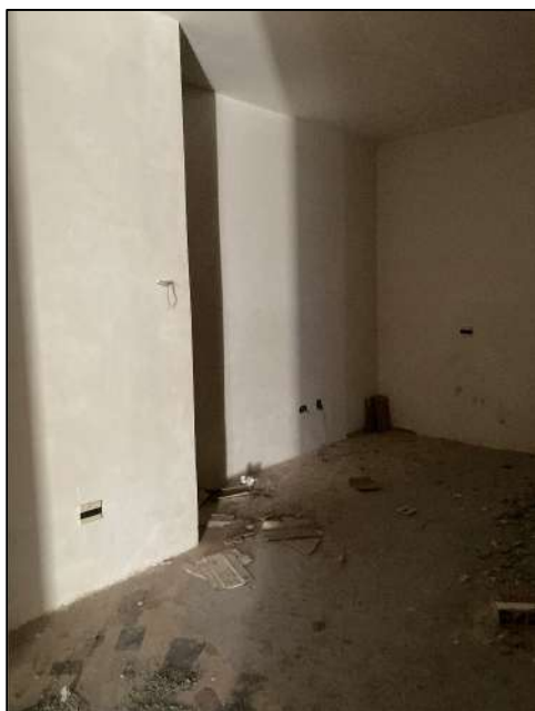
Foto 7 : vista vano privo di tramezzi
