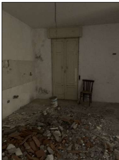
Foto 8 : ambiente unico con tramezzi demoliti
