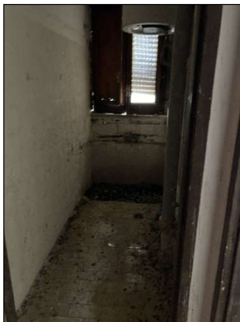
Foto 12 : wc 1 a piano primo
