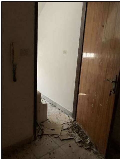
Foto n. 13 : vista ingresso 1 a piano primo
