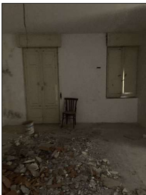
Foto 3: vista del grande vano a p.terra dopo demolizione tramezzi
