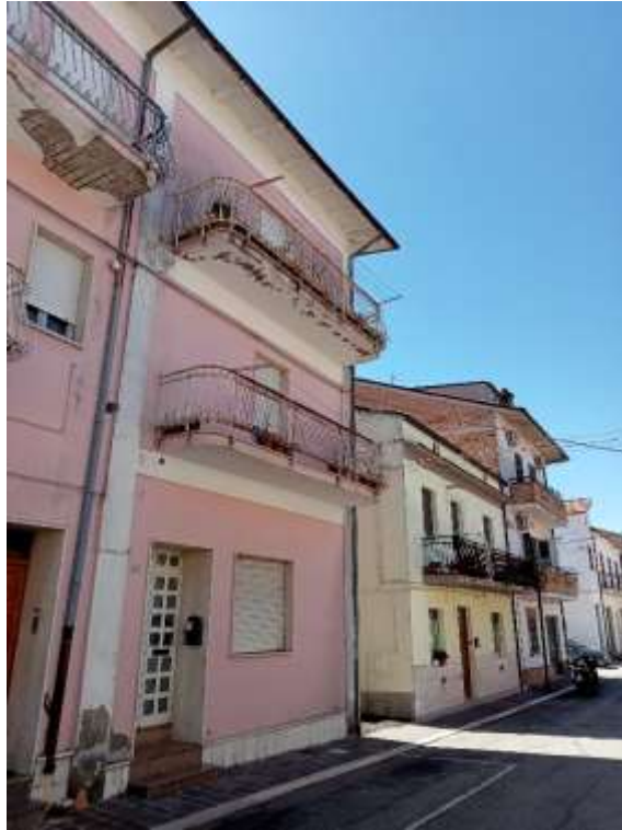
Foto n° 2 di 4 – Vista esterna del fabbricato (Prospetto su corso Duca degli Abruzzi)
