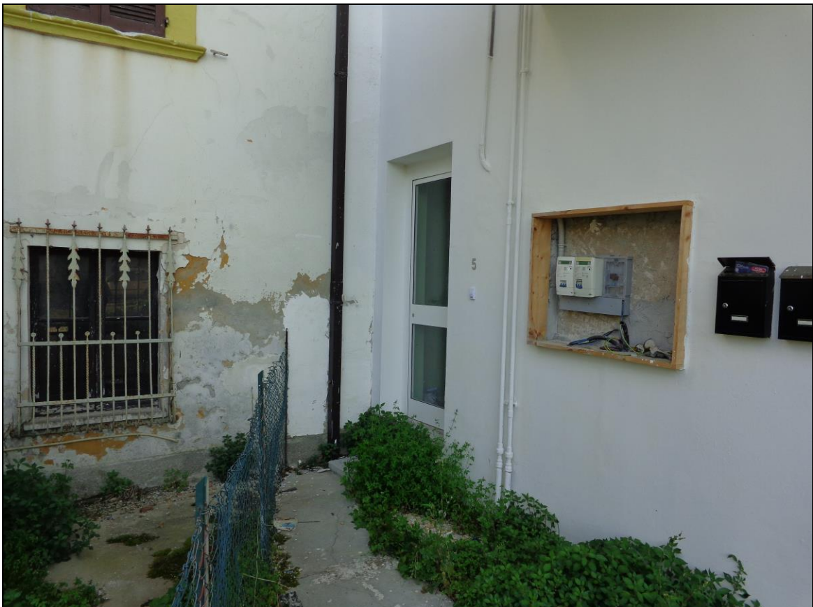
foto n. 2 – Esterno fabbricato particolare accesso vano scala
