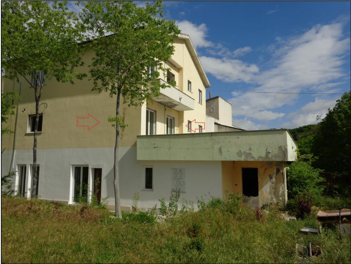
foto n. 1 – Esterno fabbricato con indicazione appartamento pignorato al piano primo
