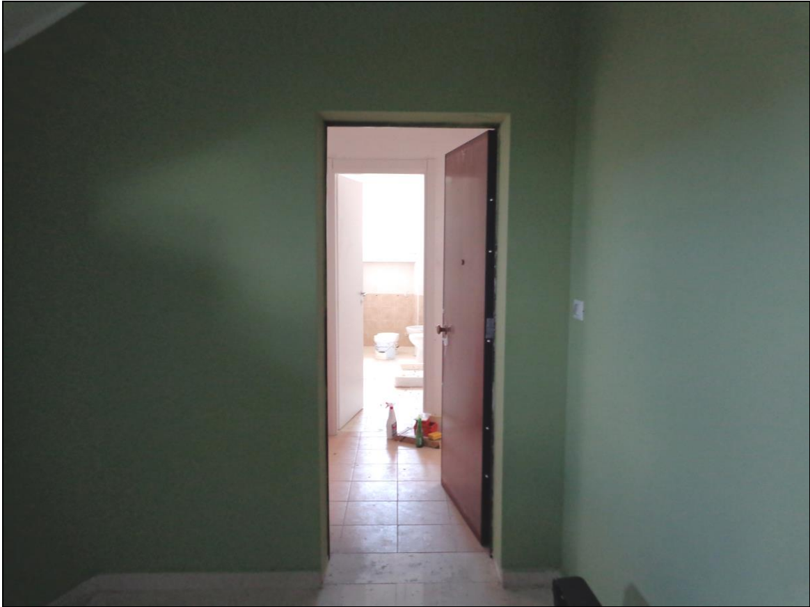
Foto n. 3 – Particolare accesso dal vano scala all'appartamento pignorato al piano primo.
