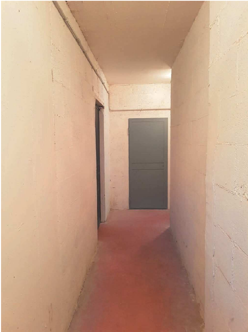
Ingresso al locale magazzino particella 777 sub 58 e particella 776 sub 30
