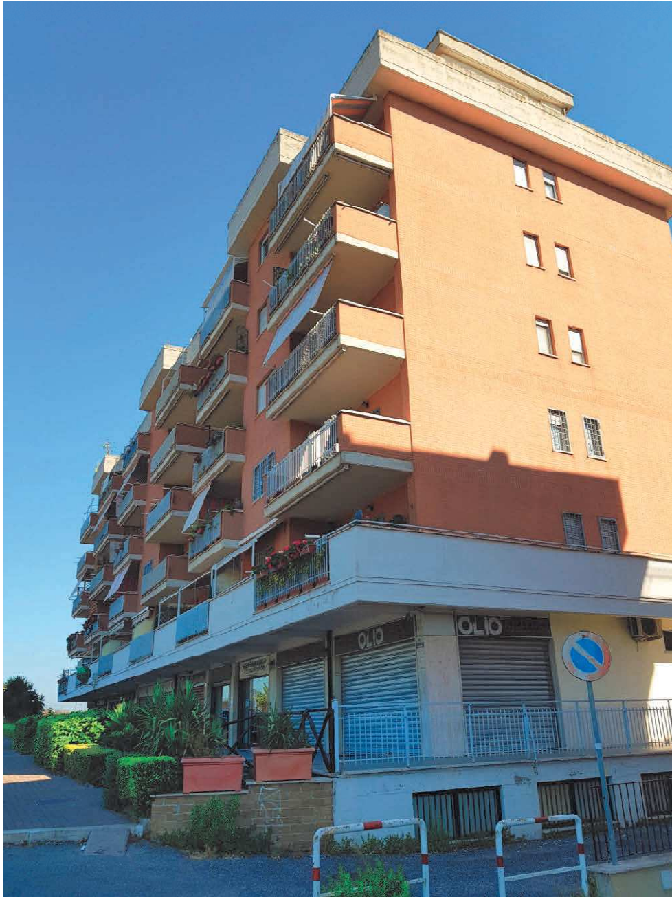
Vista esterna dell'edificio da Viale Baseggio
