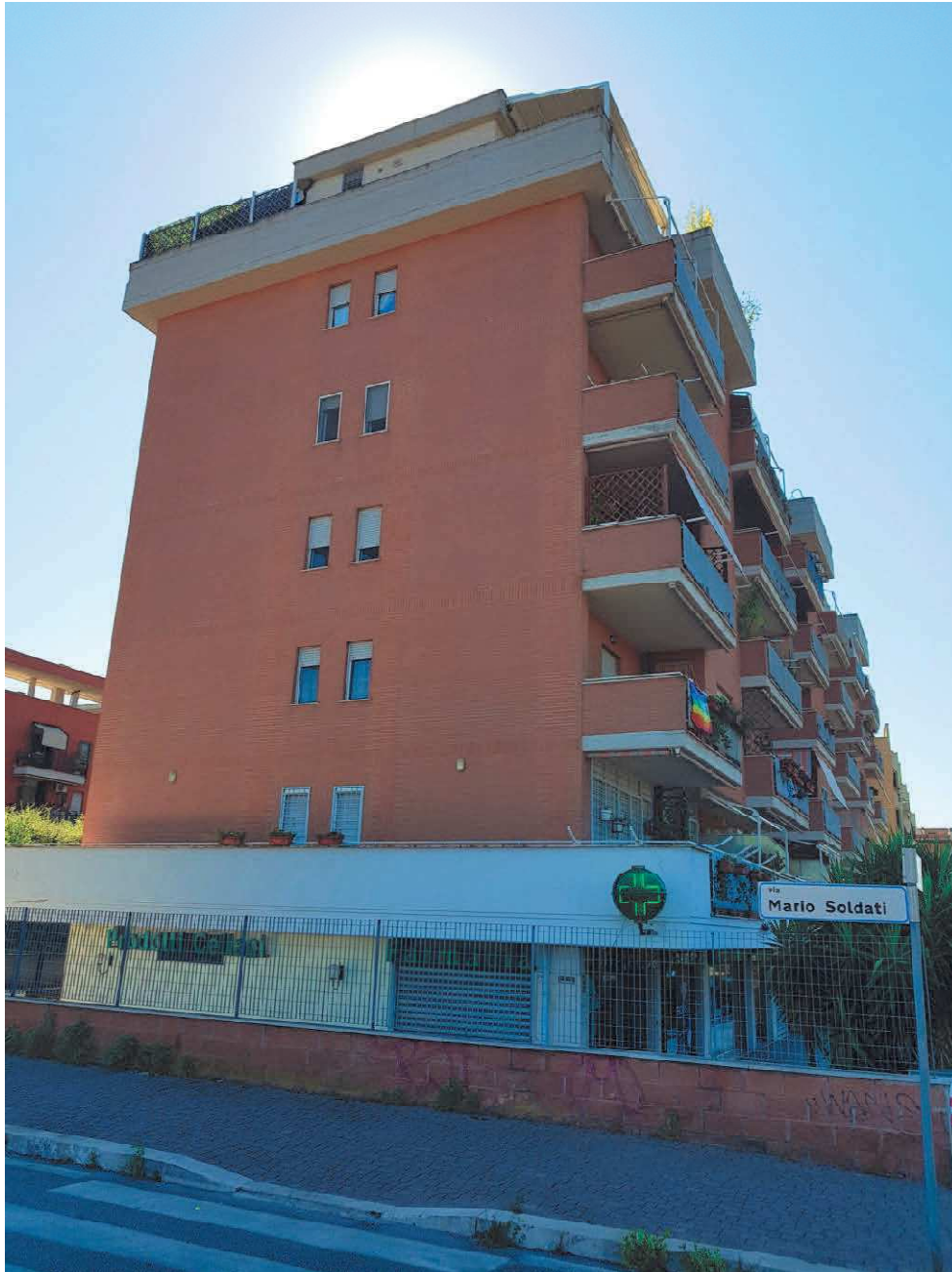
Vista esterna dell'edificio da Via Soldati
