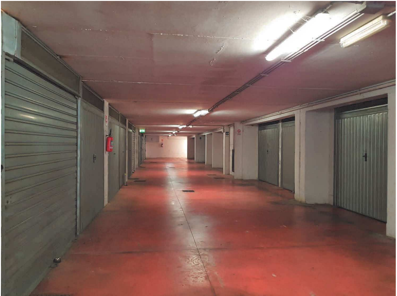
Corsello per accesso al locale garage particella 777 sub 52
